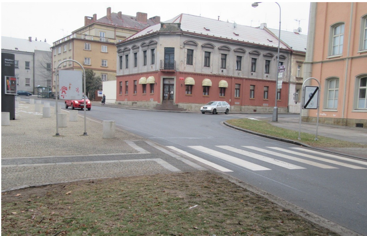
Obrázek 1: Začátek úseku ve směru staničení. Přechod pro chodce umístěn mezi budovami základní školy Školní náměstí je navržen v šířce 5m.
