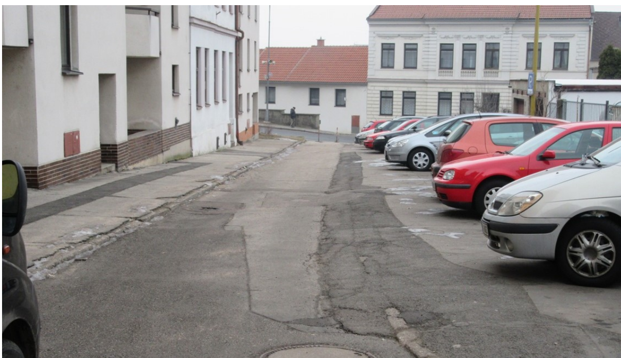
Obrázek 12: Ulice Svěchyňova proti směru staničení. Pohled od křižovatky s Tyršovým náměstím. Po pravé straně bude navrženo šikmé parkovací stání a výjezd od přilehlých garáží.
