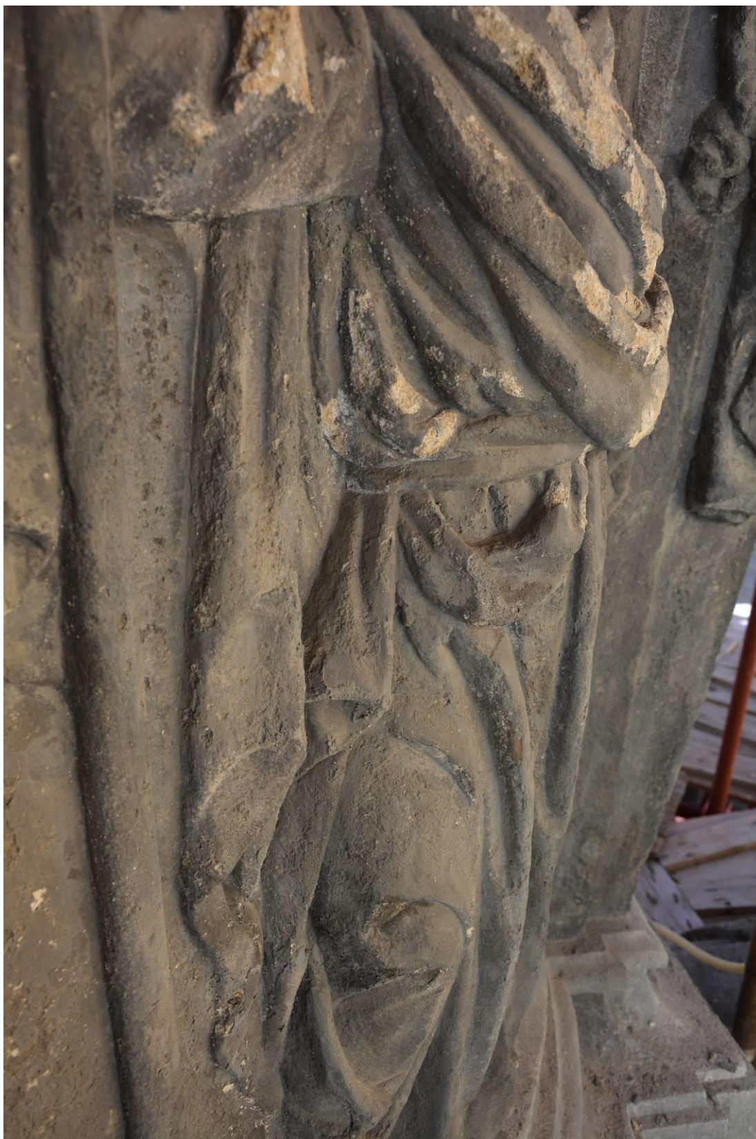
Obr. 172 Reliéf sv. Jakuba – průběh odstraňování starých vysprávek
