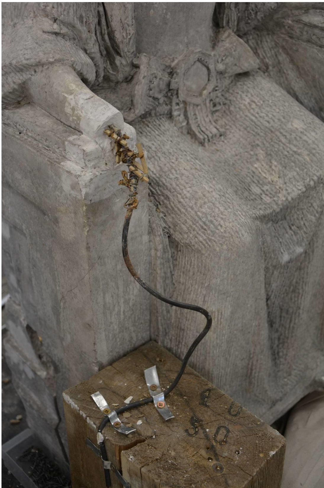
Obr. 113 Socha alegorie průmyslu – vnější opěrná armatura
