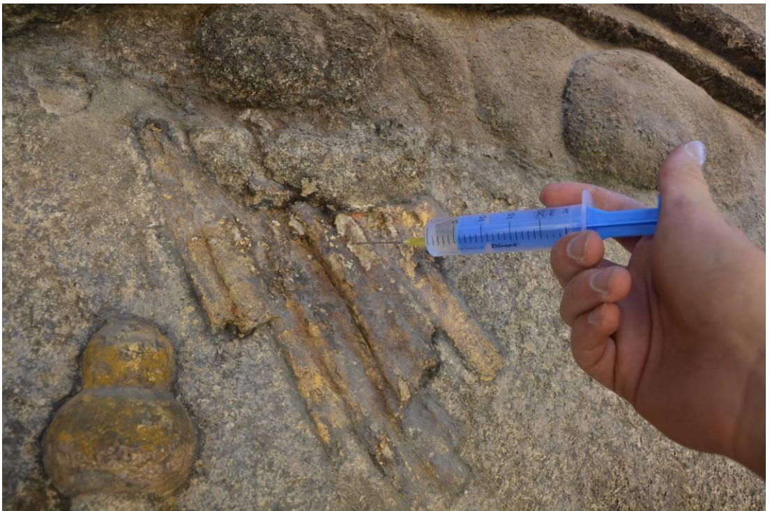
Obr. 183 Reliéf sv. Jakuba – zpevnění
