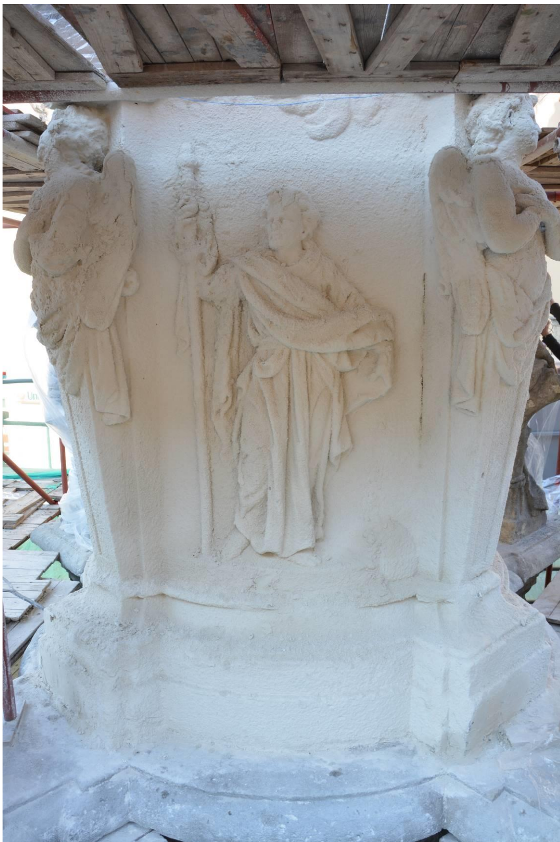
Obr. 190 Reliéf sv. Jakuba – Odsolovací zábal
