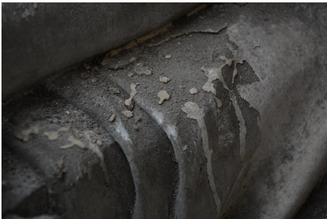
Obr. 97 Socha alegorie umění – cizí látky + degradovaný povrch
