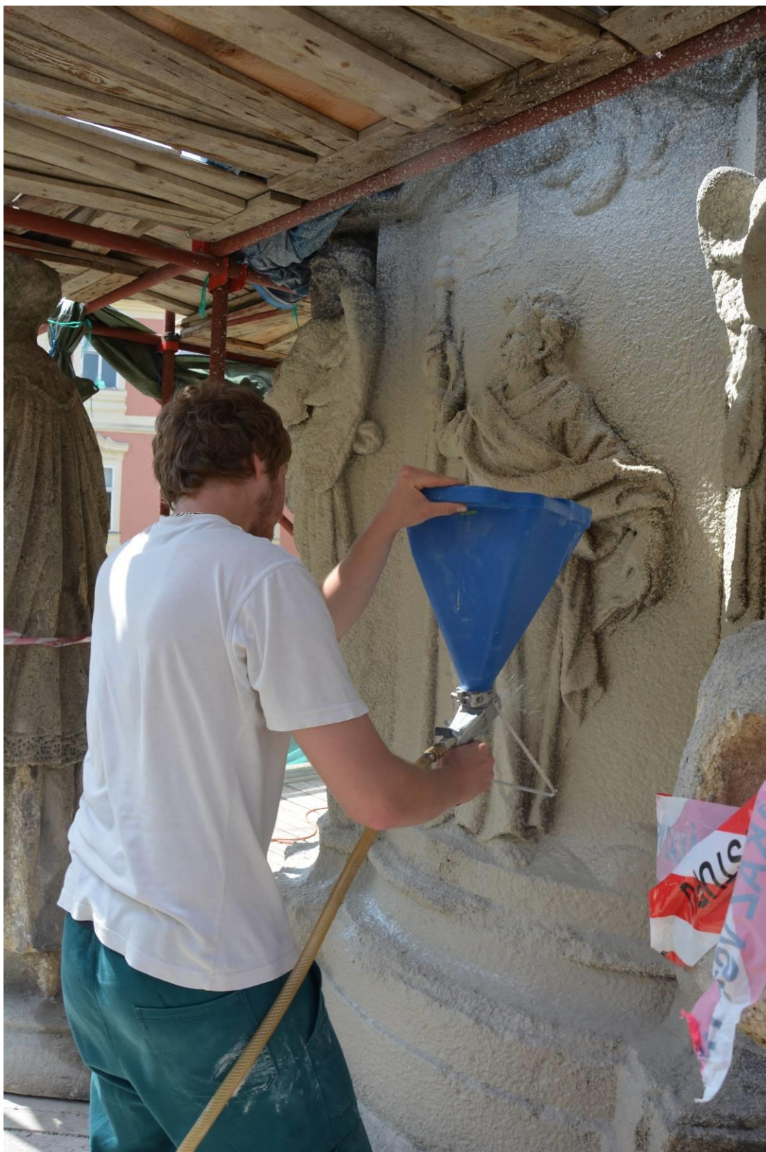
Obr. 189 Reliéf sv. Jakuba – nanášení prvního zábalu pomocí tlakové pistole
