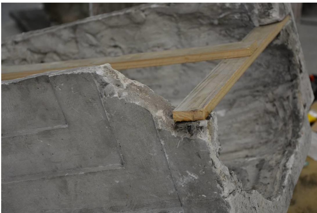
Obr. 132 Socha alegorie umění – dřevěná výztuž
