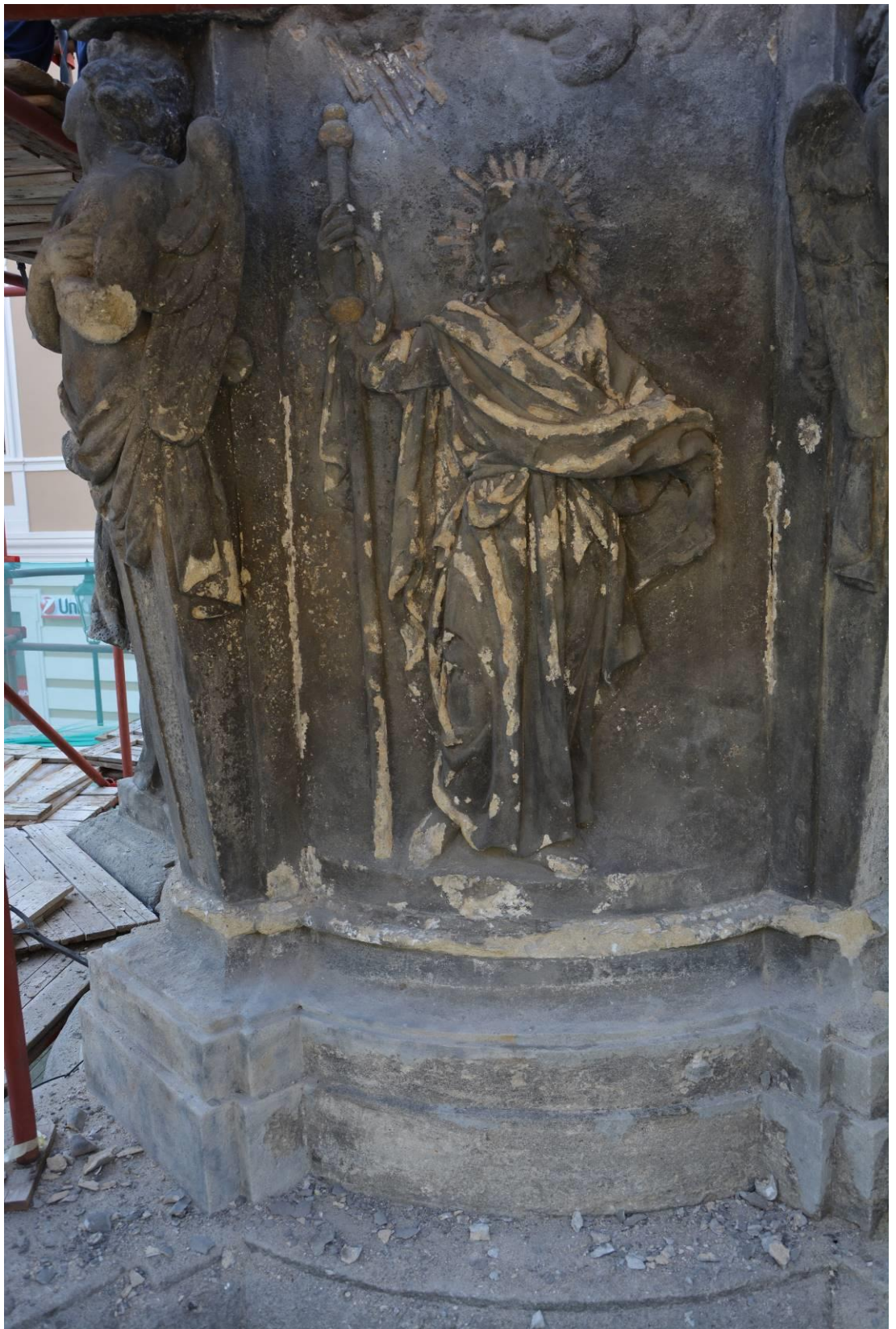
Obr. 173 Reliéf sv. Jakuba – průběh odstraňování starých vysprávek
