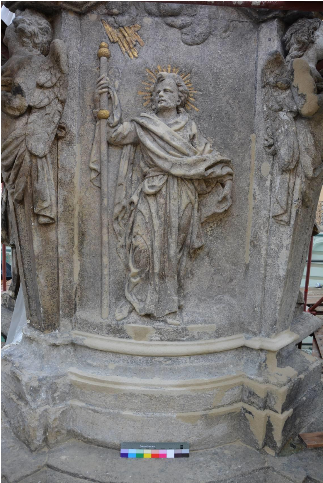
Obr. 197 Reliéf sv. Jakuba – stav po vytmelení
