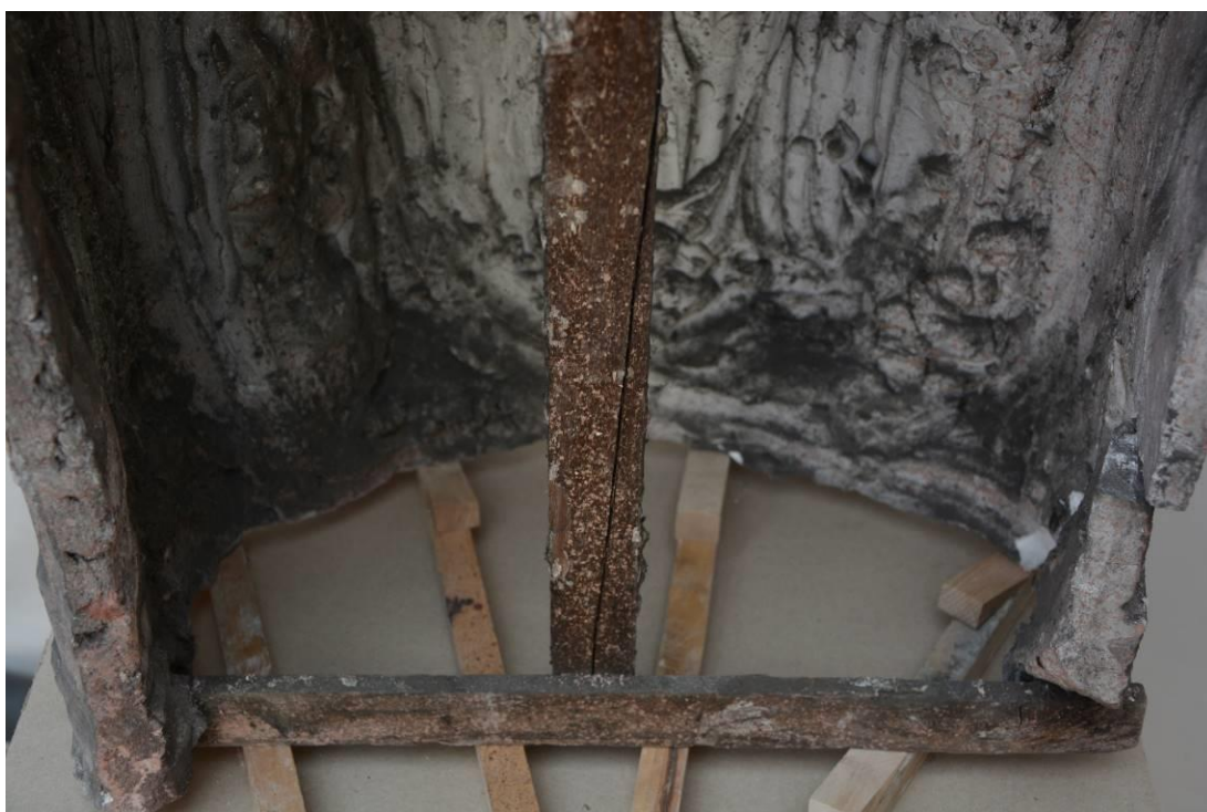
Obr. 83 Socha alegorie průmyslu – prasklá výztuž na zadní straně
