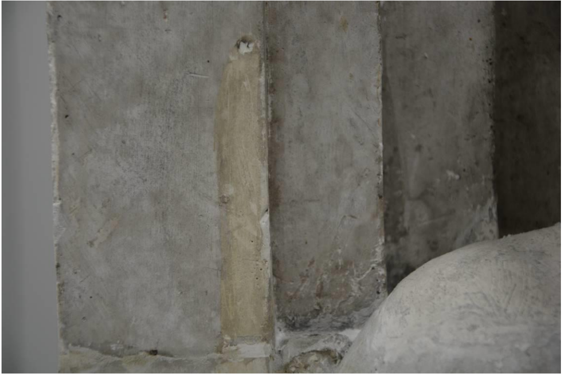
Obr. 108 Socha alegorie umění – po očištění zábalem
