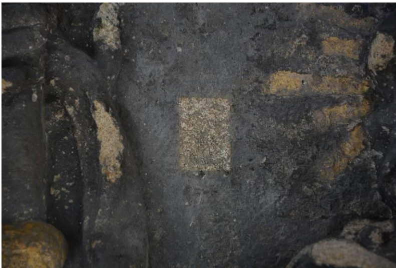
Obr. 46 Reliéf sv. Jakuba – Zkouška čištění plocha reliéfu – slité tmavé krusta
