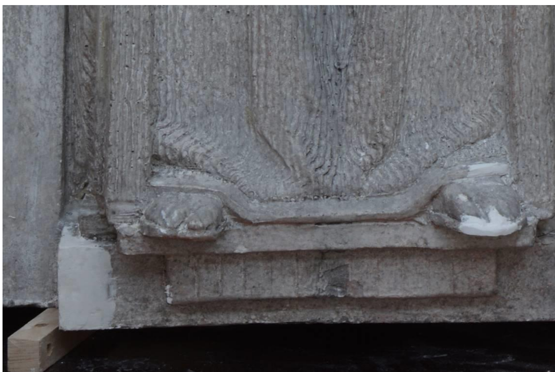
Obr. 141 Socha alegorie průmyslu – ukázka plastické retuše
