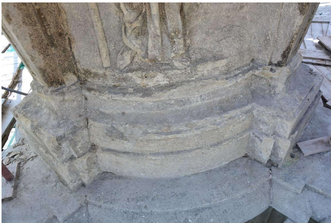
Obr. 195 Reliéf sv. Jakuba – stav před tmelením
