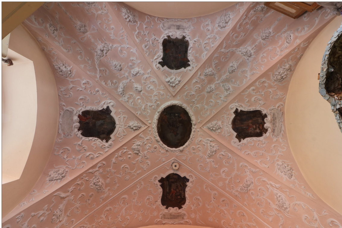
Obr. 47 Celkový pohled - klenba severní oratoře
