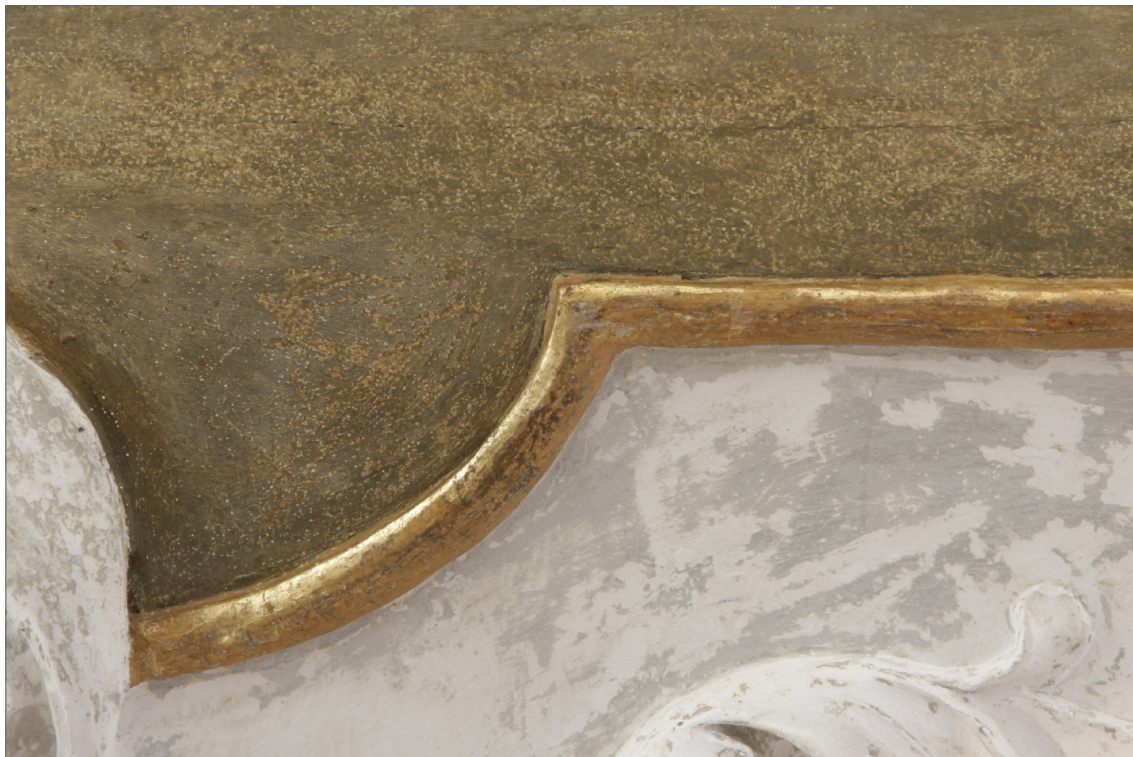
Obr. 36 Stav zlaceného rámu po provedení restuše.
