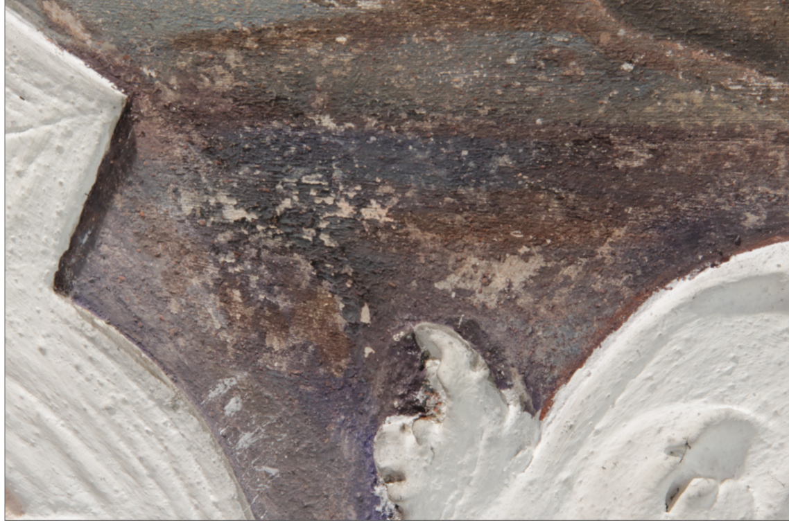
Obr. 52 Průzkum v umělém bočním nasvícení. Na malbě se nachází opadávající originální barevné vrstvy.
