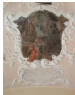
Obř. 1-3: kostel Nanebevzetí Panny Marie, pohled na klenbu severní oratoře, výjevy SO2 a SO5. Foto: ANM, FR, UPa.
