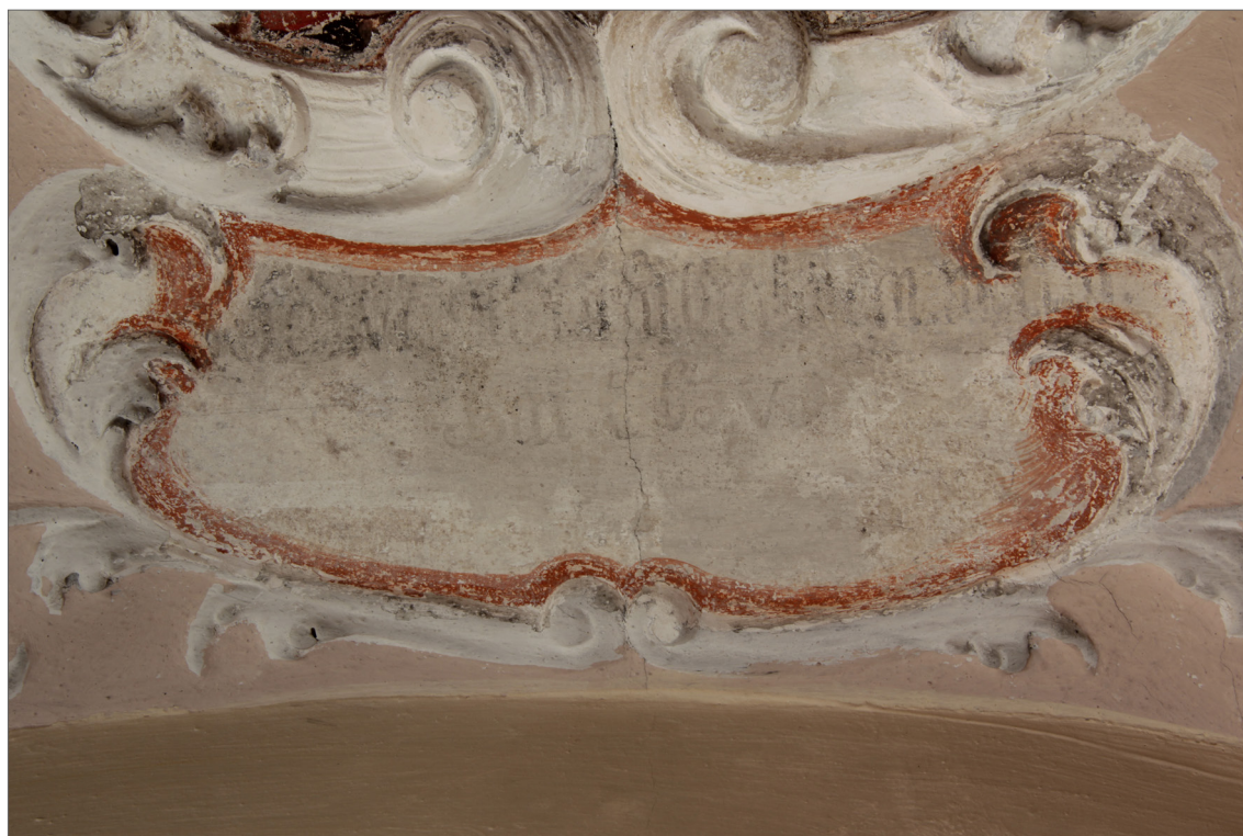
Obr. 56 Stav textového pole po odstranění druhotných vrstev.
