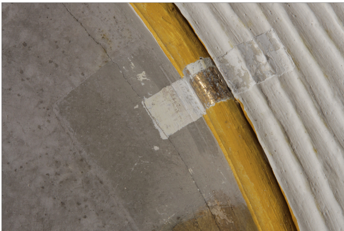
Obr. 14 Stratigrafická sonda zlaceného rámu výjevu. Vrstva 0 - bílá podkladová vrstva, vrstva 1 - zlacení rámu, vrstva 2 - silnější bílá vrstva, vrstva 3 - slabý lazurnější okrový nátěr.
