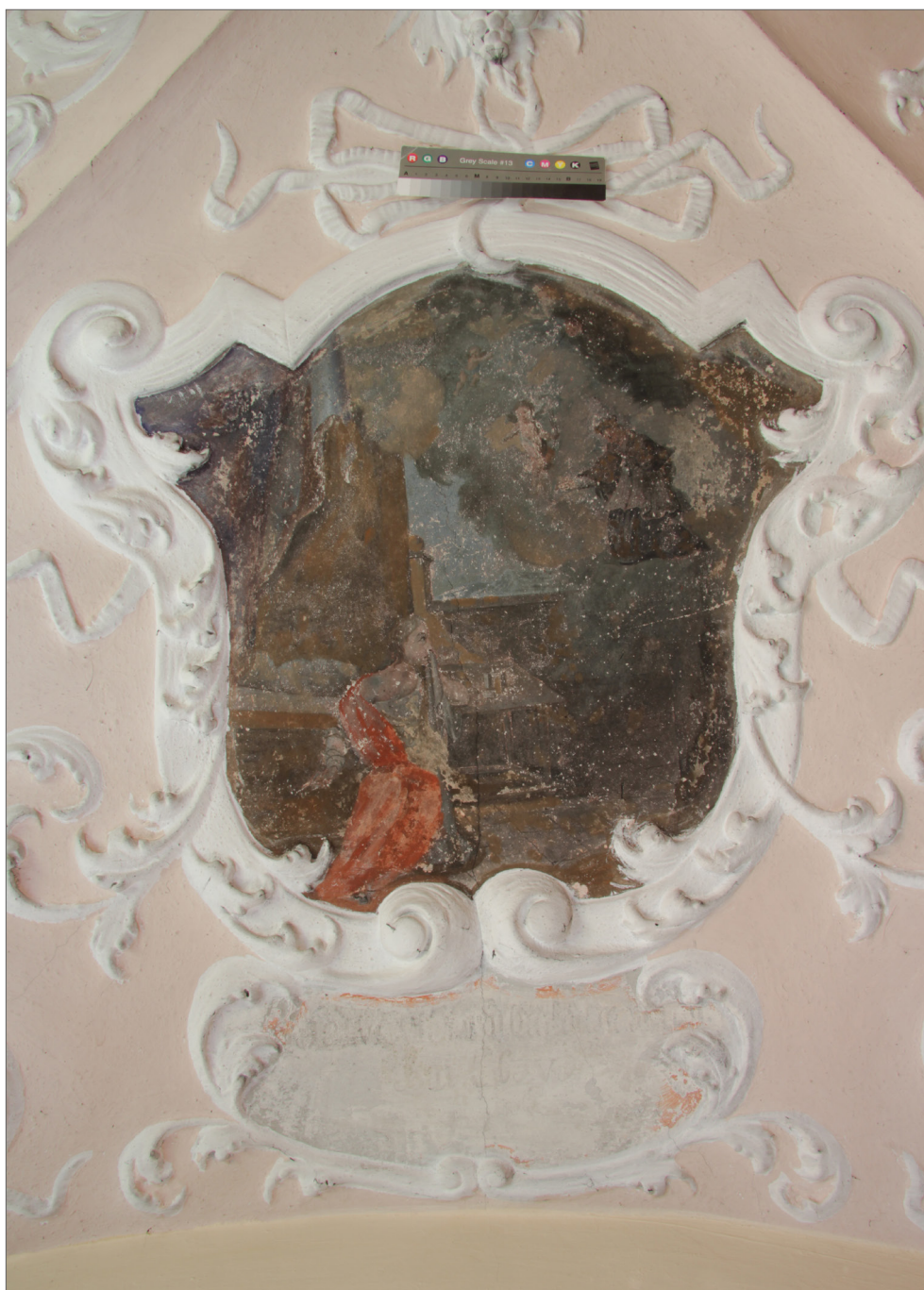
Obr. 48 Celkový pohled - stav před započítím restaurátorského zásahu.
