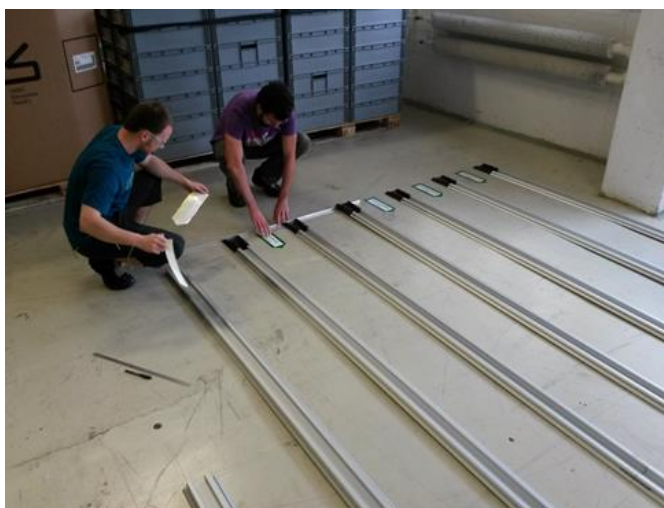
Obrázek 18 Instalace drah při zavádění supermarketu
