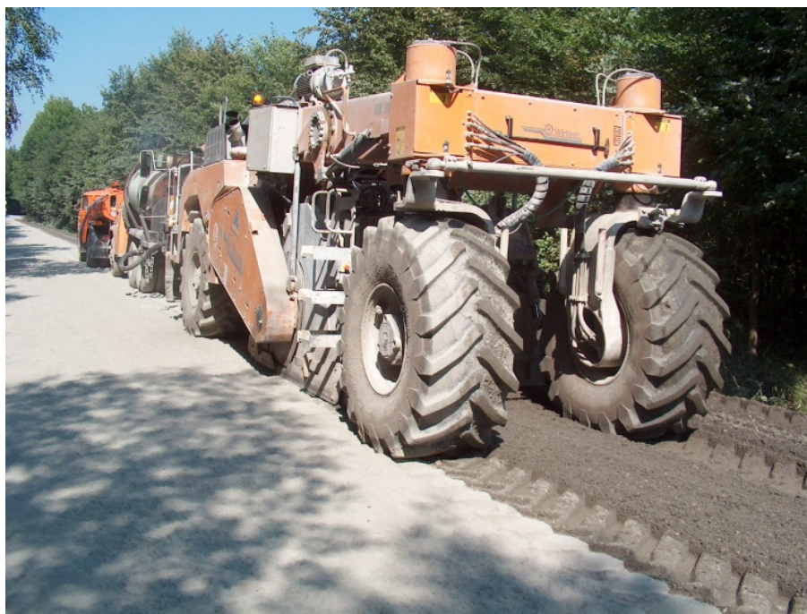
Obrázek 2 - Recyklace za studena na místě recyklérem WR 2000. Foto autor
