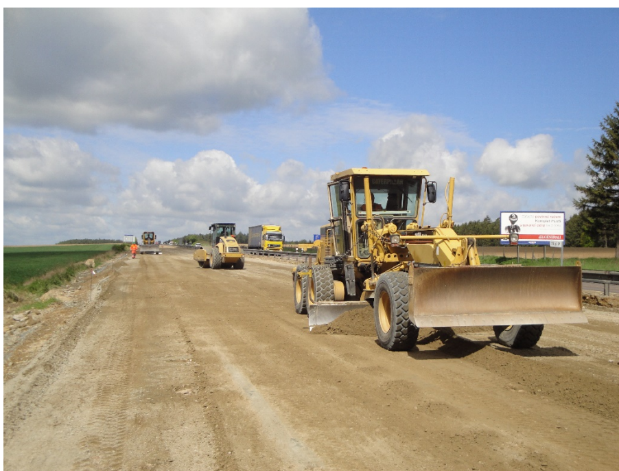
Obrázek 19 - Urovnání a zhutnění vrstvy dvěma sestavami strojů [12]
