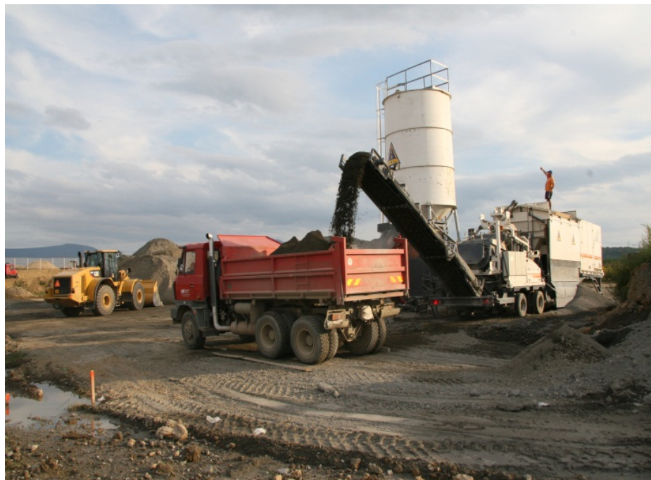
Obrázek 1 - Recyklace za studena v mobilním míchacím centru KMA 200. Foto autor
