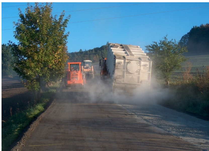
Obrázek 8 - Dávkování cementu dávkovačem DSP 240 na podvozku Tatra 815. Foto autor
