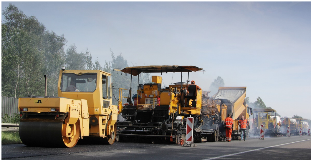
Obrázek 5 - Recyklace za horka na místě Remixerem RX 4500 [12]
