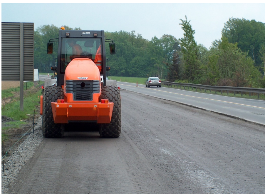
Obrázek 11 - Hutnění recyklované vrstvy tahačovým válcem HAMM 3520. Foto autor
