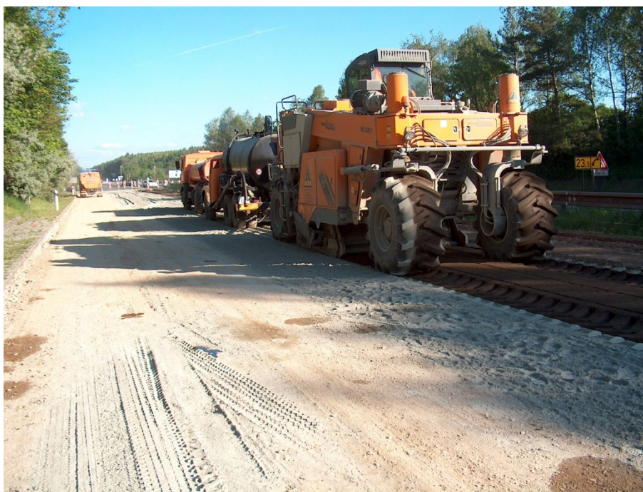
Obrázek 9 - Recyklace s kombinovaným pojivem, Recyklér WR 2500. Foto autor
