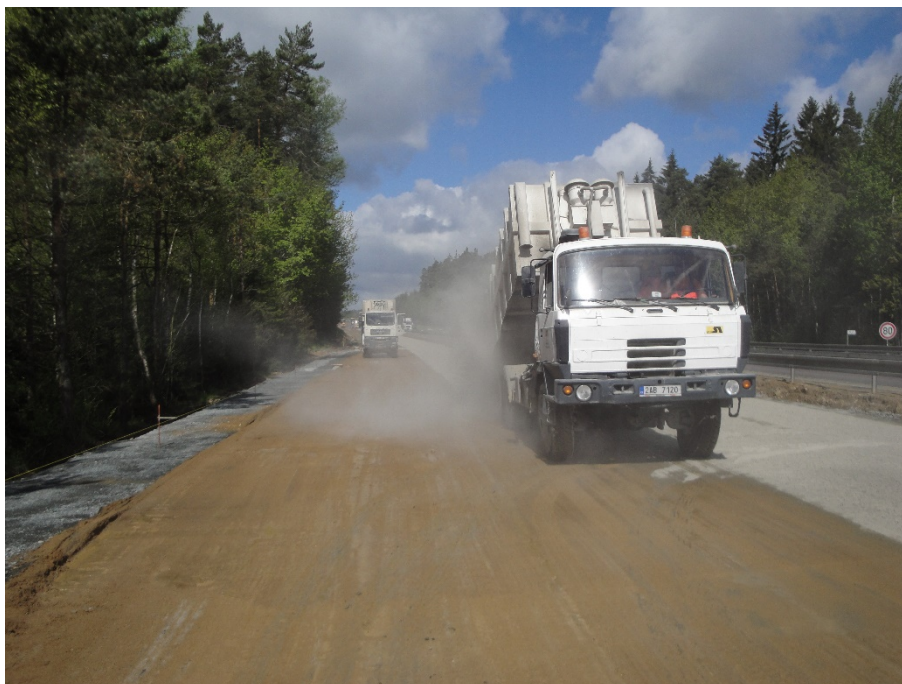
Obrázek 17 - Dávkování cementu CEM II B-S 32,5 R [12]
