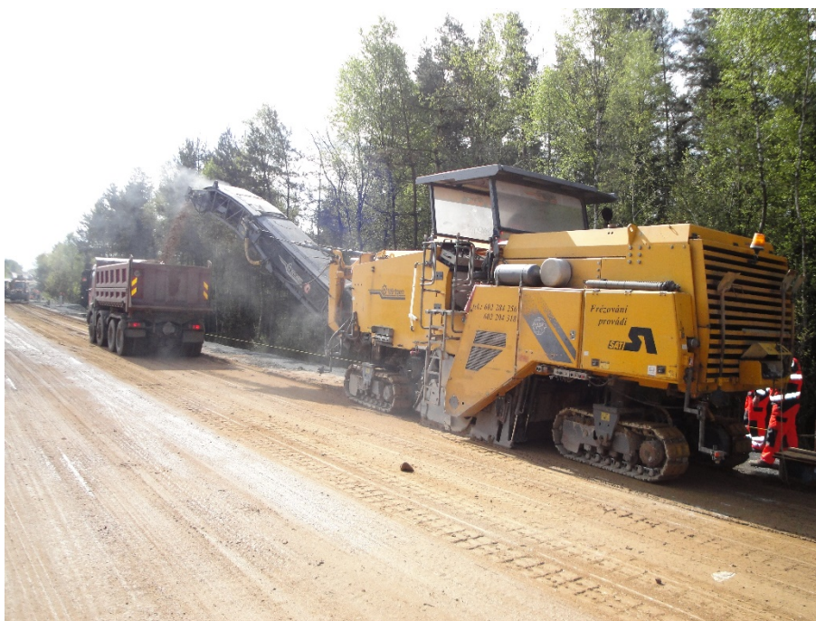
Obrázek 16 - Frézování cementové stabilizace do stanovených výšek frézou W2000 [12]
