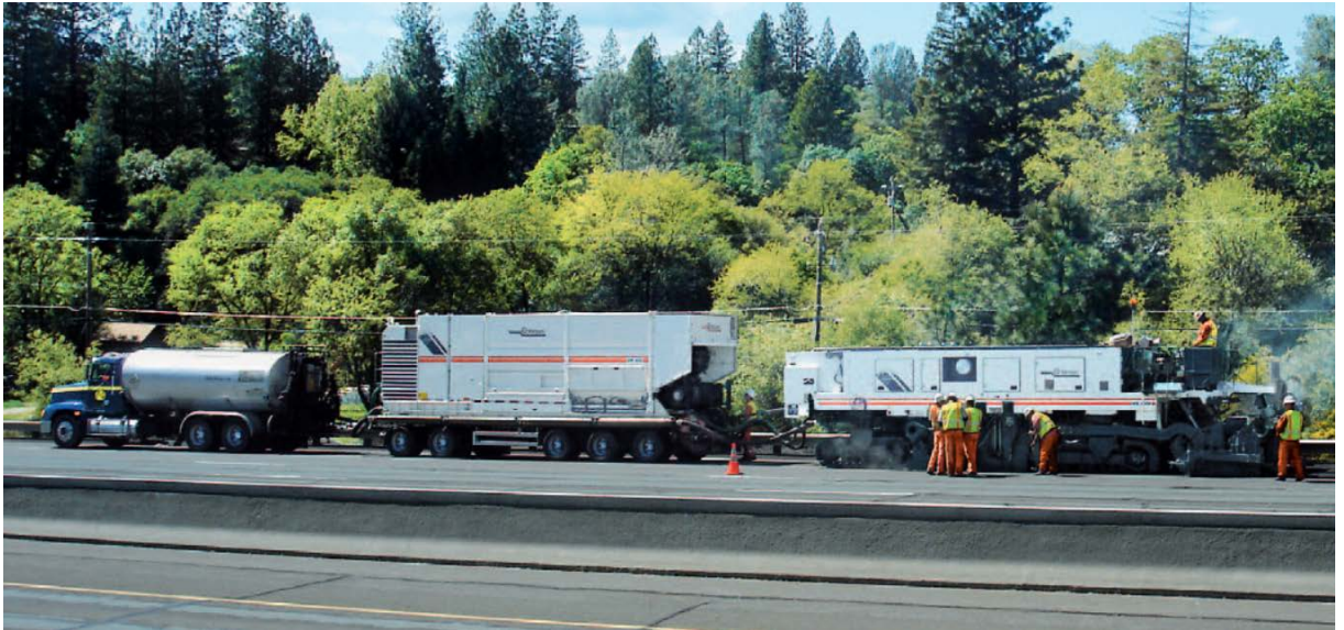
Obrázek 14 - Strojní sestava pro recyklaci za studena s recyklérem WR 4200 [17]
