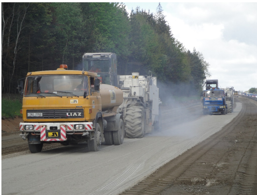
Obrázek 18 - Recyklace dvěma strojními sestavami [12]
