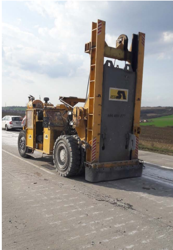
Obrázek 15 - Segmentace CB krytu strojem BTZ. Foto autor
