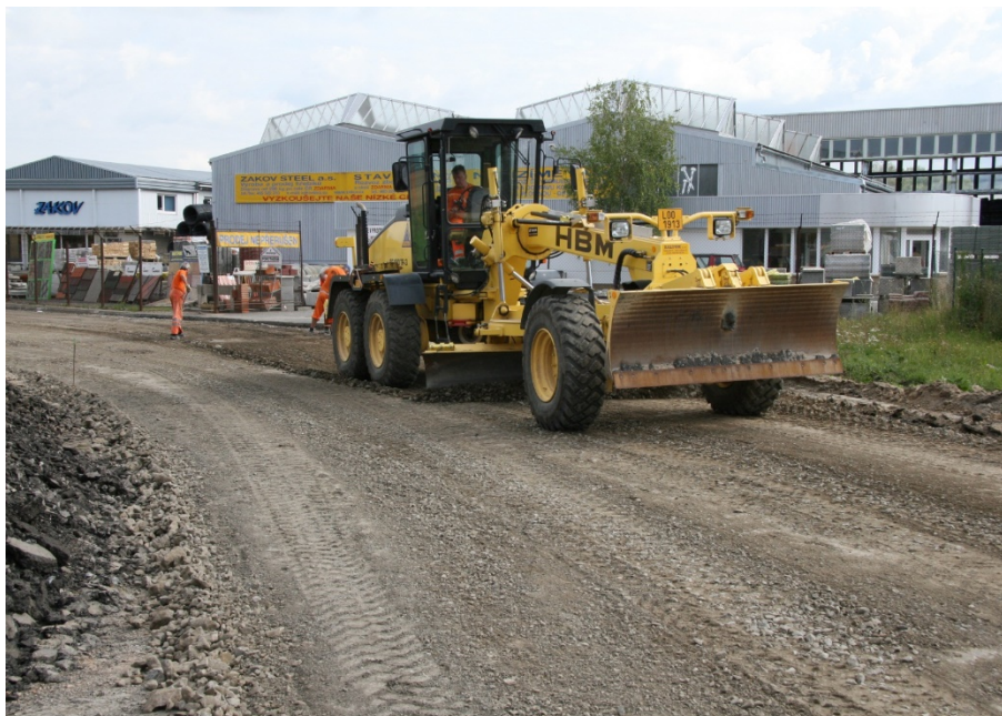
Obrázek 10 - Urovnání recyklované vrstvy grejdrem HBM 190 TA3. Foto autor
