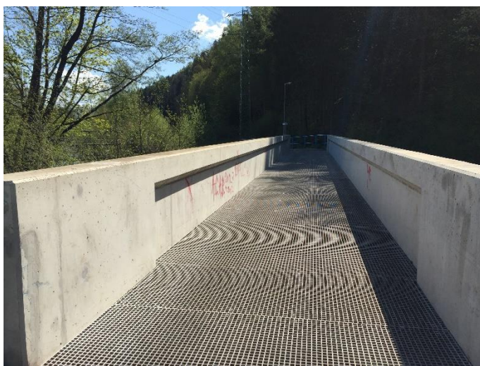
Obrázek 2: Mostní objekt na cyklostezce v části Poříčí
