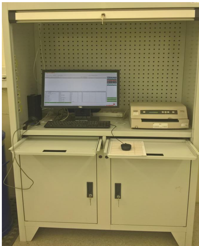
Obrázek 20 Vybavení evidenčního bodu JZK Kvasiny
