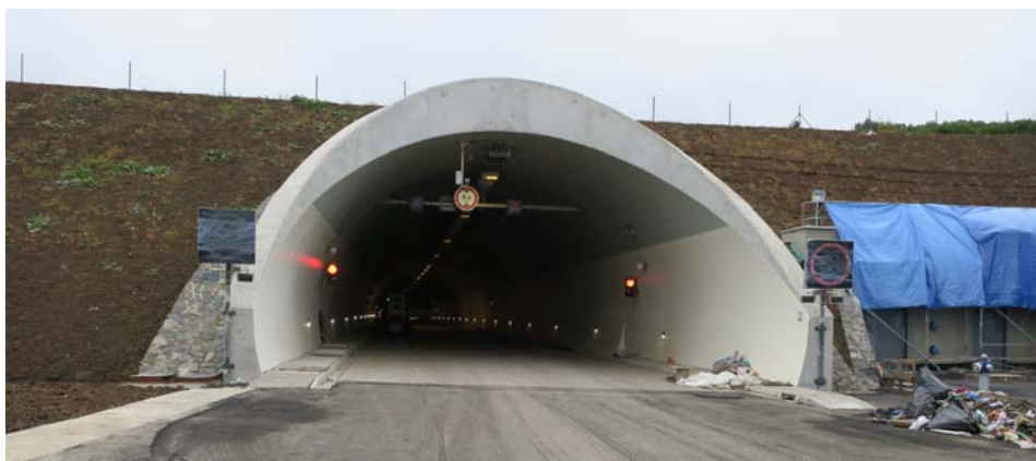
Obr. 14 Ústecký portál, LTT a PTO
