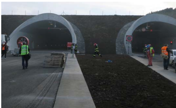
Obr. 16 Zatravněná plocha před Ústeckým portálem
