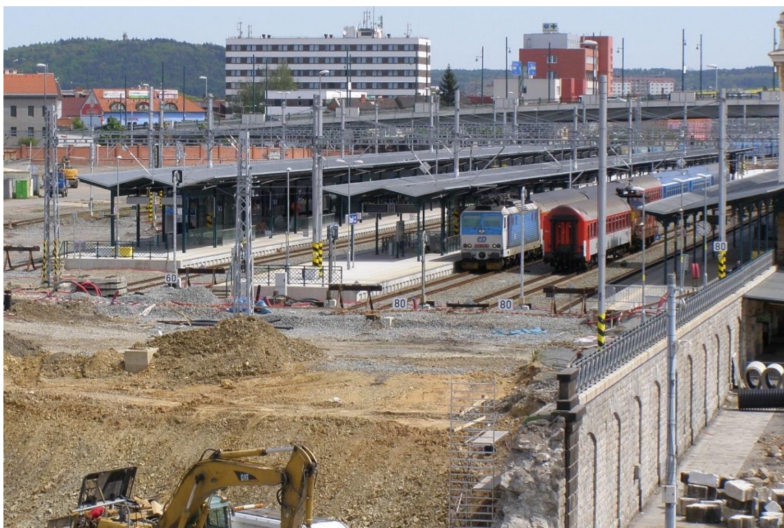
Obrázek 14 Stavební práce s hotovou částí kolejiště v prostoru nástupišť
