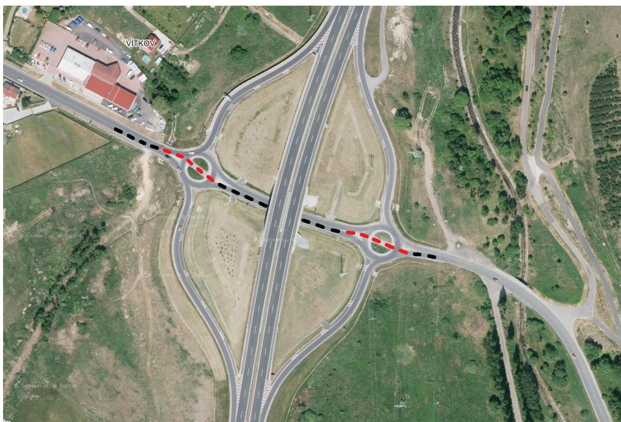
Obrázek 31 Dálniční uzel na dálnici D6 Exit 143 Zdroj: (8), upraveno autorem
