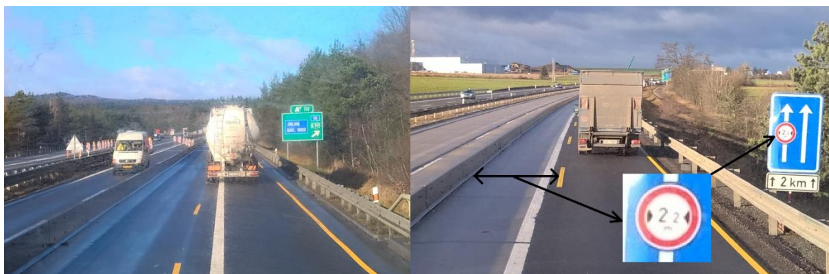
Obrázek 12 Uspořádání dopravy při rekonstrukci
