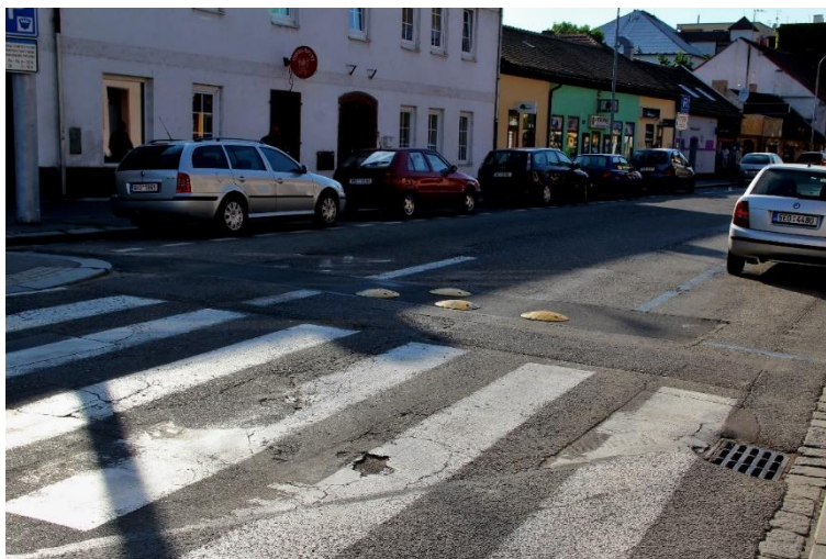
Obrázek 25: Špatné umístění zpomalovacích polštářů
