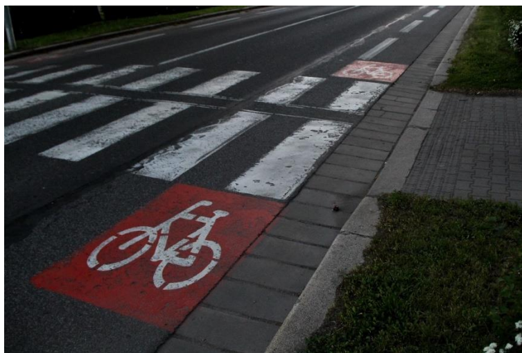
Obrázek 35: Příklad vedení vyhrazených jízdnicích pruhů pro cyklisty v prostoru přechodu pro chodce
