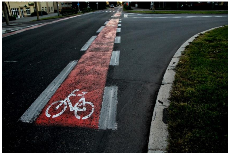
Obrázek 34: Příklad vedení vyhrazených jízdnicích pruhů pro cyklisty v prostoru křižovatky
