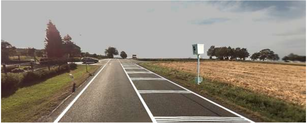
Obrázek 32 Návrh dopravně kritického místa s použitím radarového měřiče Ramer 10 P Zdroj: (6), úprava autor
