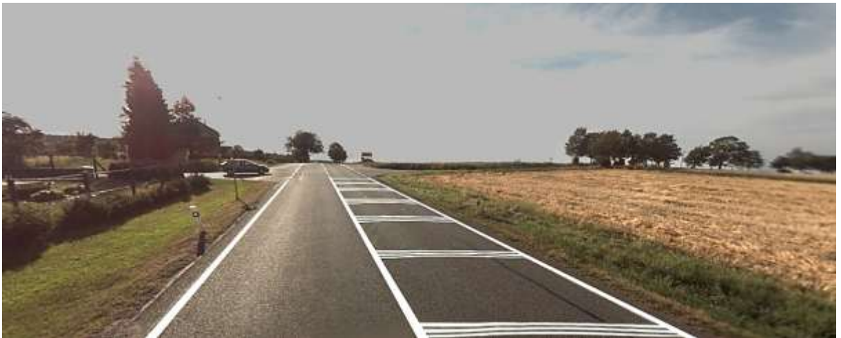
Obrázek 31 Návrh dopravně kritického místa s použitím optické psychologické brzdy
