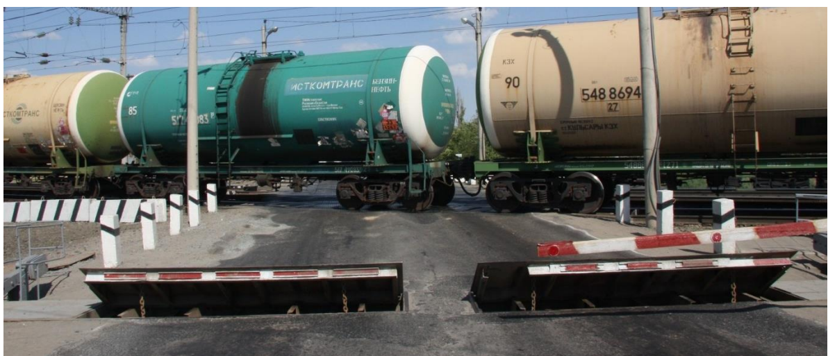
Obrázek 4: Aplikace silniční bariéry [10]
