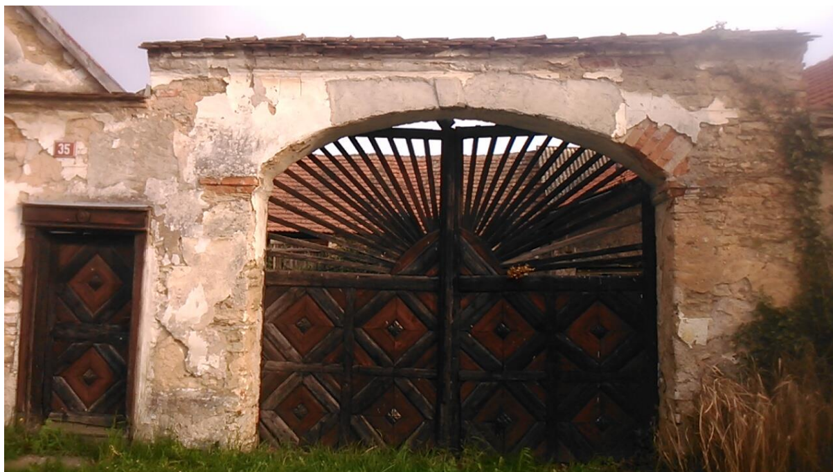
Obrázek č. 10: dům čp. 35, detail vjezdové brány s dřevěnou konstrukcí vrat a dveří, foto Tomáš Louman, 2016
