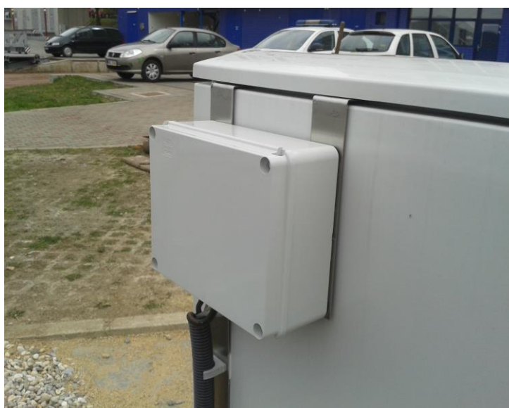
Obr. 2.36 – Umístění bezdrátového modulu na břehu
