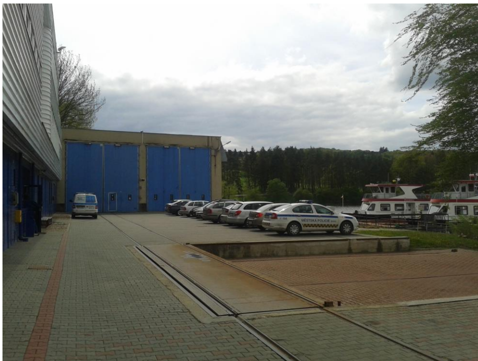
Obr. 2.1 – Pohled na přístaviště
