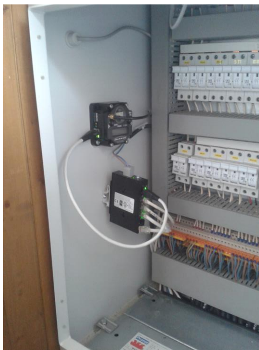
Obr. 2.35 – Umístění bezdrátového modulu na lodi
