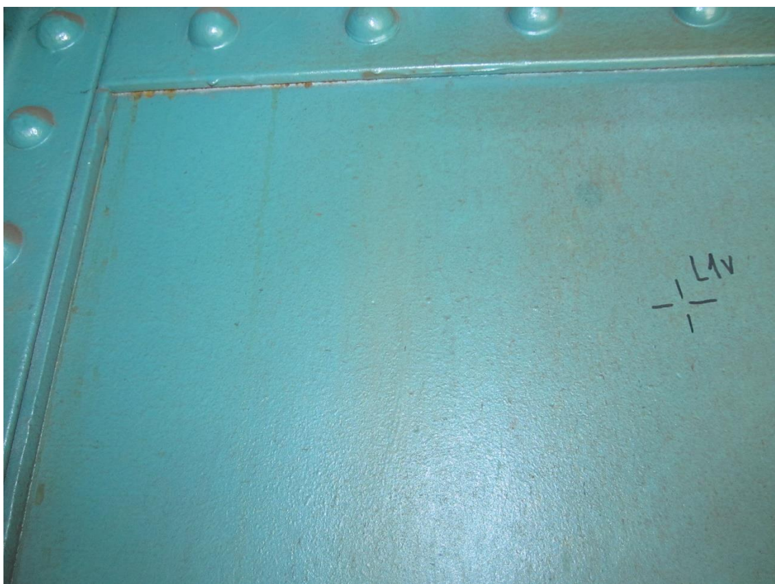
Fotografie 9 - měřený bod L1v (tloušťka nátěru)
