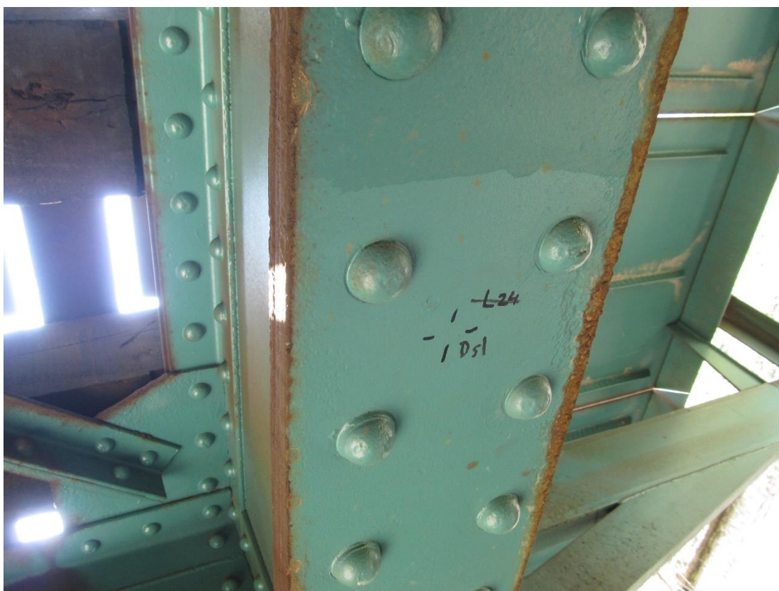
Fotografie 13 - měřený bod Dsl (tloušťka nátěru)
