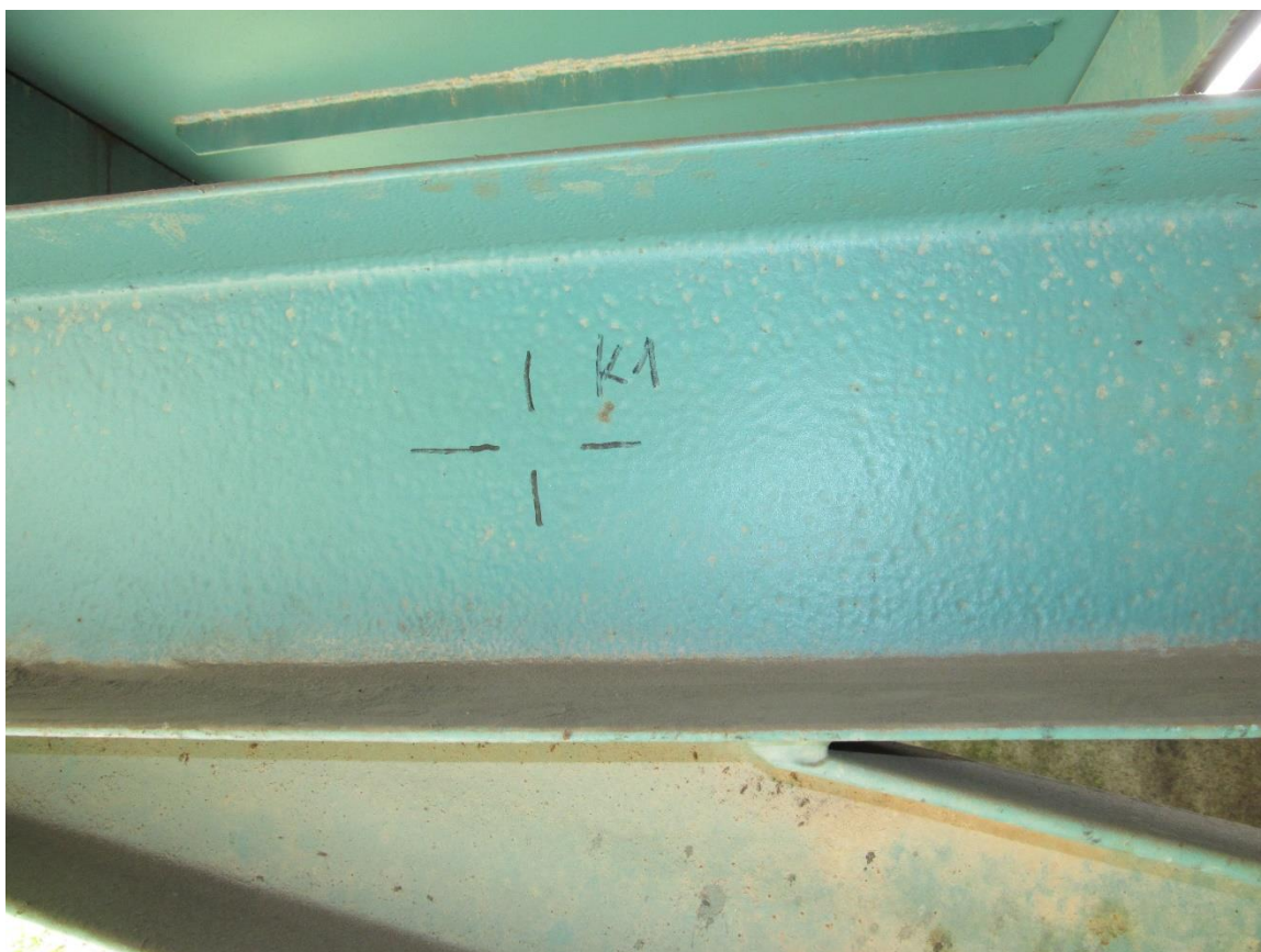
Fotografie 23 - měřený bod K1 (tloušťka nátěru)
