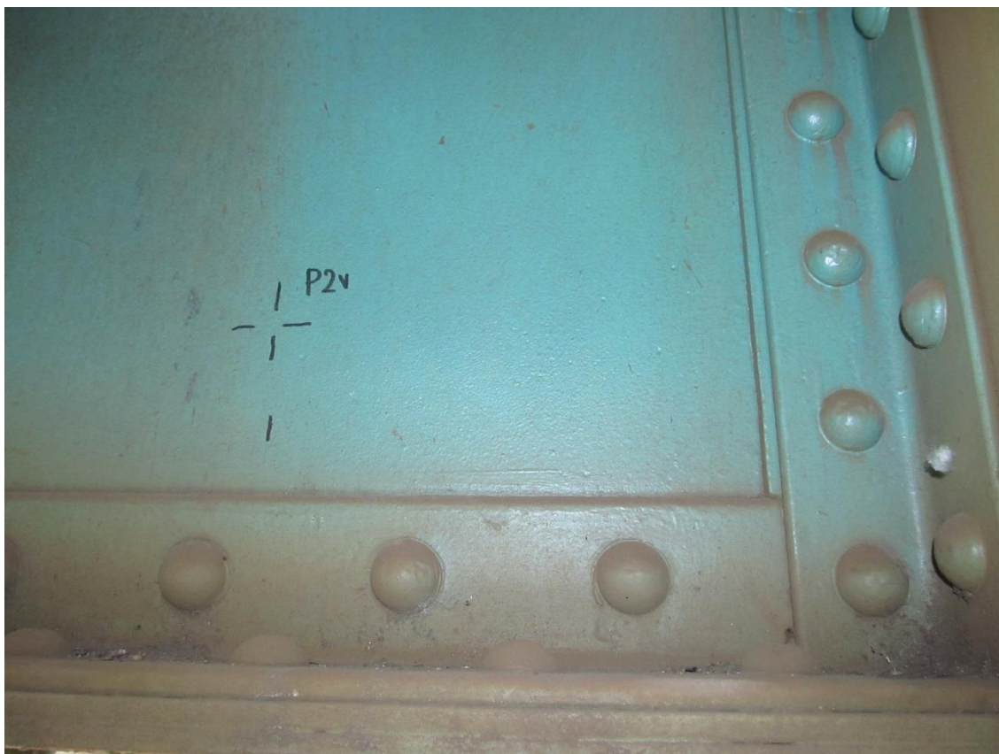
Fotografie 8 - měřený bod P2v (tloušťka nátěru)
