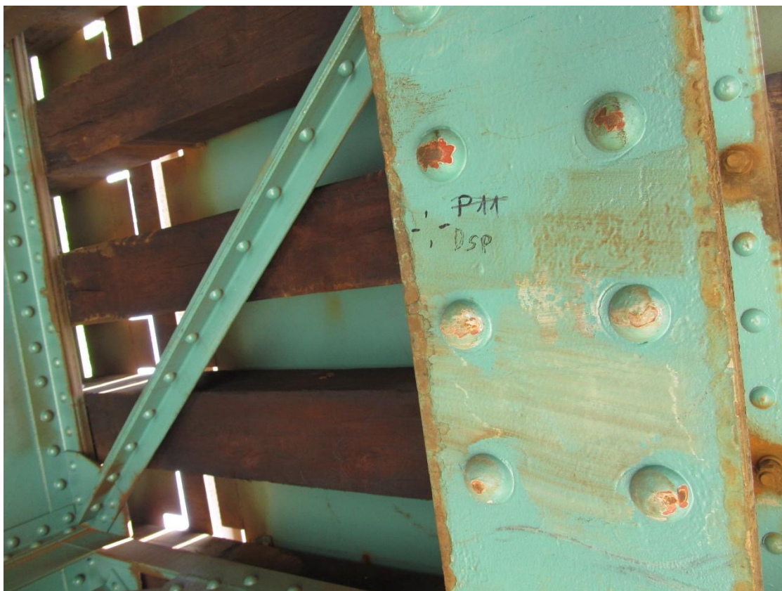
Fotografie 12 - měřený bod Dsp (tloušťka nátěru)
