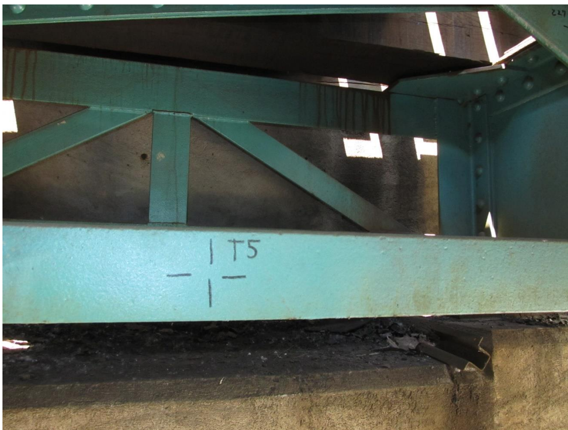
Fotografie 27 - měřený bod T5 (tloušťka materiálu)
