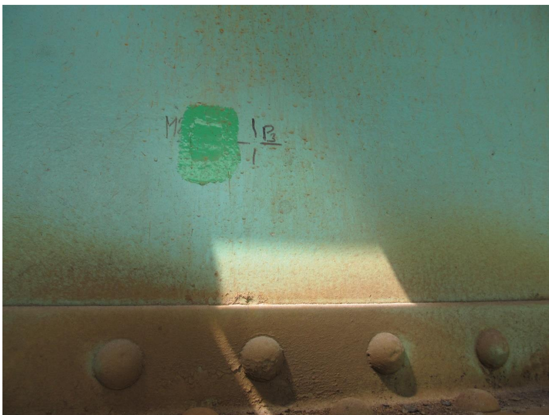
Fotografie 11 - měření bod P3 (tloušťka nátěru, tloušťka materiálu)
