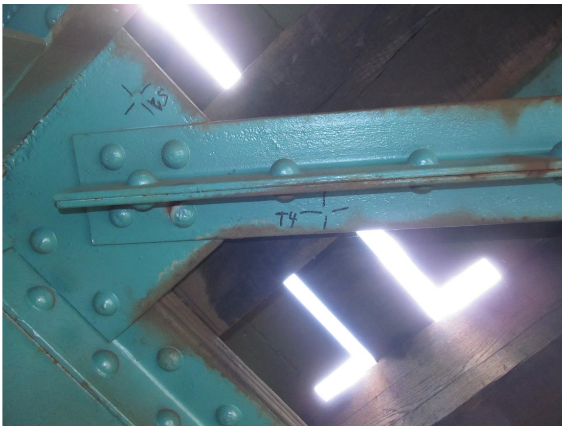
Fotografie 26 - měřený bod T4 (tloušťka materiálu)
