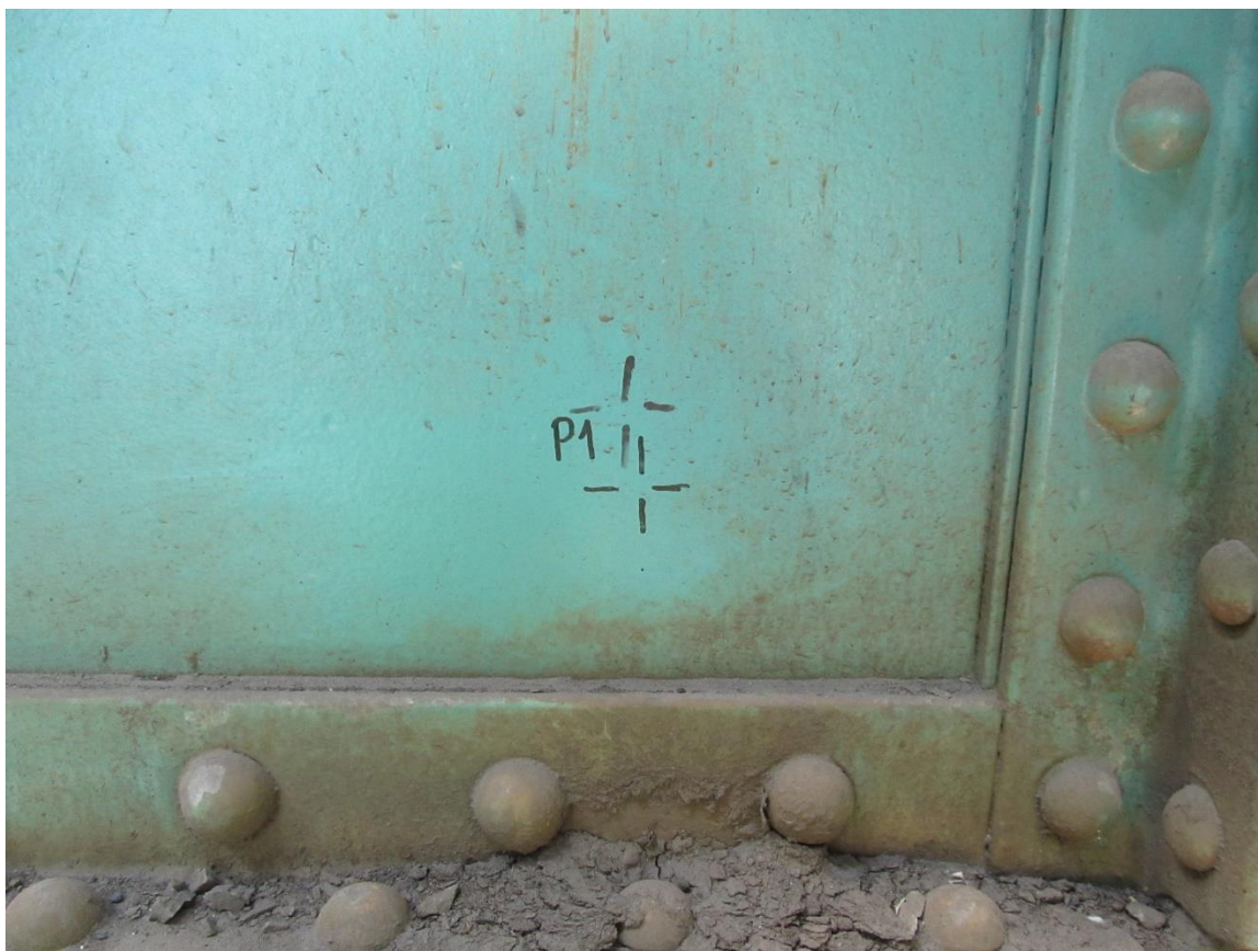
Fotografie 6 - měřený bod P1 (tloušťka nátěru)
