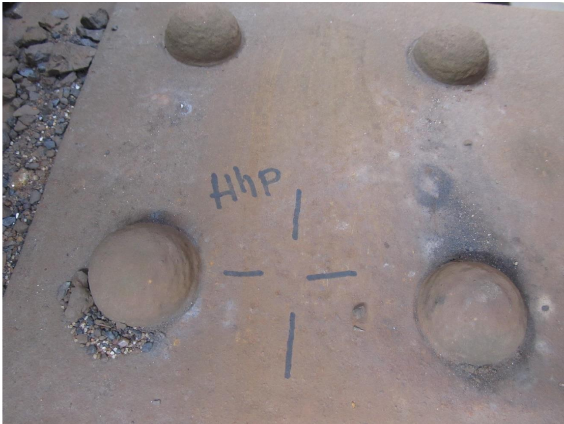
Fotografie 7 - měřený bod Hhp (tloušťka nátěru)
