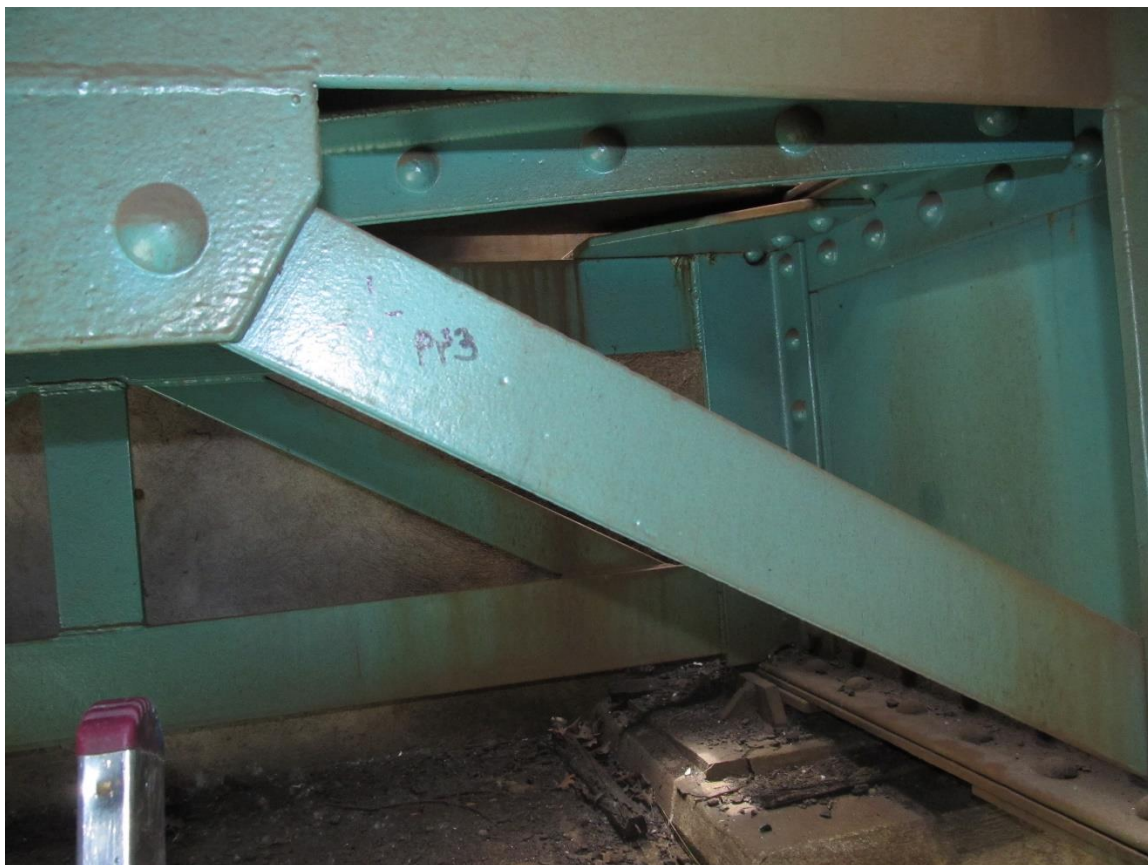
Fotografie 21 - měřený bod Pr3 (tloušťka nátěru)
