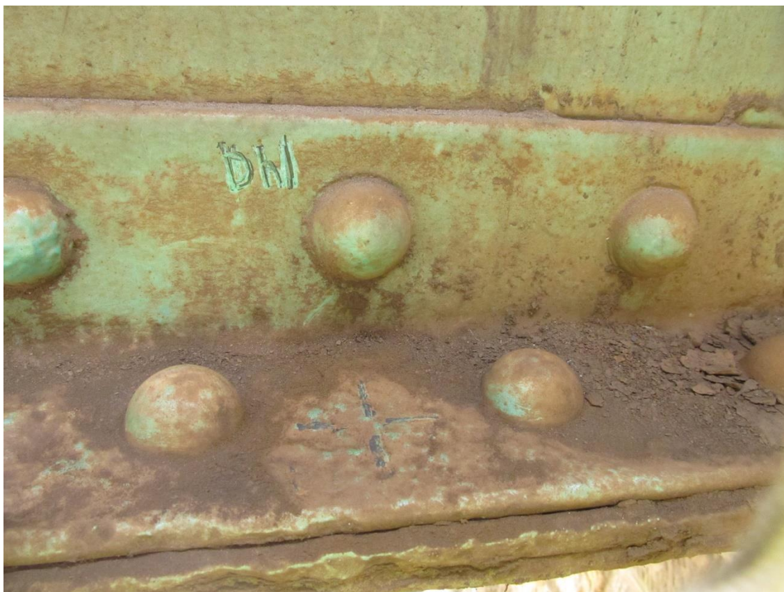
Fotografie 10 - měřený bod Dhl (tloušťka nátěru)
