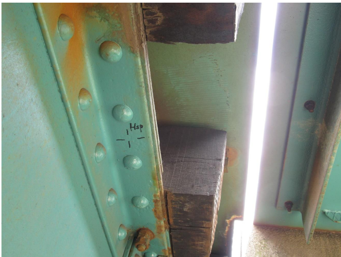
Fotografie 17 - měřený bod Hsp (tloušťka nátěru)
