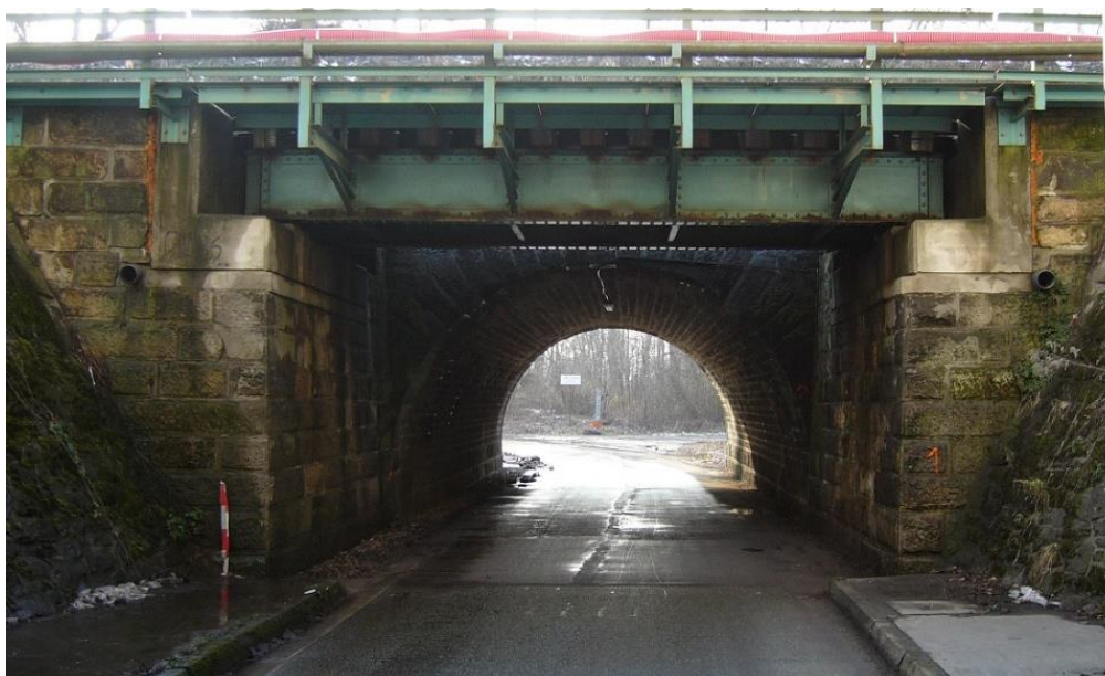
Obrázek 1: Pohled na mostní konstrukci zprava
