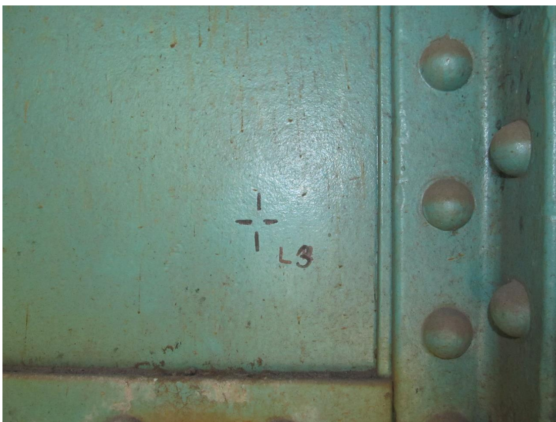
Fotografie 15 - měřený bod L3 (tloušťka nátěru, tloušťka materiálu)
