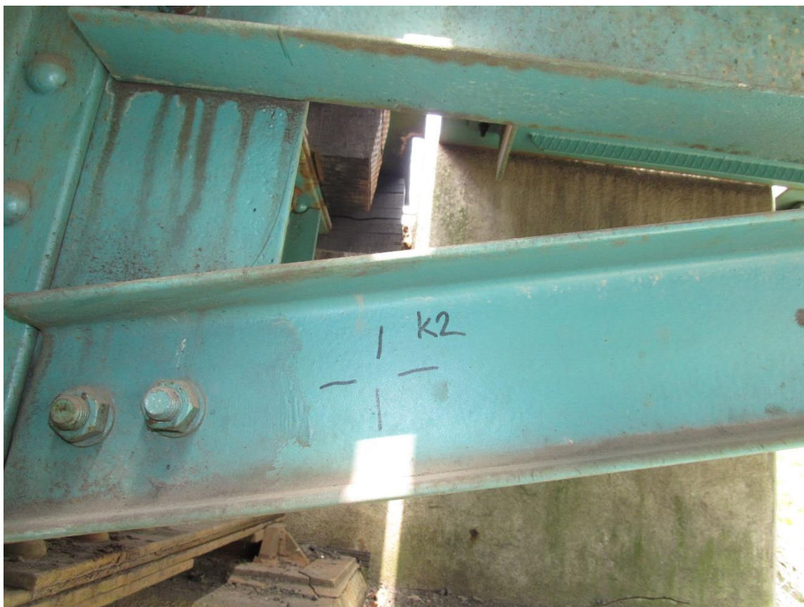
Fotografie 24 - měřený bod K2 (tloušťka nátěru)
