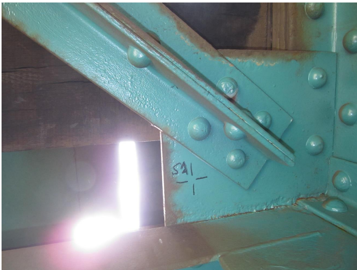
Fotografie 20 - měřený bod S1 (tloušťka nátěru)
