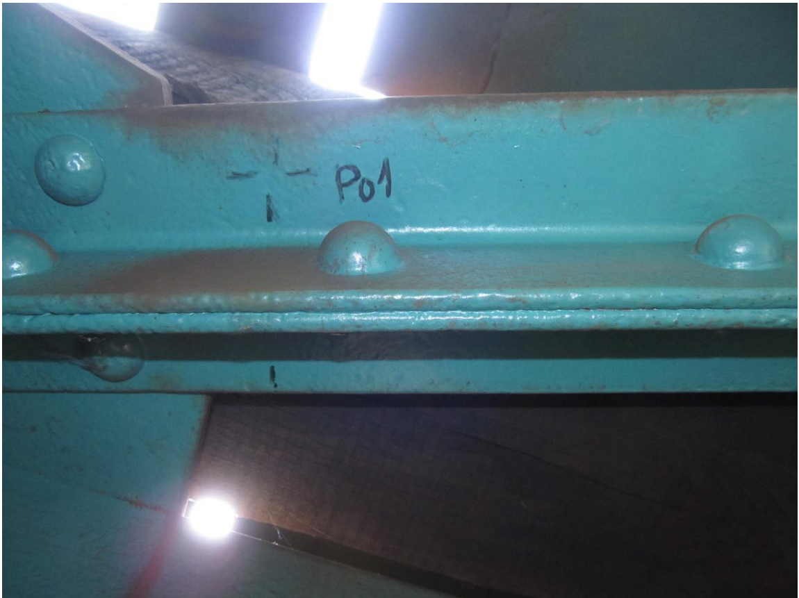
Fotografie 18 - měřený bod Po1 (tloušťka nátěru)
