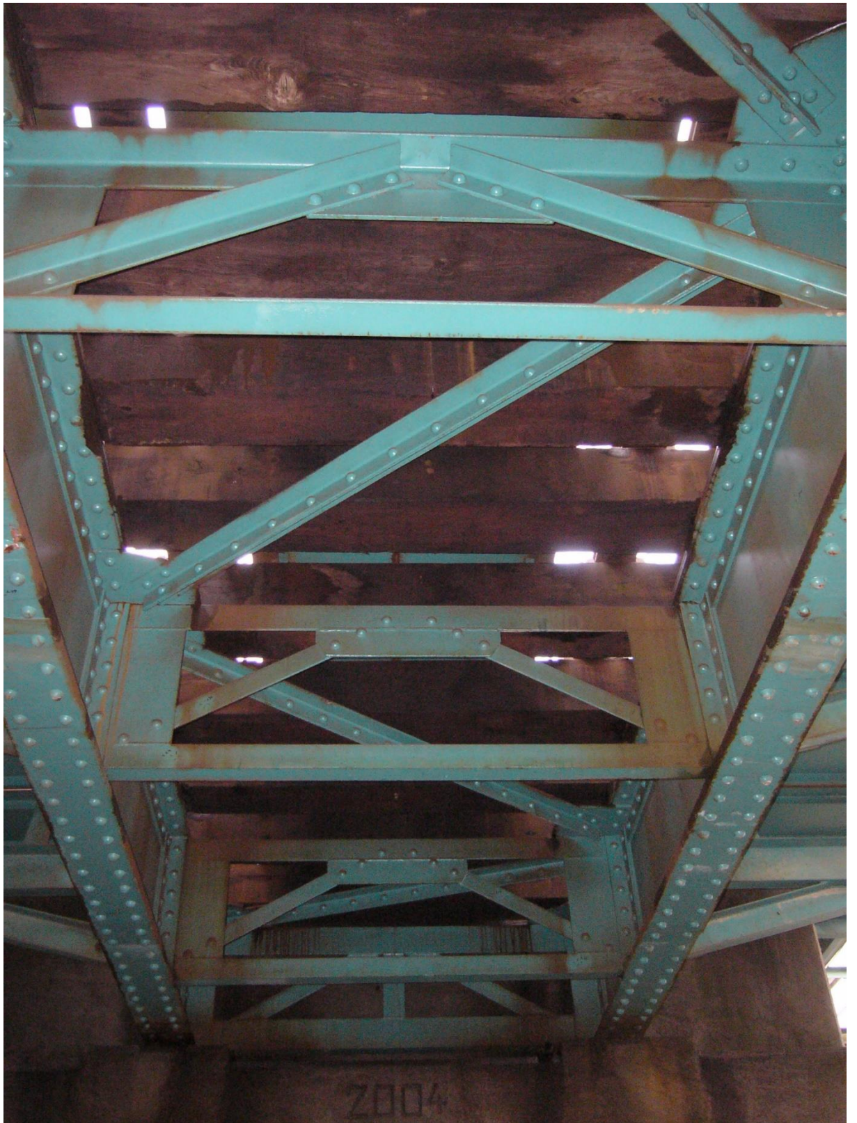
Fotografie 5 - Pohled zespoda na mostní ocelovou konstrukci
