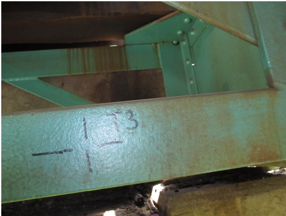
Fotografie 25 - měřený bod T3 (tloušťka materiálu)
