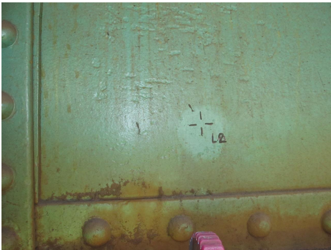
Fotografie 14 - měřený bod L2 (tloušťka nátěru)
