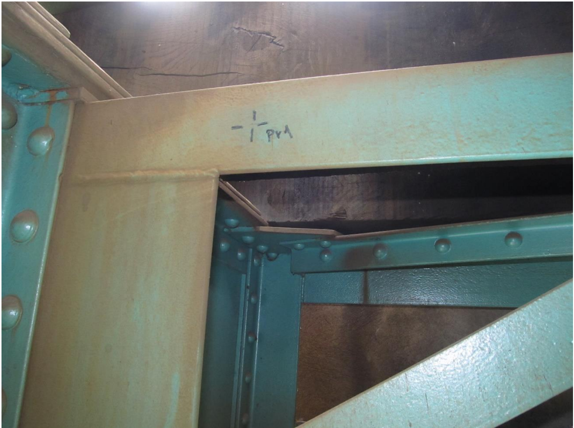
Fotografie 19 - měřený bod Pr1 (tloušťka nátěru)
