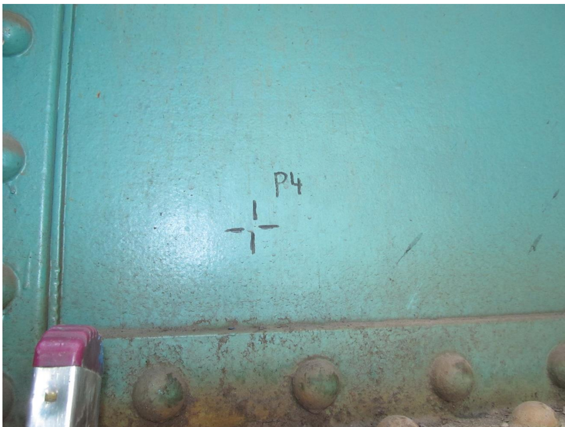
Fotografie 16 - měřený bod P4 (tloušťka nátěru)
