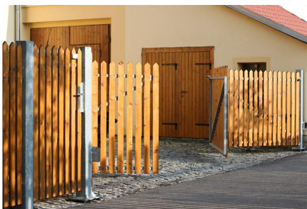
Obr. 1.3 – Křídlová brána skládací (Ptáček, 2015)
