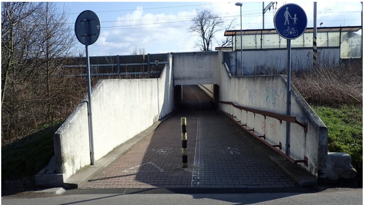
Obrázek 9 Pohled na stávající podchod pod železniční tratí
