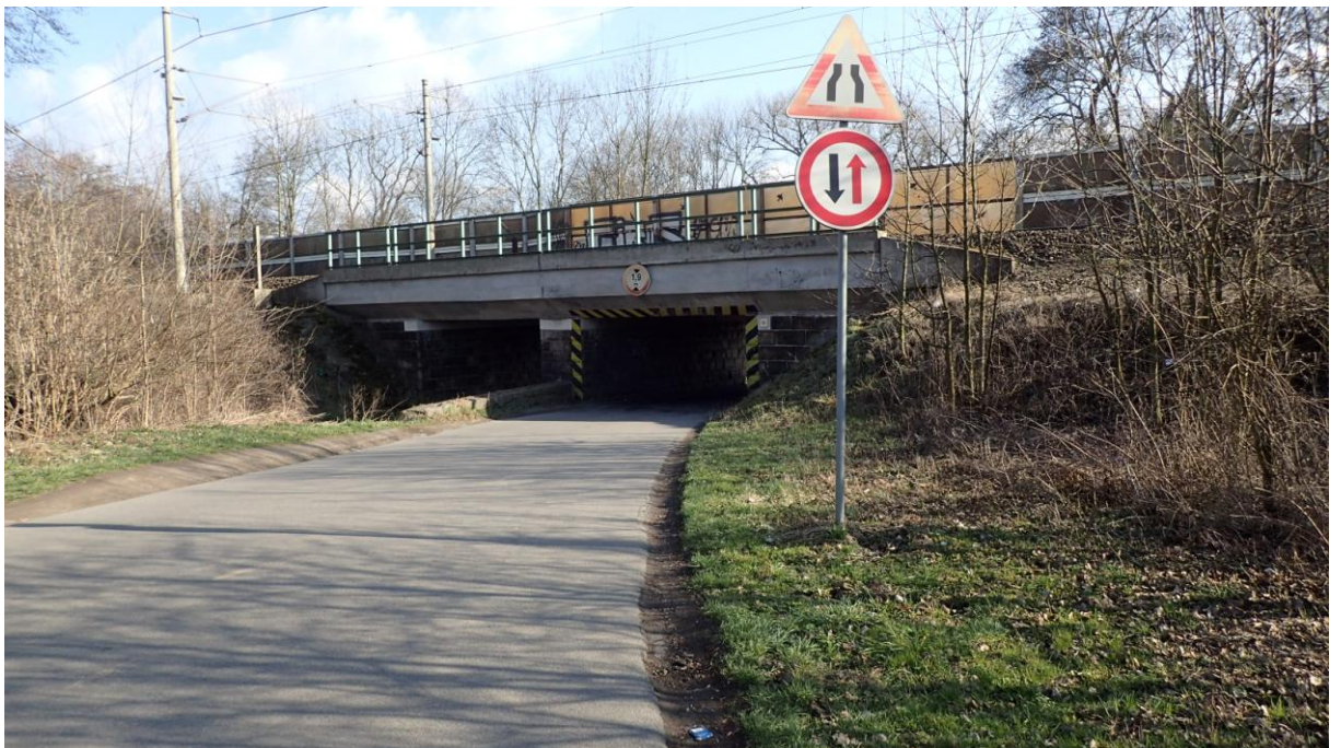
Obrázek 15 Pohled na stávající podjezd pod železniční tratí směrem na jih (směrem do Svitkova)
