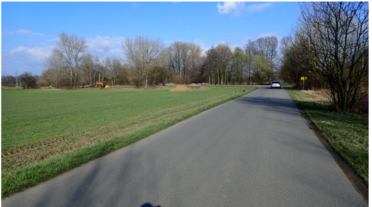
Obrázek 11 Pohled na stávající komunikaci ulice Srnojedská směrem na východ
