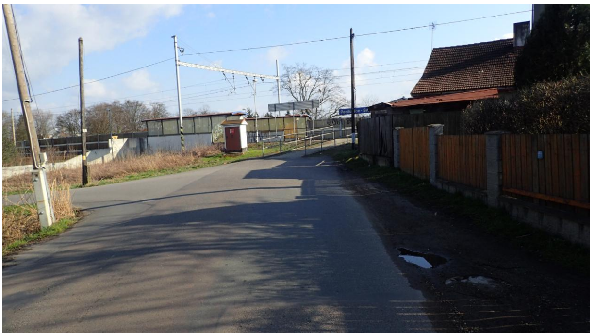
Obrázek 7 Pohled na stávající komunikaci ulice Srnojedská (větev H) v místech vstupu na vlakovou zastávku
