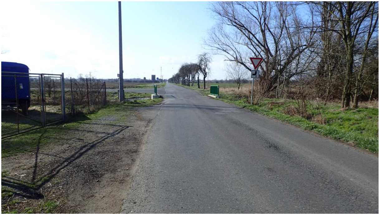
Obrázek 4 Pohled na stávající propustek a křižovatku komunikace III/322211 s ulicí Srnojedská
