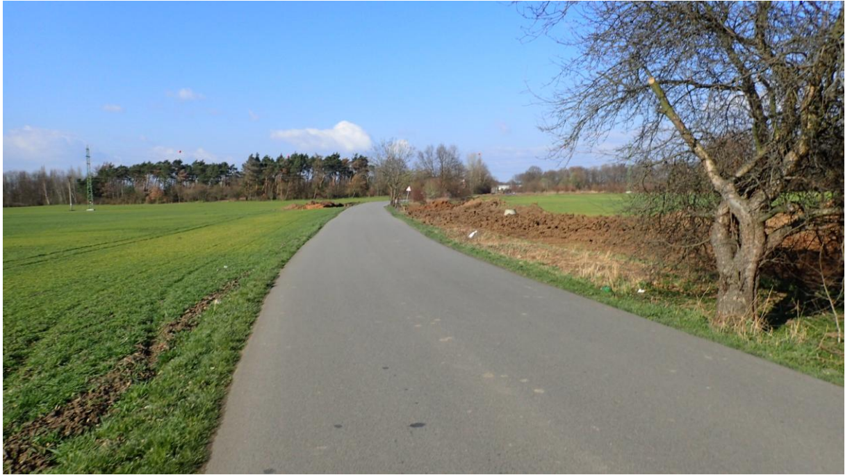
Obrázek 14 Pohled na stávající komunikaci směřující do Rosic
