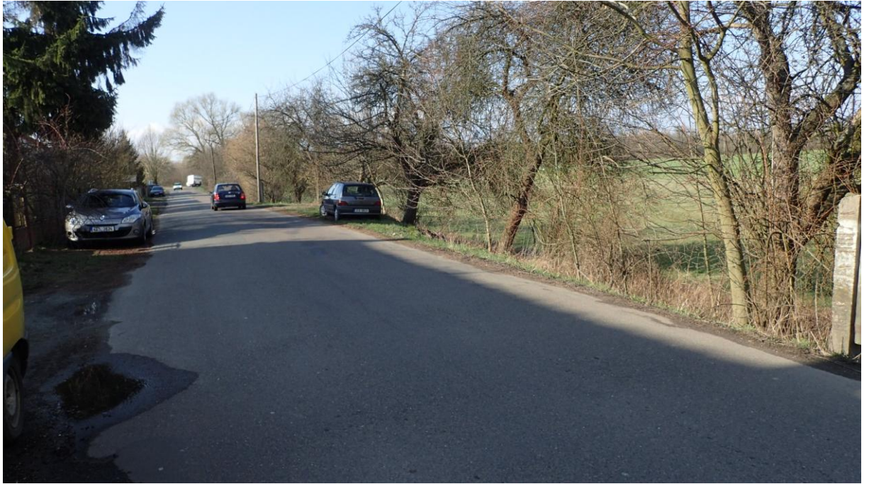
Obrázek 6 Pohled na stávající komunikaci ulice Srnojedská (větev H) a za stromy místo, kde bude nově navržená komunikace větve A, spojující obě okružní křižovatky
