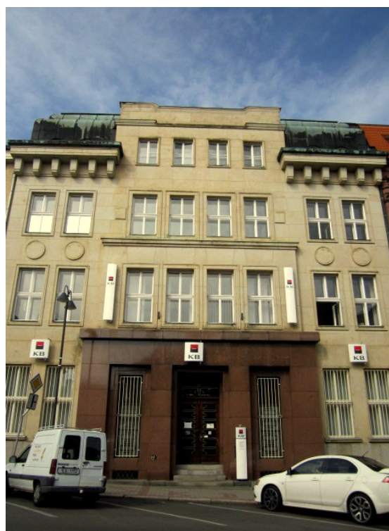
Obr. 14. Městská spořitelna v Novém Boru
