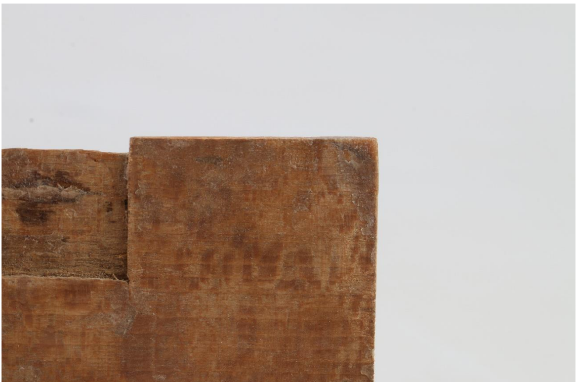
fotografia 70 – Detail rohu dosky po zatmelení
