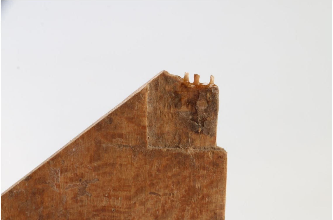
fotografia 71 – Detail žliabku pred tmelením
