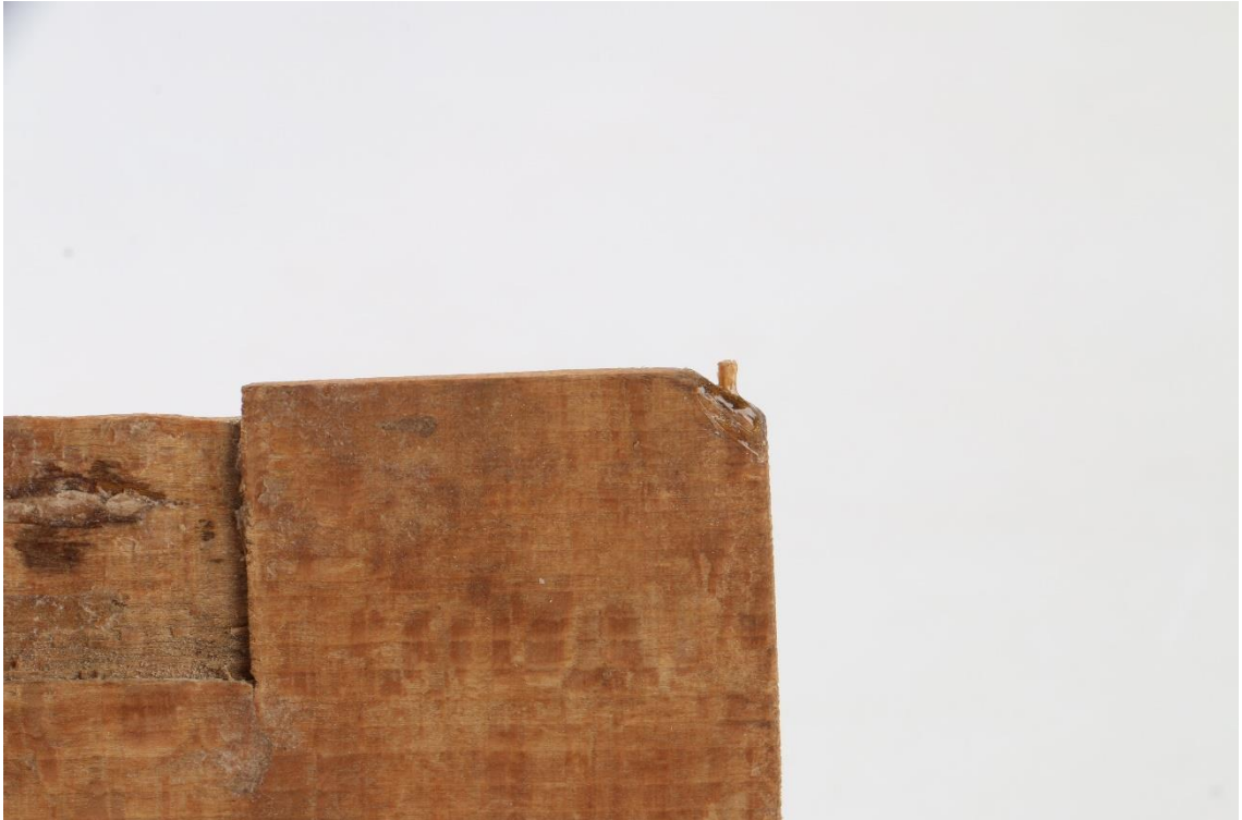
fotografia 69 – Detail rohu dosky pred tmelením
