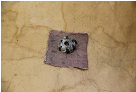
Obr. 113: Detail koroze poškozeného patentu
