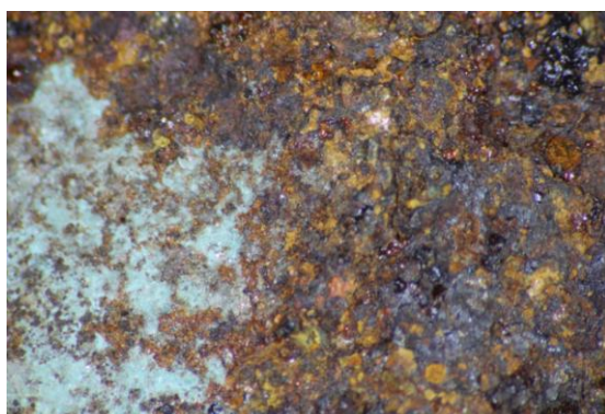
Obr. 43: Detail koroze na hlavičce hřebíku na těle Drvoštěpa, foto pod mikroskopem
