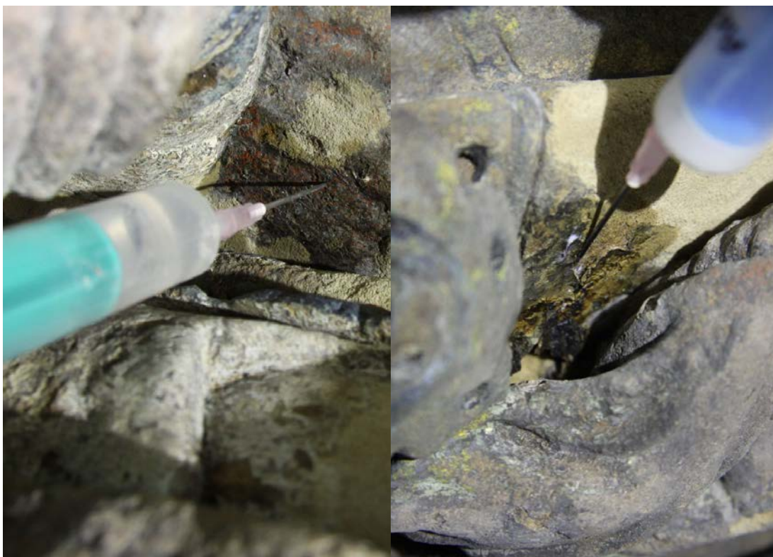
Obr. 46 a 47 Penetrace podkladu ethanolovou vodou a aplikace adheziva Acrykleber 498 HV pod krakely a uvolněnou barevnou vrstvu.
