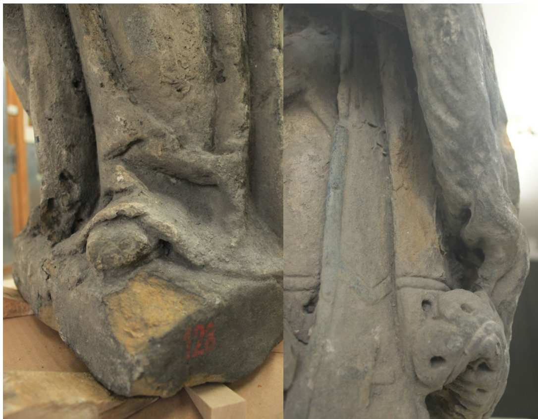
Obr. 25 a 26 Detaily poškození, zkrakelovaná a odpadávající polychromie, mechanická poškození, stav před restaurováním.
