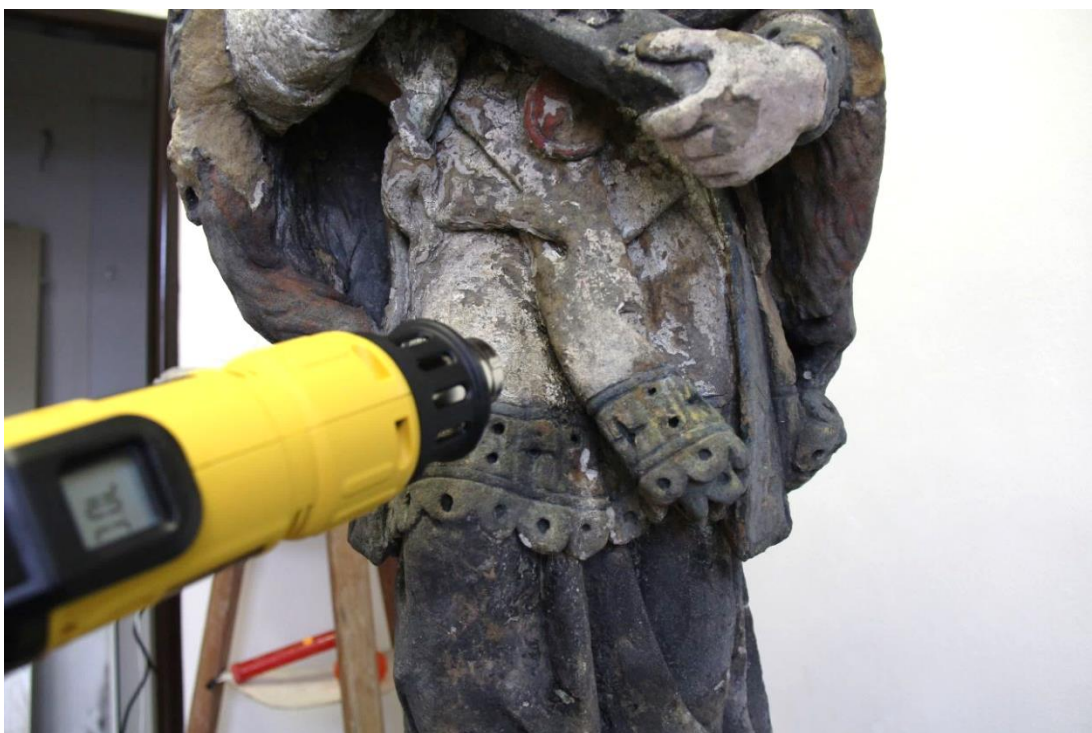
Obr. 48 Prohřívání povrchu regulovatelnou horkovzdušnou pistolí před samotným zažehlováním barevné vrstvy. Teplota ohřevu byla v rozmezí 70 – 100 °C.
