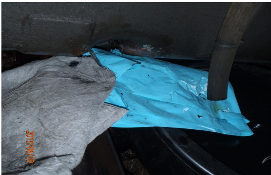
Obrázek č. 5: Instalace koryta a jímací nádoby
