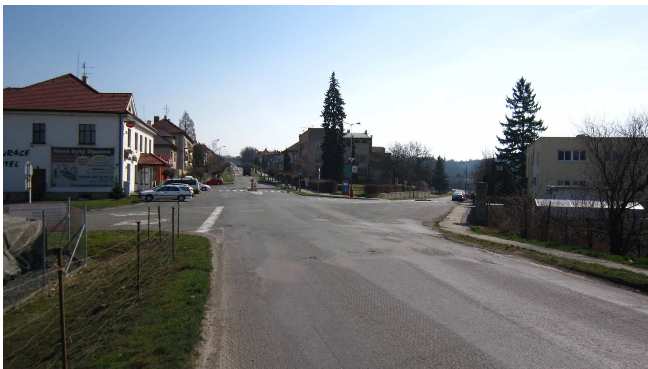
Obrázek 10 Pohled na stávající křižovatku „u Jordánku“, kde byl proveden průzkum intenzit dopravy
