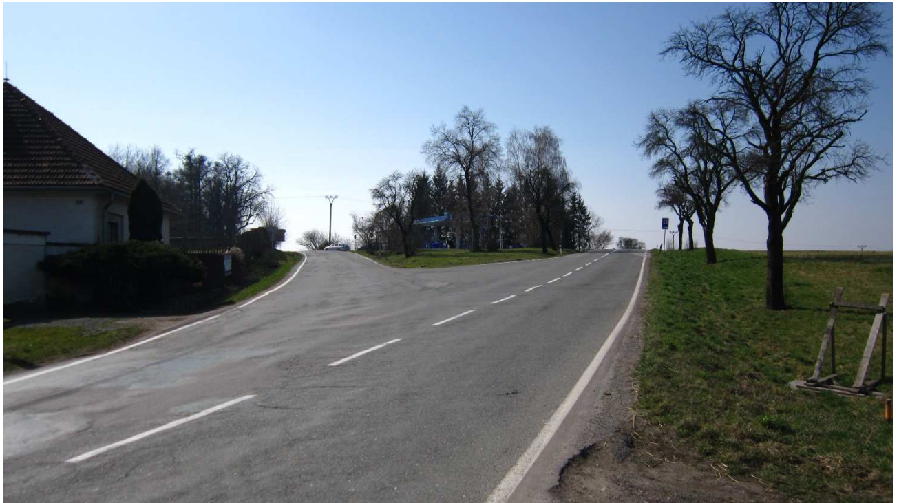
Obrázek 3 Pohled na stávající křižovatku „u Benziny“, kde byl proveden průzkum intenzit dopravy
