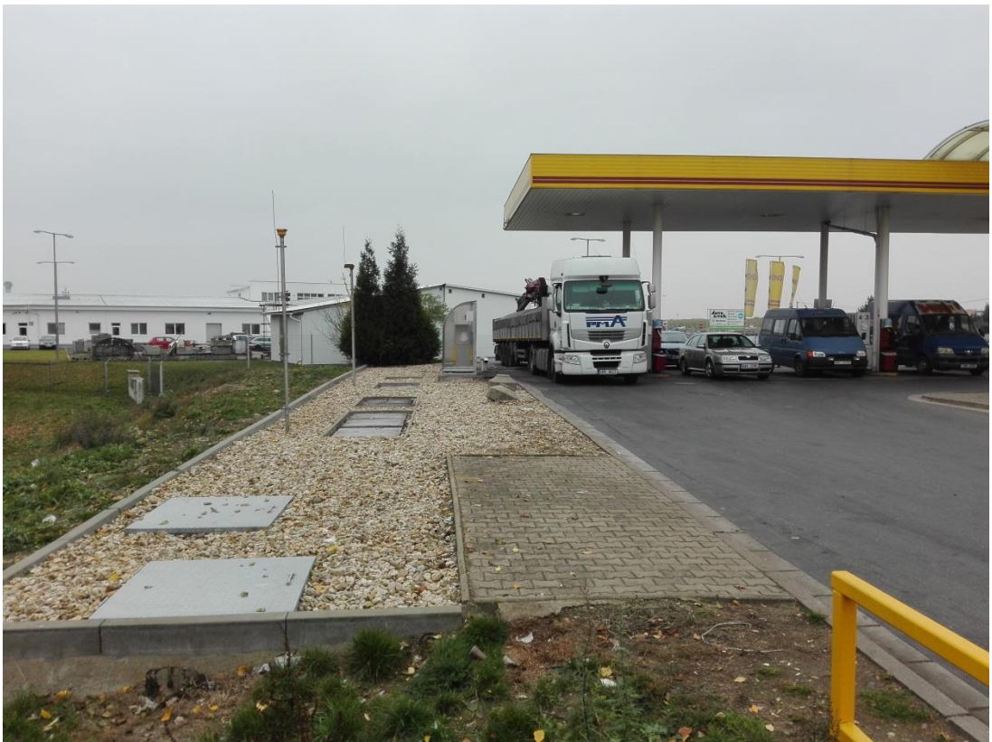
Foto 10 – Pohled na zásobníky čerpací stanice Tank ONO
