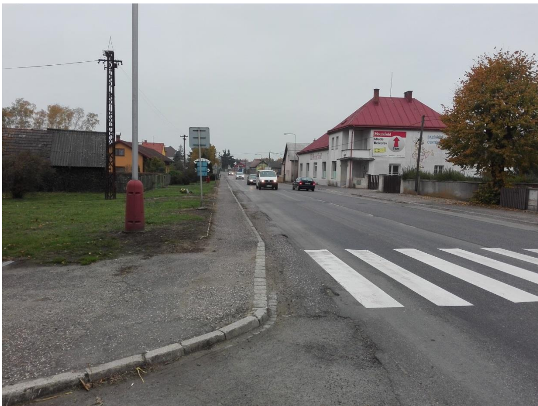
Foto 15 – Pohled na silnici I/16 vedenou středem obce Sukorady
