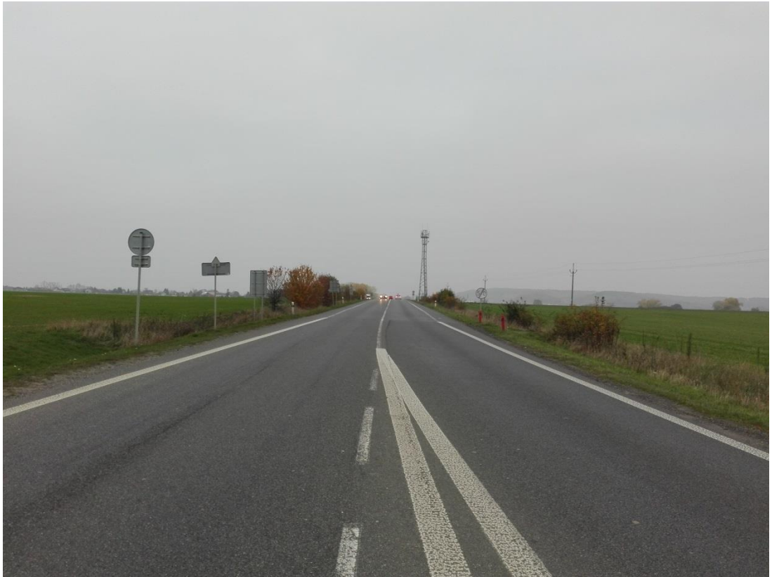
Foto 25 – Západní pohled na místo, kde se bude trasa varianty I zpět napojovat na silnici I/16, stávající silnice I/16 se bude od obce Plazy do Židněvsi rekultivovat na zemědělskou půdu
