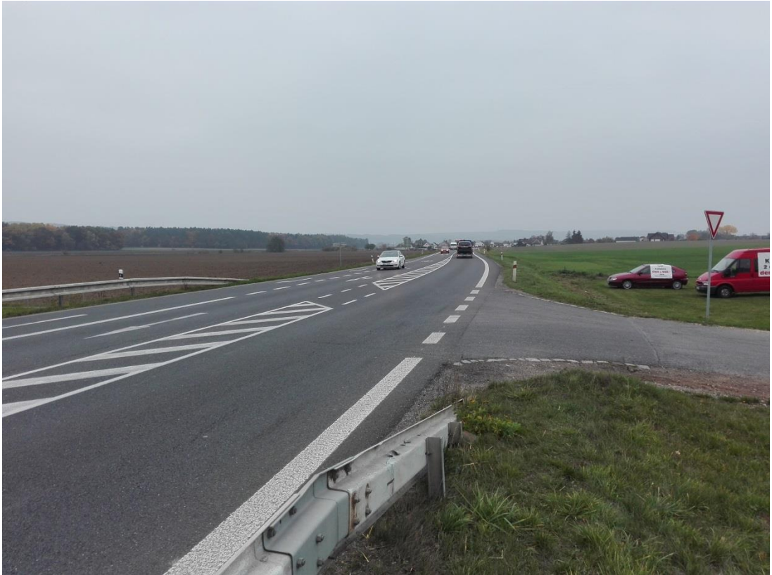
Foto 7 – Pohled na stávající jihozápadní vjezd do obce Martinovice
