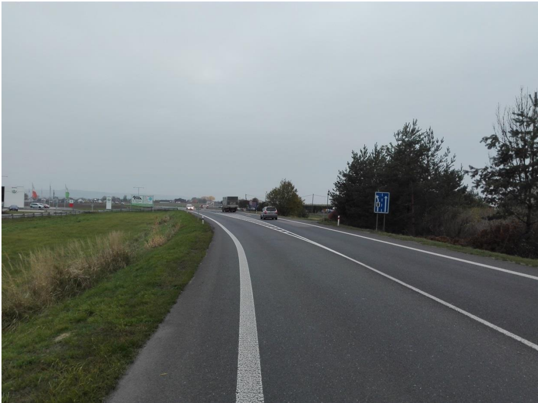
Foto 5 – Pohled na stávající silnici I/16, zde začíná varianta I
