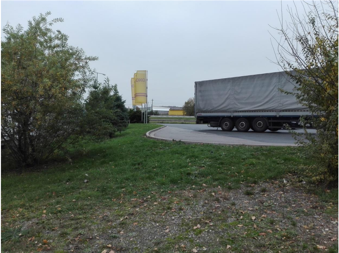
Foto 9 – Pohled na budoucí silnici III, která bude zřízena pro volný průjezd kolem čerpací stanice Tank ONO u varianty II
