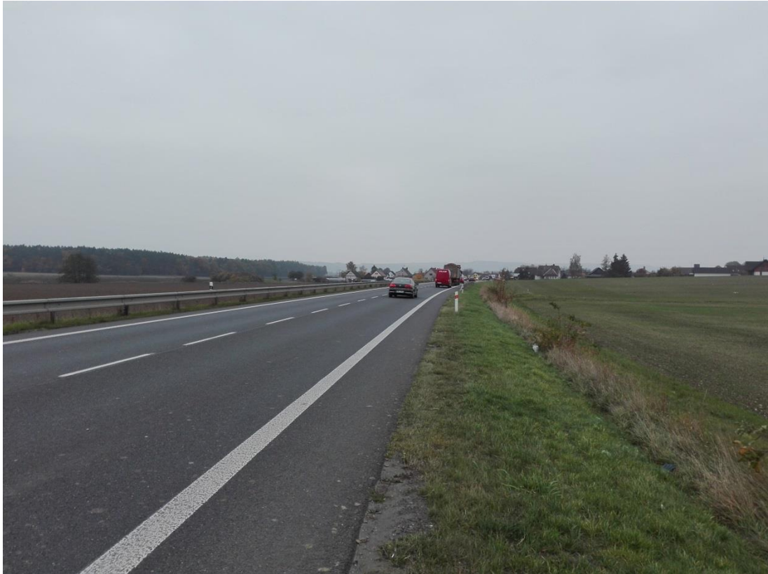
Foto 11 – Jihozápadní pohled na budoucí křižovatku silnice I/16 na silnici III vedenou na obchvat
