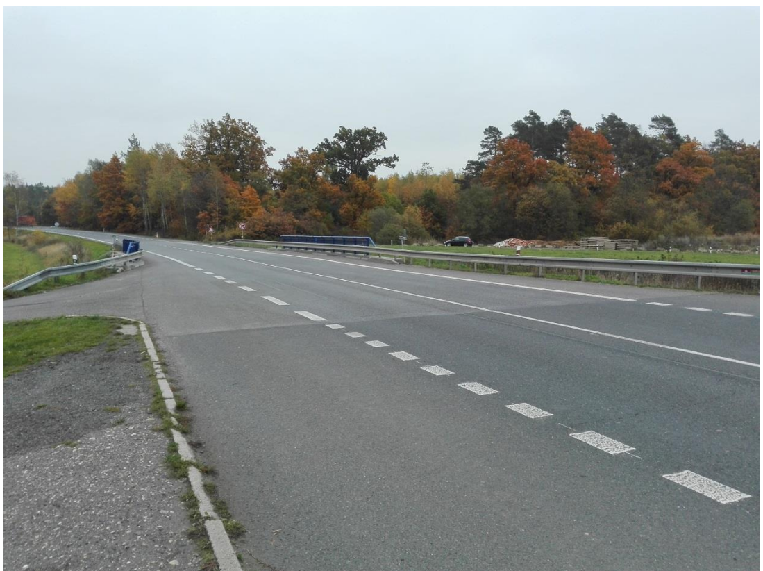
Foto 2 – Pohled na budoucí křižovatku K 2.1
