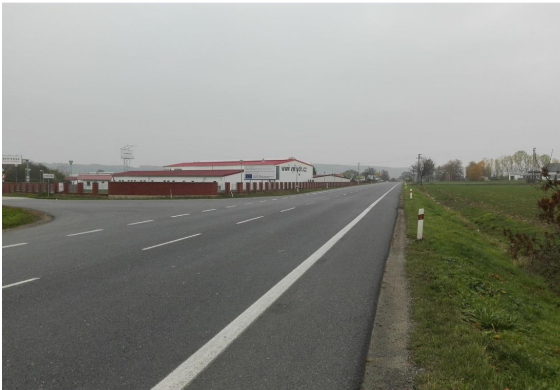
Foto 22 – Pohled na stávající křižovatku silnice I/16 s místní komunikací, kde bude zřízené napojení na silnici III vedenou severně na obchvat
