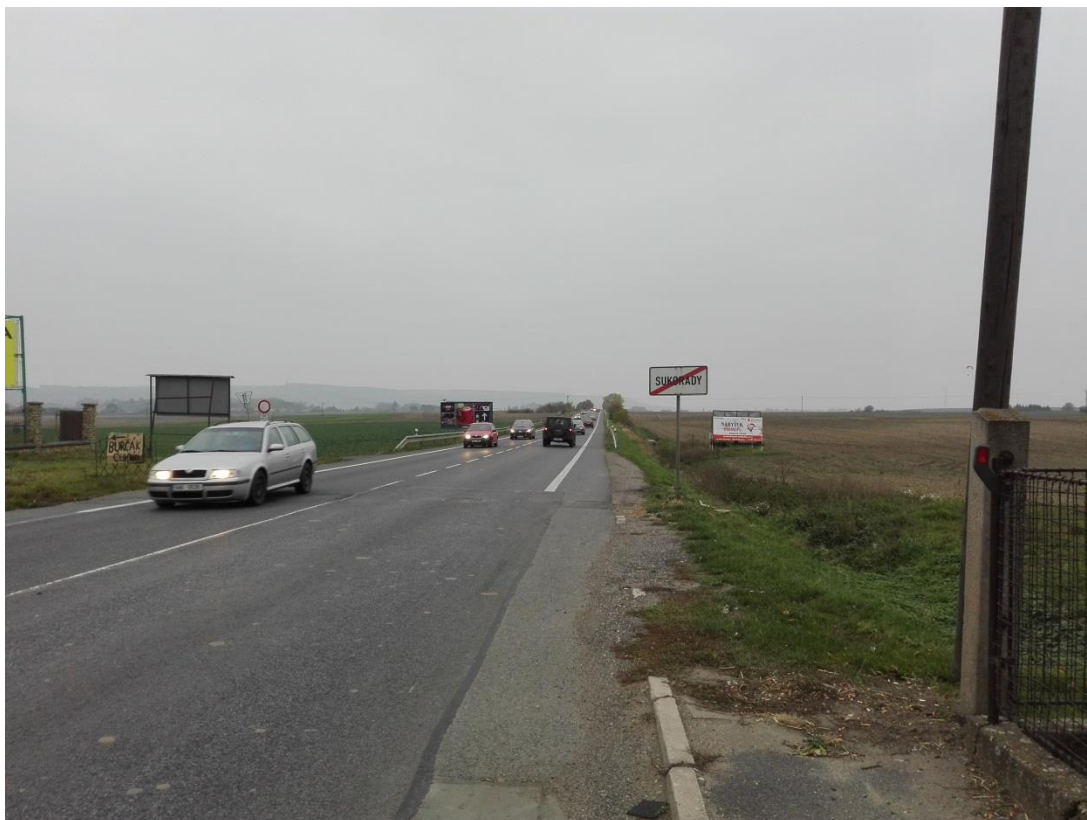
Foto 17 – Jihozápadní pohled na stávající silnici I/16 mezi obcemi Sukorady a Židněves, která bude rekultivována na zemědělskou půdu
