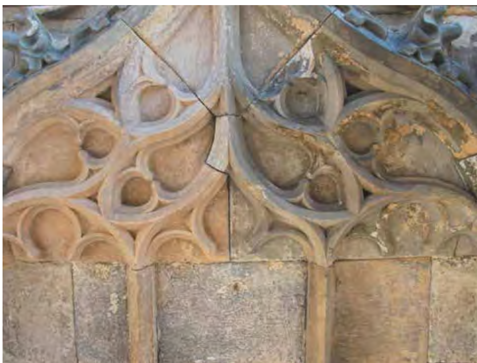
36) Průběh prací - snímání tmelů a přetěrů ze slepé kružby.
