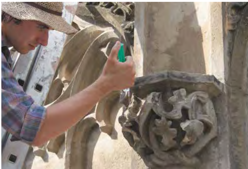
33) Průběh prací - předzpevnění narušeného kamene.
