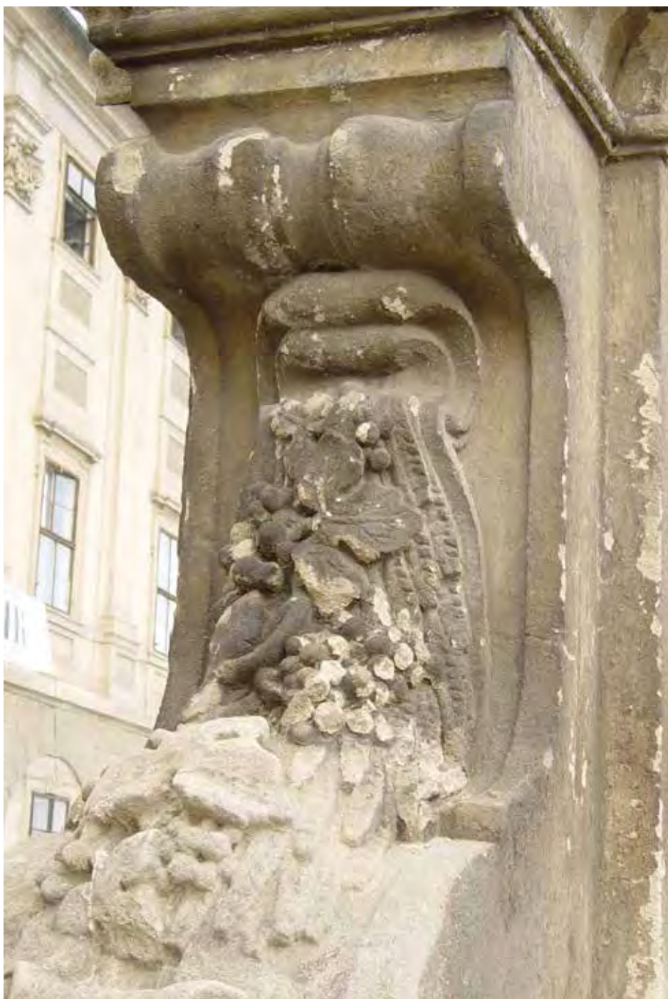
21) Povrch vystavený srážkám je smyt ve srovnání s povrchem krytým proti dešťové vodě.
