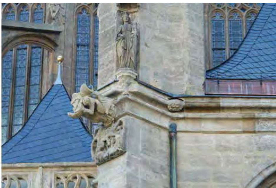
40) Chrám sv. Barbory. Poslední gotický chřtáč musel být v roce 2008 nahrazen kopií. Při jejím zhotovení byl použit rakouský mušlový vápenec, podobně jako v případě náhrady dalších ornamentálních proků chrámu měněných při nedávné opravě.
