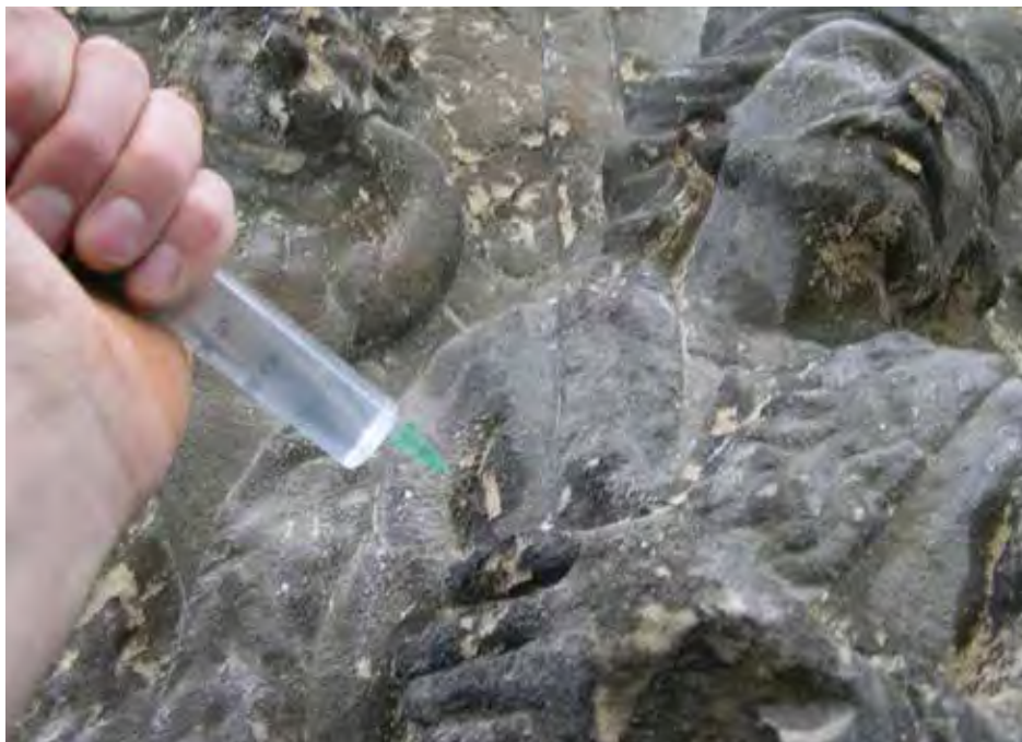
21) Reliéf na podstavci - zpevňování narušeného kamene pod krustou.
