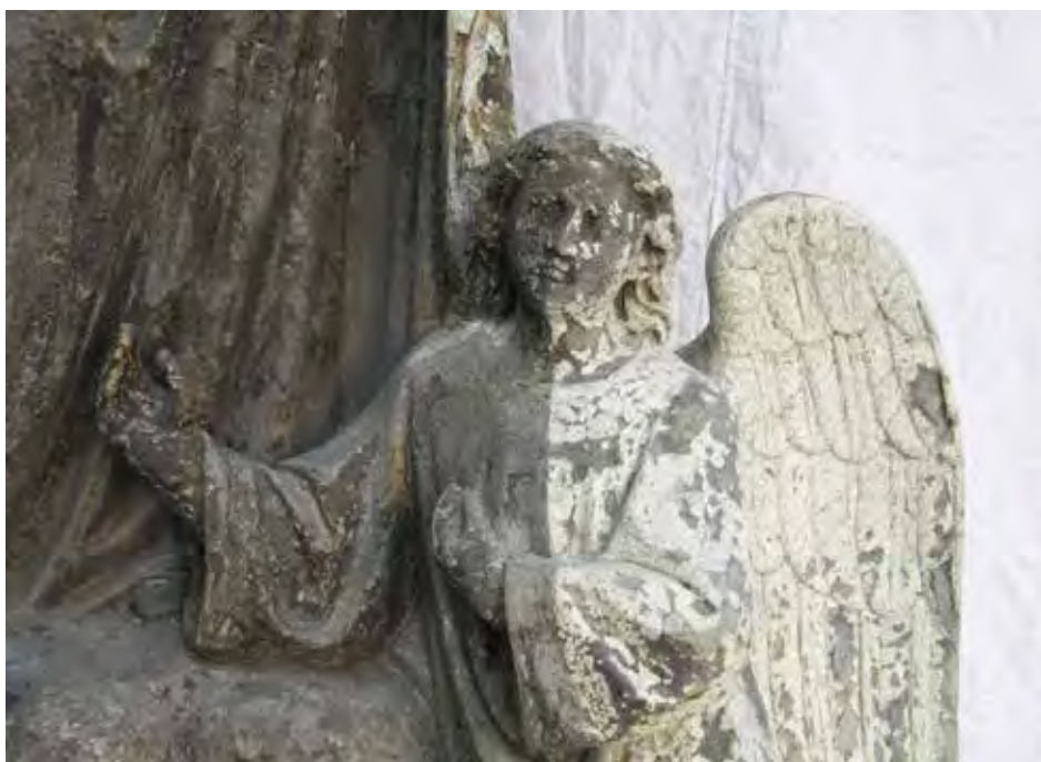
44) Průběh prací - snímání nevyhovujících přemaleb.
