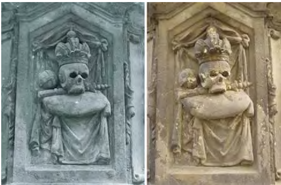
19) Detail sousoší sv. Františka Borgiaše před jezuitskou kolejí. Srovnání stavu po restaurování z roku 1991 a stavu v roce 2004 před dalším restaurátorským zákrokem. Ze srovnání snímků je patrné, že užití tvrdých cementových vysprávek v kombinaci se scelujícím přetěrem kameni neprospívá.
