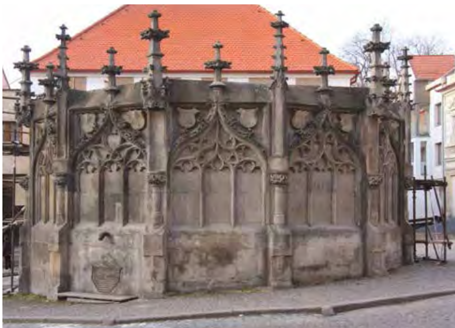
38) Kamenná kašna - stav před restaurováním v roce 2009.
