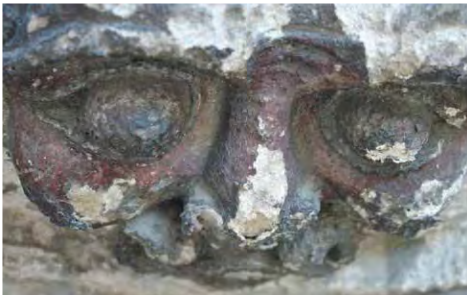
7) Maskaron u jižní stěny chrámu - pod krustou docházelo k rozpadu kamene, které postupně vedlo k oddělování povrchu a ztrátám modelace.
