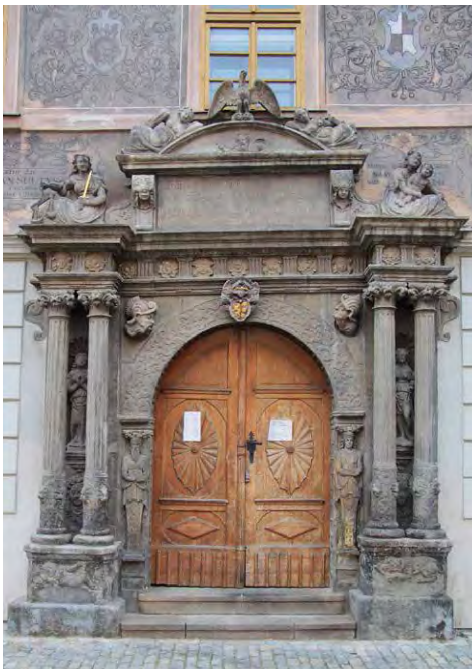
42) Portál Stejškova domu čp. 173 v Šultysově ulici. Na kameni jsou patrné povrchové úpravy, které dotvářejí celkový výraz fasády. Podrobný restaurátorský průzkum, který by určil jejich stáří a míru dochování, zatím nebyl proveden. Jedná se o jednu z mála kamenných památek umístěných v exteriéru s dochovanou povrchovou úpravou.
