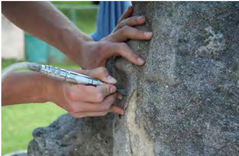
28) Socha sv. Jana Nepomuckého v Horušicích. Snímání cementových tmelů pomocí mikrodlátka.
