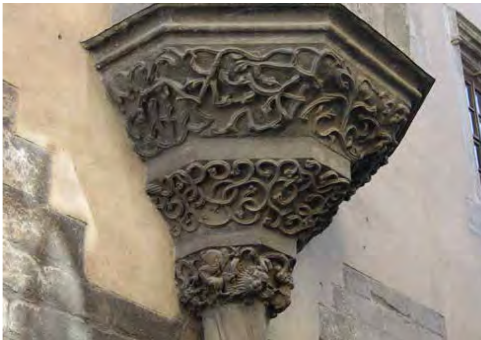
6) Hrádek - spodní část arkýře v severozápadním průčelí.
