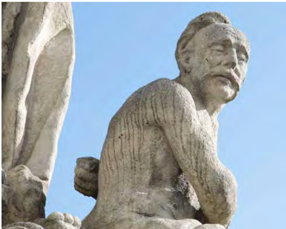
37) Detail sousoší sv. Ludvíka před jezuitskou kolejí. Na hydrofobizovaném povrchu se časem vytvářejí tzv. „cestičky“.
