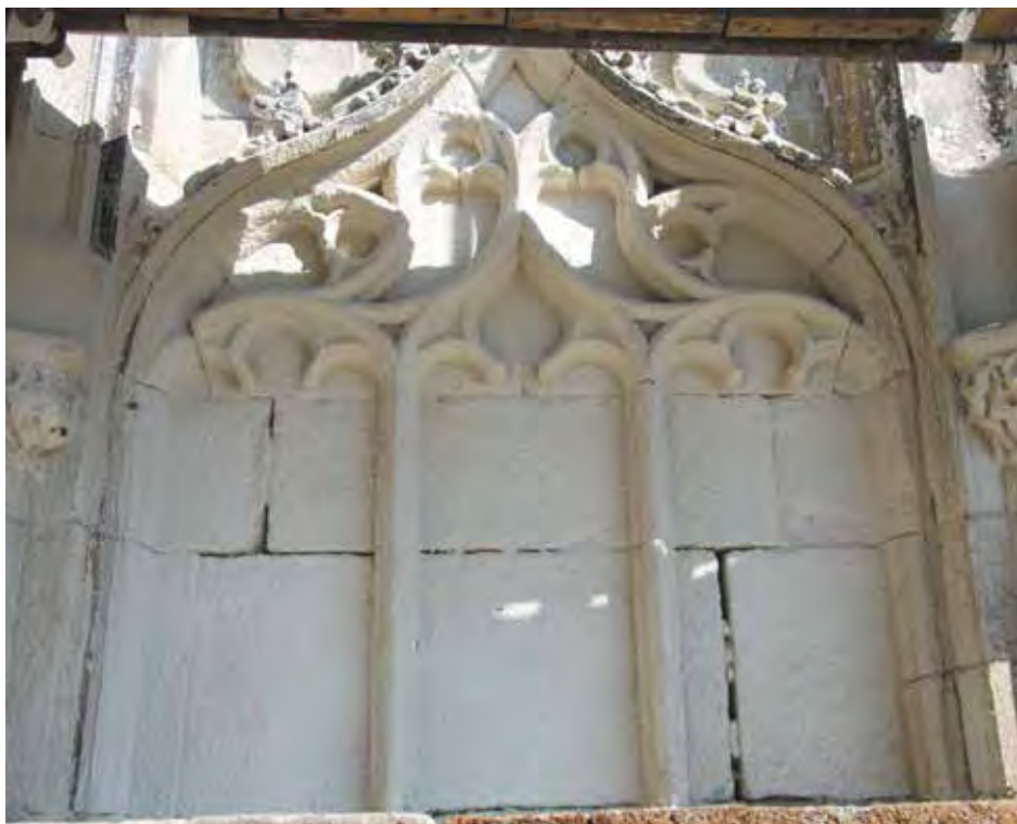
34) Průběh prací - odsolování povrchu pomocí zábalů.
