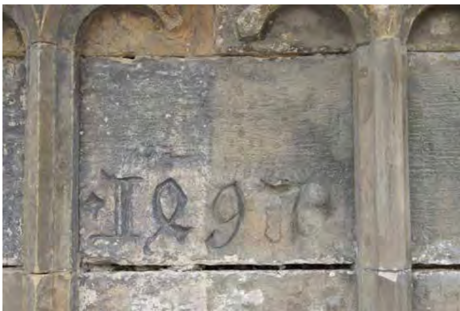
35) Průběh prací - snímání disperzního nátěru pomocí rozpouštědel a mikrootryskávání.
