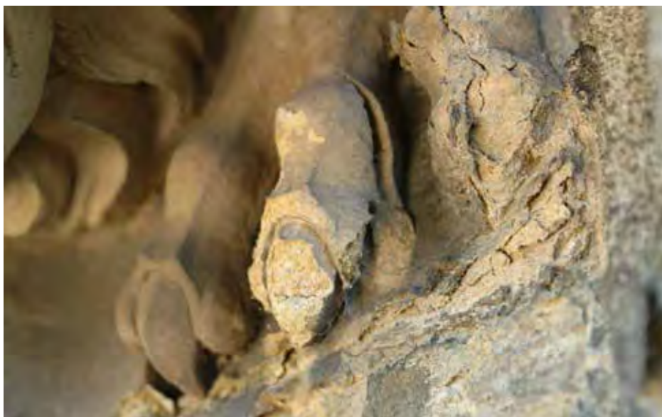
2) Stav před restaurováním - rozpad hoříckého pískovce v místech styku s vápencovým zdivem v důsledku migrace síranových solí.
