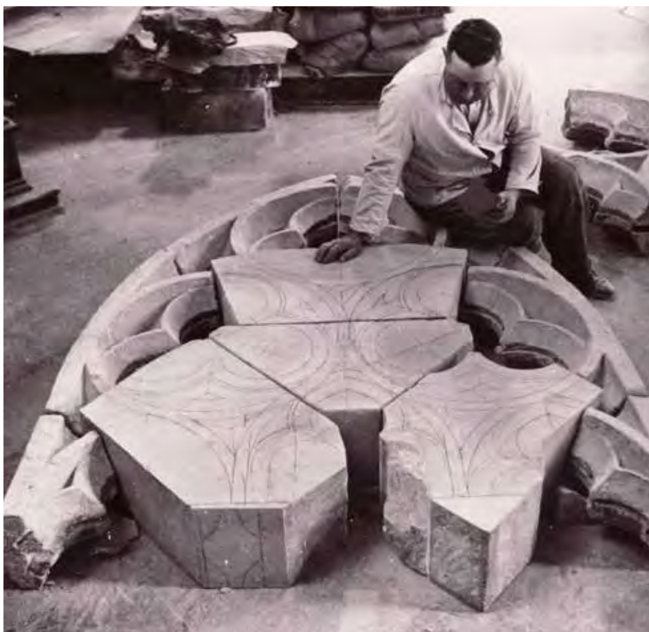
17) Kostel sv. Jakuba - výměna okenních kružeb v roce 1942.
