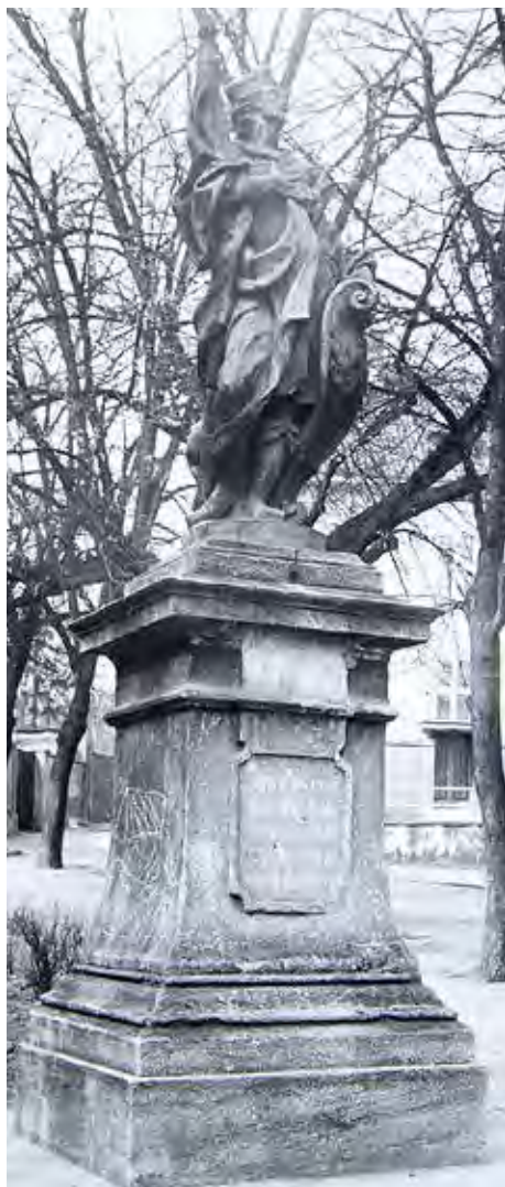
24) Socha sv. Václava na Václavském náměstí v roce 1944 a 2005. Srovnáním s archivní fotografií je vidět dramatický úbytek povrchu a ztráta modelace.
