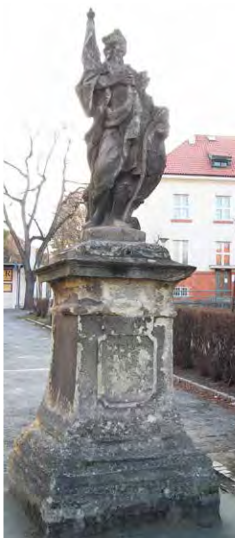
24) Socha sv. Václava na Václavském náměstí v roce 1944 a 2005. Srovnáním s archivní fotografií je vidět dramatický úbytek povrchu a ztráta modelace.
