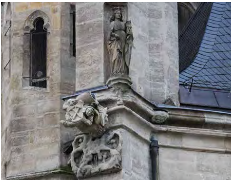
12) Chrlič ze severní stěny - nový chrlič zhotovený z mušlového vápence.
