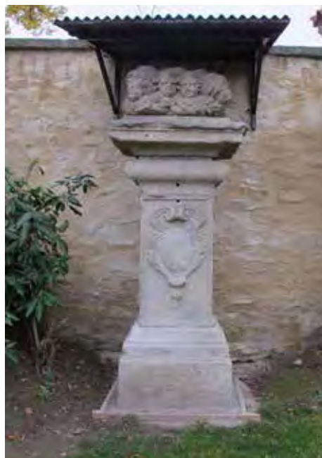
60) Torzo sochy sv. Jana Nepomuckého před restaurováním a podstavec po sestavení a restaurování. Nad podstavec byla zhotovena dočasná stříška.
