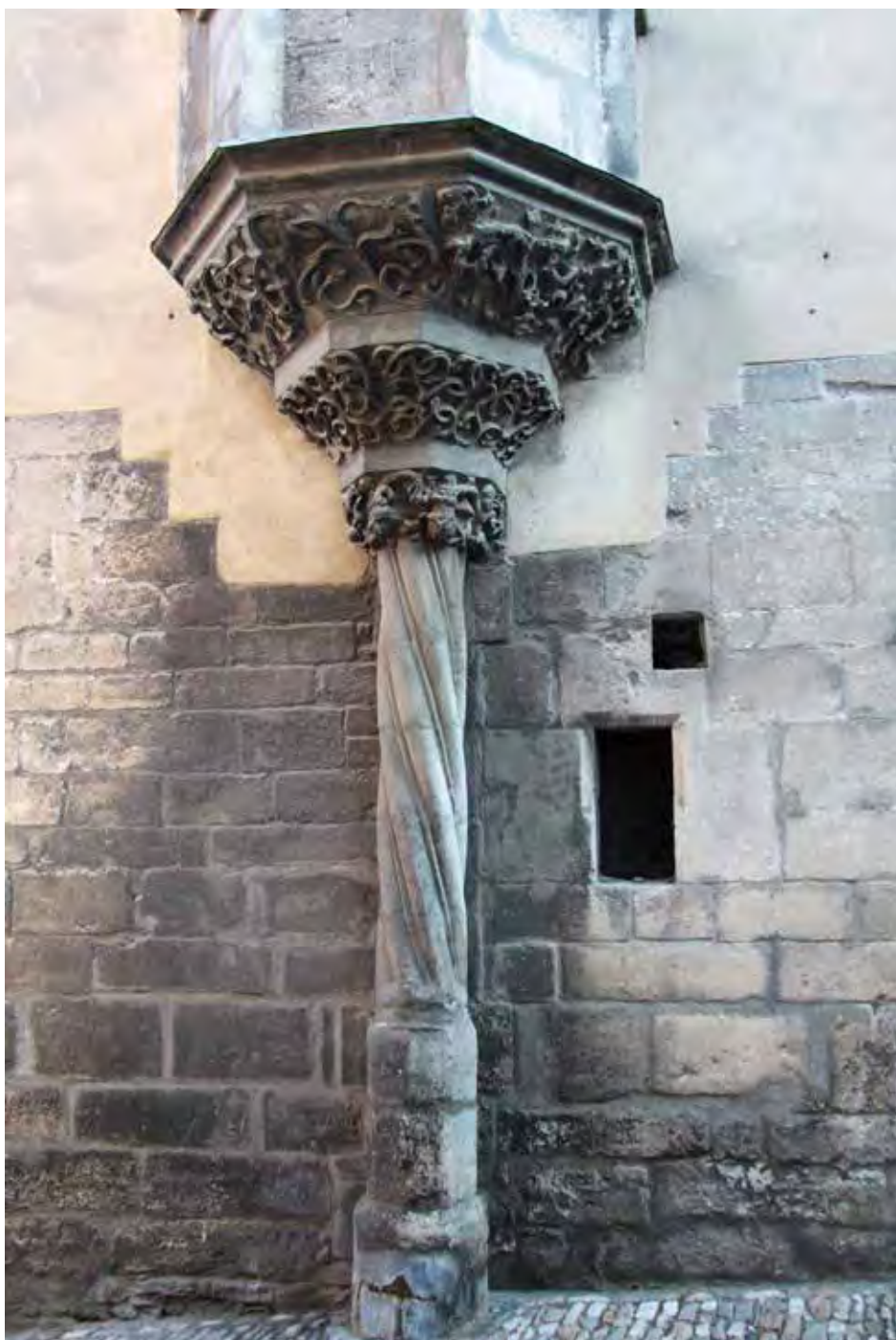
23) Typický příklad tvorby sádrocové krusty v místech krytých proti přímému vymývání dešťovou vodou.
