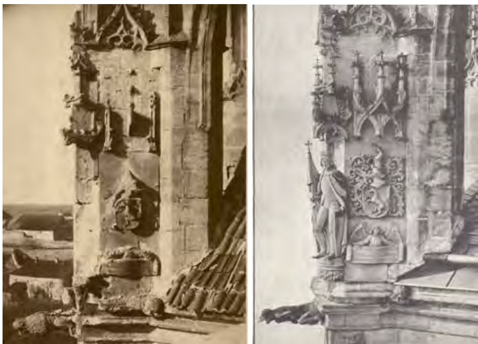
1) Srovnání stavu před velkou rekonstrukcí na konci 19. století a po ní - většina sochařské výzdoby chrámu byla nahrazena novými prvky z hořického pískovce.
