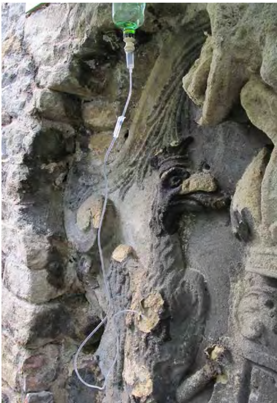
31) Znak Kutné Hory umístěný ve zdi terasy pod Vlašským dvorem. Zpevňování velmi narušeného vápence s využitím infuzí umožnilo dostatečnou penetraci konsolidantu do hmoty kamene a umožnilo i zpevnění pod nepropustnými krustami.
