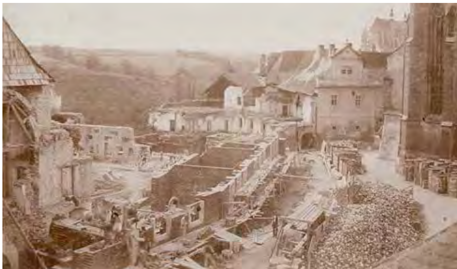
16) Vlašský dvůr v roce 1893. Značná část objektu byla při rekonstrukci rozebrána a postavena za použití nových kamenických prvků.
