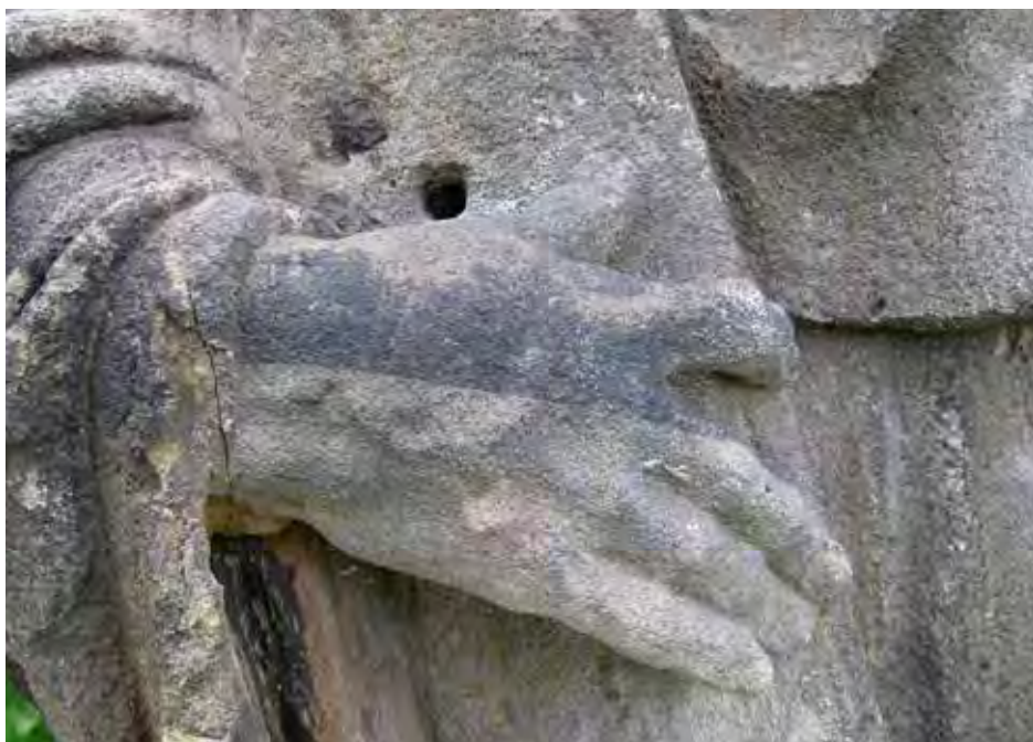
17) Socha sv. Bernarda - průběh čištění silikátové krusty pomocí mikrotryskání.
