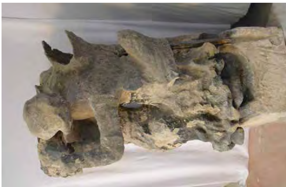
11) Chrlič ze severní stěny - poslední dochovaný pozdně gotický chrlič musel být pro svůj špatný stav sejmут. Po snesení byl umístěn v interiéru chrámu.
