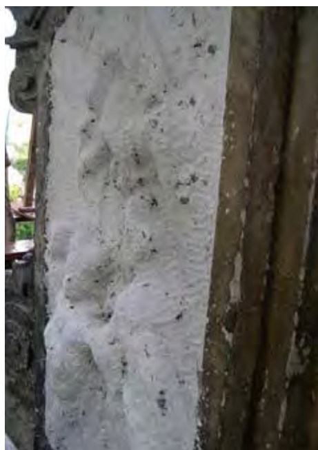
22) Průběh prací - čištění kombinací mikrotryskávání a zábalů.
