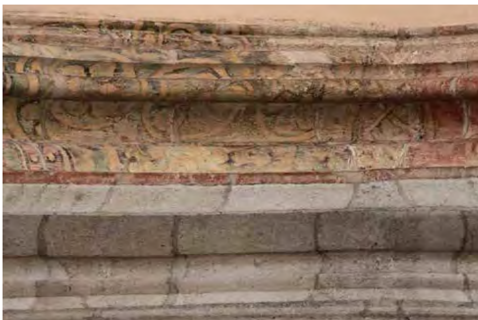
41) Chrám sv. Barbory - profil žeber na rozhraní mezi loděmi. Část směrem k hlavní lodi byla při puristické opravě očistěna, zatímco žebra v boční lodi zůstala polychromována.
