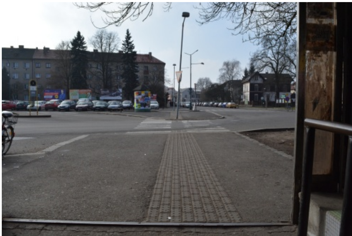
Obrázek D1 - Pohled z podchodu železniční stanice jižním směrem k Palackého třídě.
