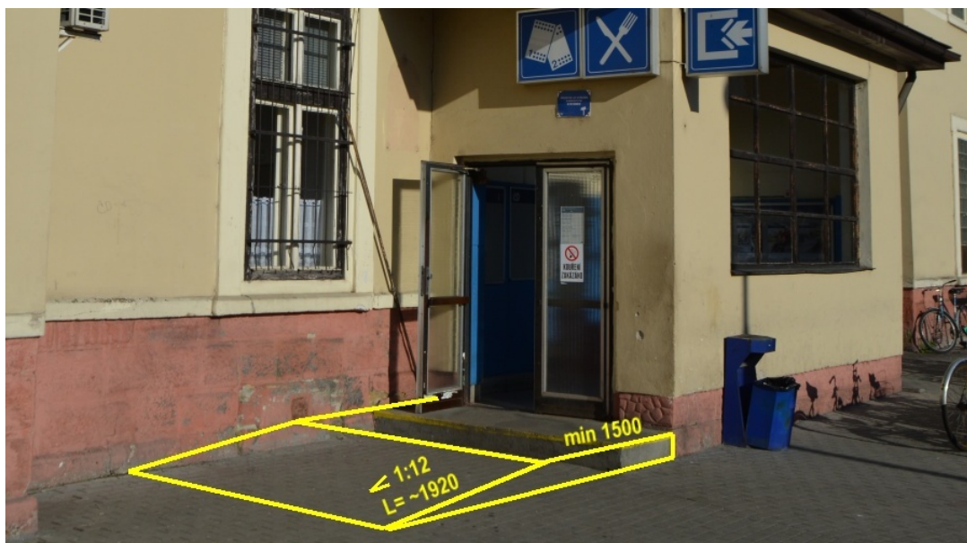
Obrázek 12 - Návrh šikmé rampy u vstupu do odbavovací haly
