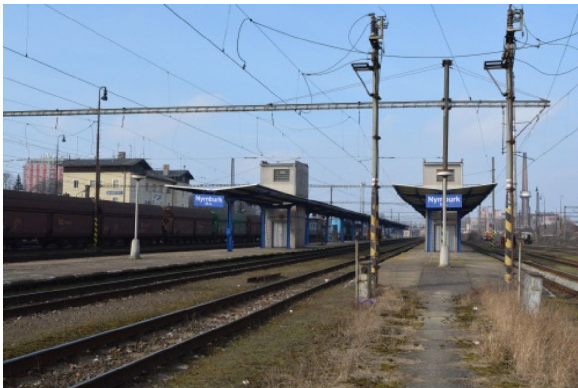
Obrázek B2 - Ostrovní nástupiště č. II a III, v popředí služební výtahy ČD.
