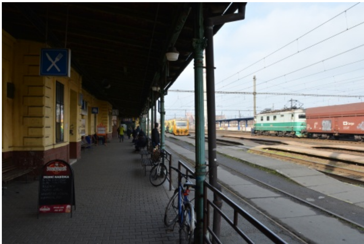
Obrázek B1 - Nástupiště č. I, v pozadí vstup do podchodu.
