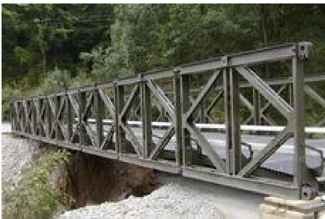
Obrázek 3 Silniční mostní provizorium (11)
