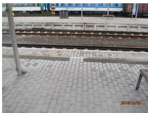
Obr. 4, Signální pás, vodící linie s funkcí varovného pásu
