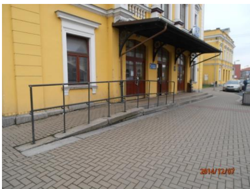
Obr. 1, Vchod do budovy žel. st.
