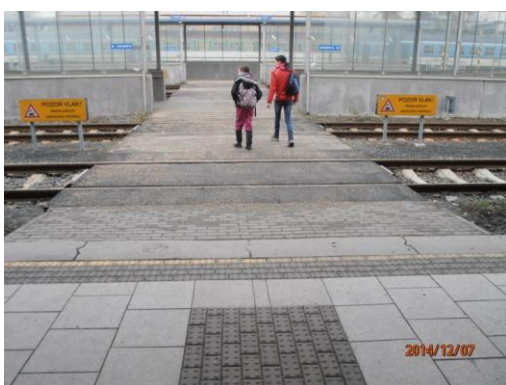
Obr. 3, Signální a varovný pás, dráž. těleso
