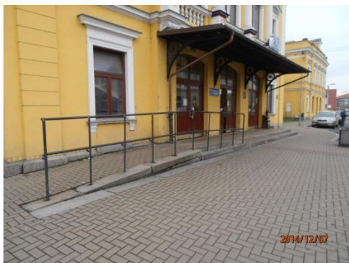
Obr. 17, Přístup do haly žel. st.
