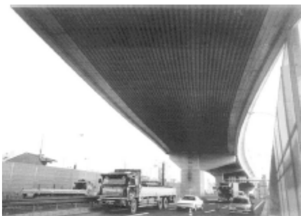
Obr. 8: Konstrukce tlumičů hluku na spodní části mostu [4]
