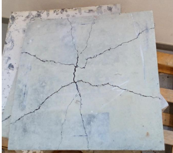
Obrázek 37 Spodní pohled na zkoušenou desku
