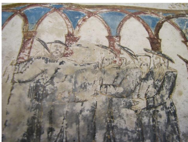
Obr. 136 Detail uvedeného poškození, sig. Ms 1
