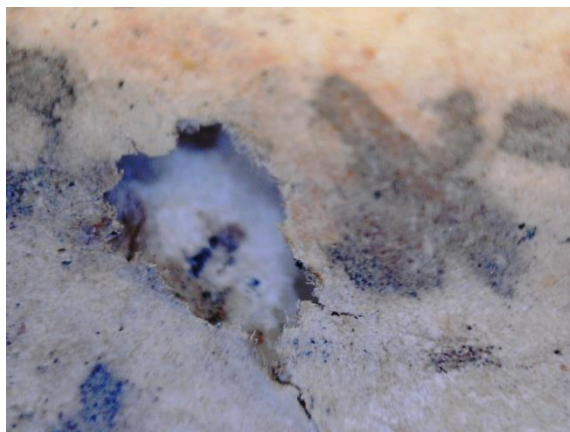
Obr. 104 Ztráta v místě trhliny, sig. Ms 1
