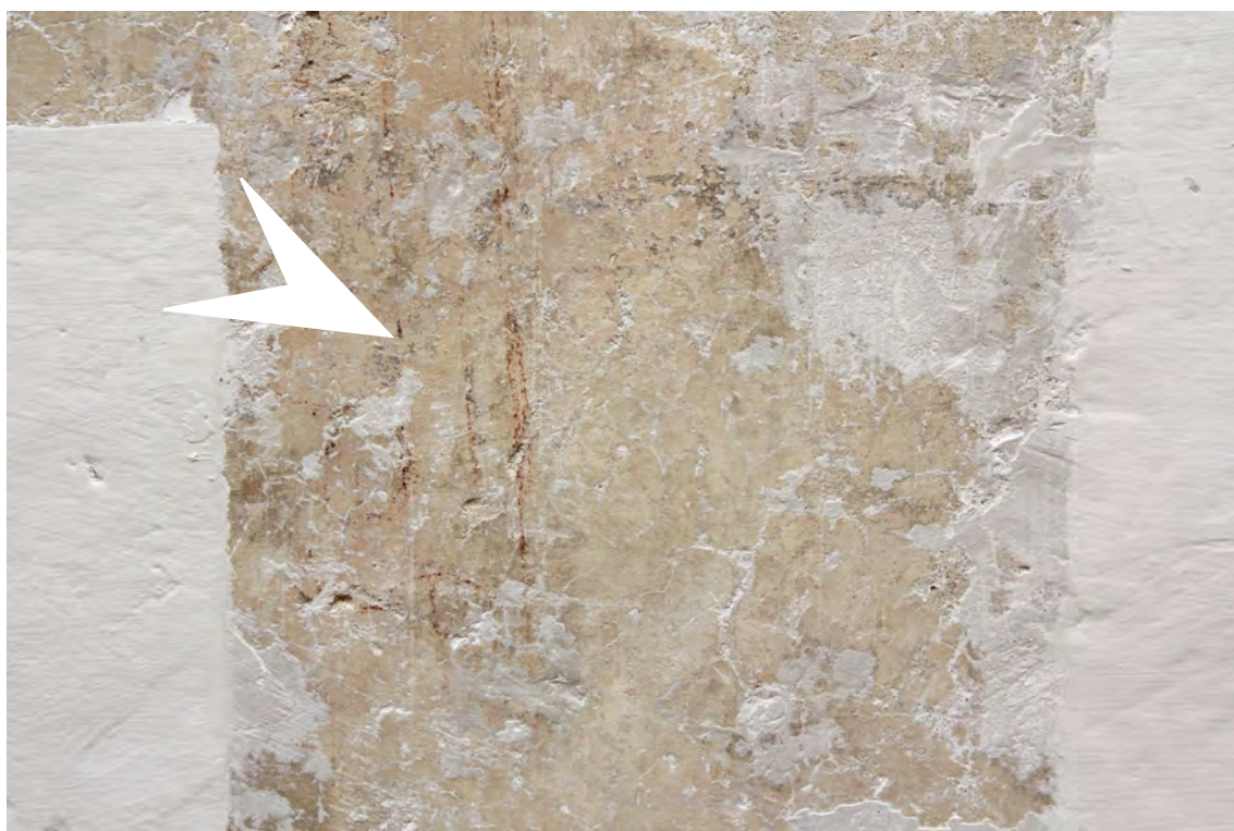
Obr. 17: Detail sondy 1SV 13 ; v levé části (šipka) je znát fragment kresby rudkou, omítku soklu překrývá množství sádrových a cementových tmelů
