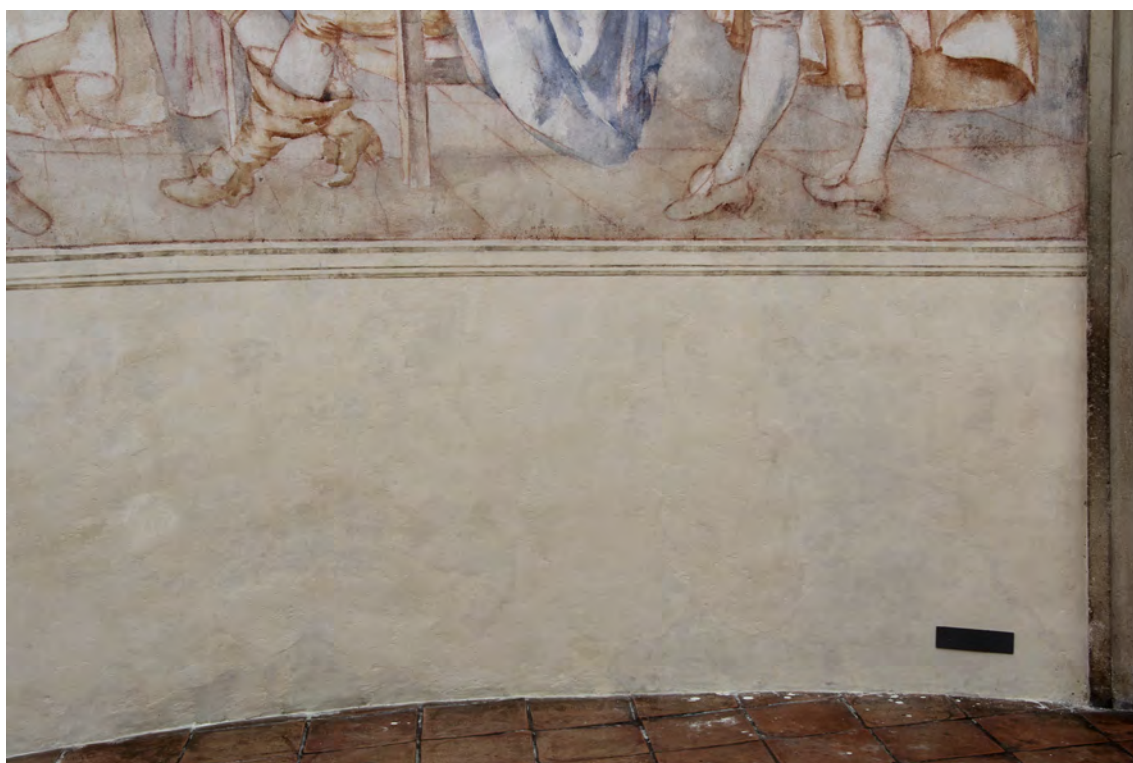
Obr. 45: Pravá část soklu po nátěru a rekonstrukci linek
