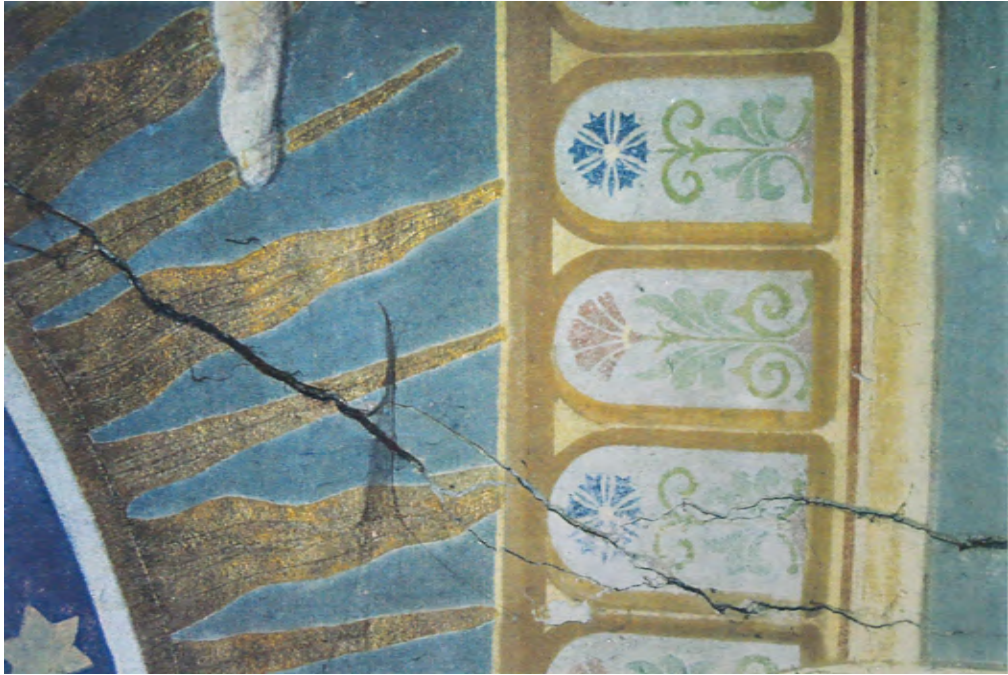
Obr. 80: Ukazatel stáří statické trhliny; trhlina je silně zanesena depozity, což odkazuje na její delší existenci; kostel sv. Jakuba v Jakubu u Kutné Hory (zdroj: KNOROVÁ, K.; KNOR, J. 1997 )
