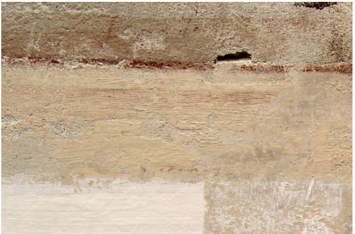
Obr. 13: Detail pásu 8 cm pod malbou; lze vidět fragmenty okrového nátěru s linkami, dále rozhraní omítky soklu a omítky malby
