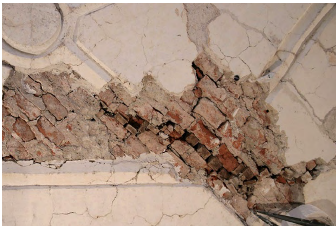
Obr. 83: Ukázka vyklínování zdiva klenby za účelem přidržení okolního zdiva; dům v Poštovní ulici 73/1 v Moravské Třebové (zdroj: VOJTĚCHOVSKÝ, J., 2010)
