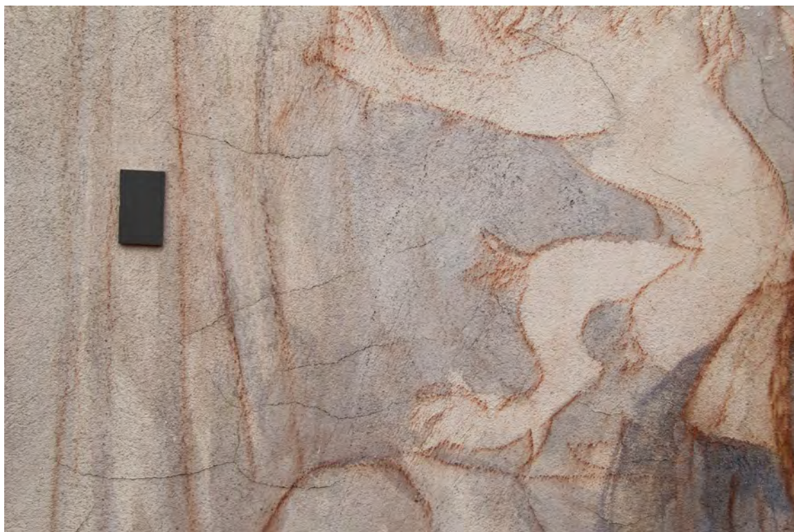
Obr. 16: Střední část malby; síť primárních prasklin v omítce
