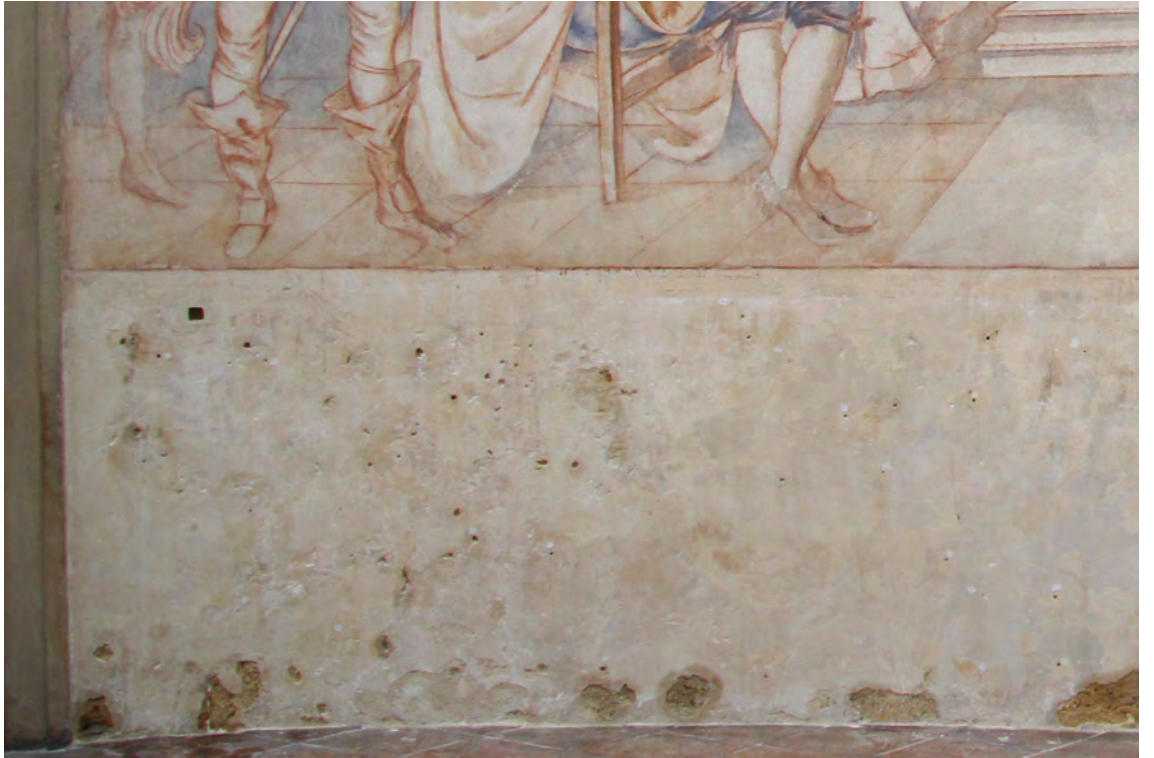
Obr. 42: Levá část soklu; stav po odkrytí, injektáži, odstranění tmelů a strukturálním zpevnění
