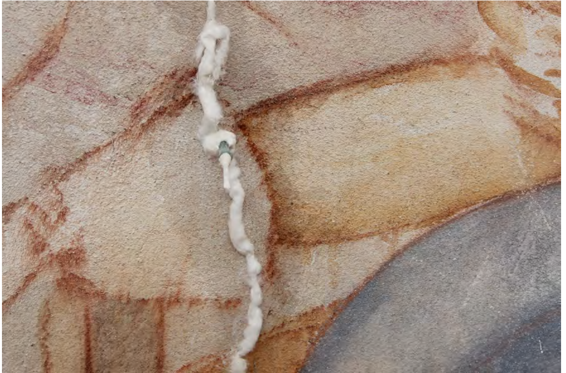
Obr. 34: Průběh injektáže statické trhliny
