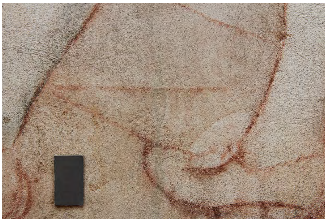
Obr. 59: Detail nejširšího místa statické trhliny; stav po restaurování
