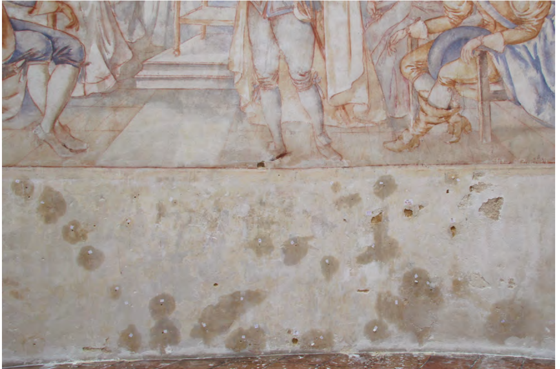
Obr. 36: Průběh injektáže omítky soklu
