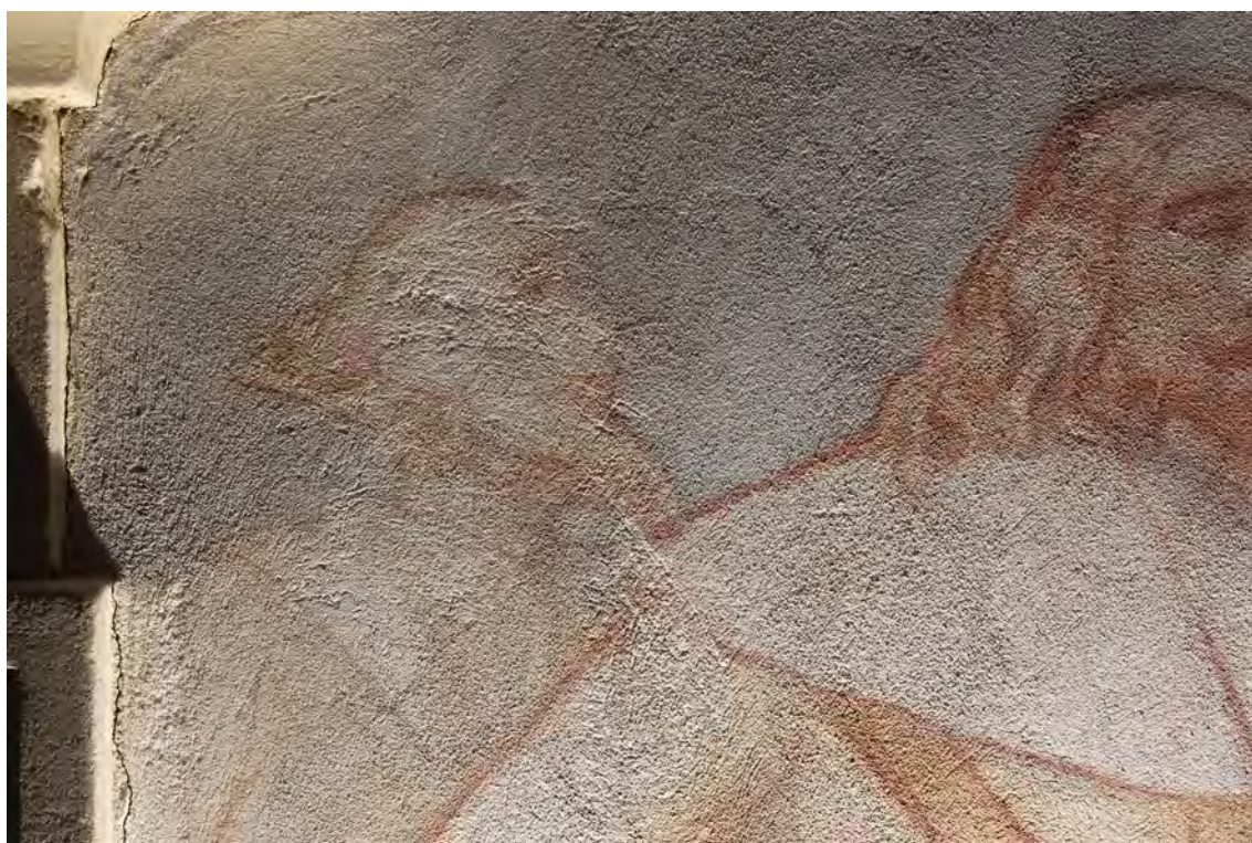
Obr. 11: Průzkum v ostrém bočním světle - detail hlavy muže při levém okraji malby; okolo ostění je zná statická trhlinka, v oblasti hlavy je omítka poškozena vrypy
