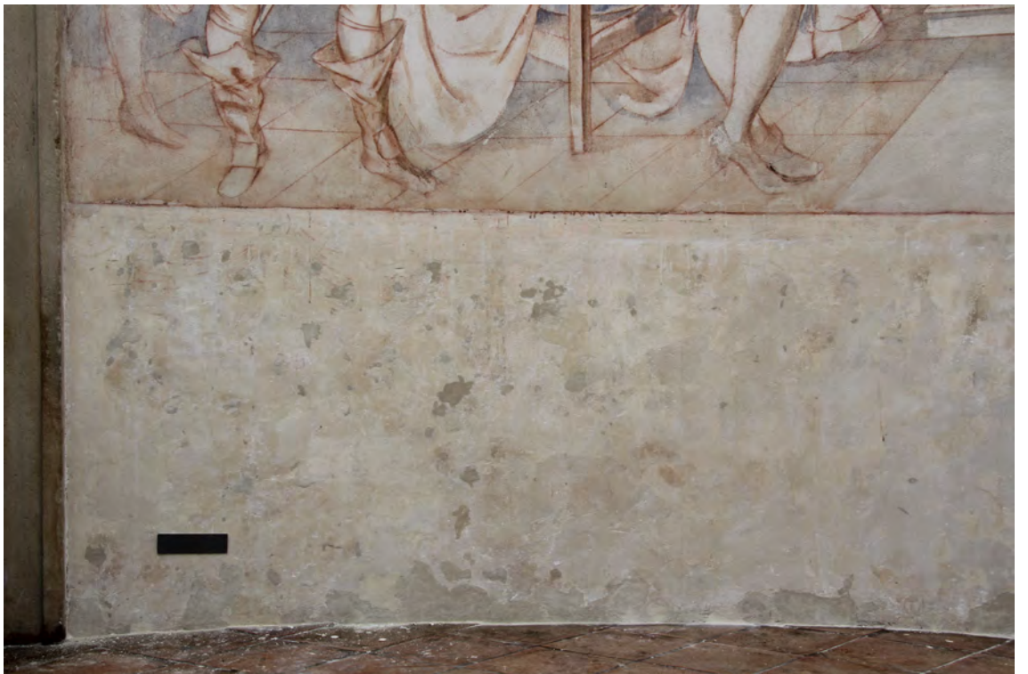
Obr. 43: Levá část soklu po vytmelení
