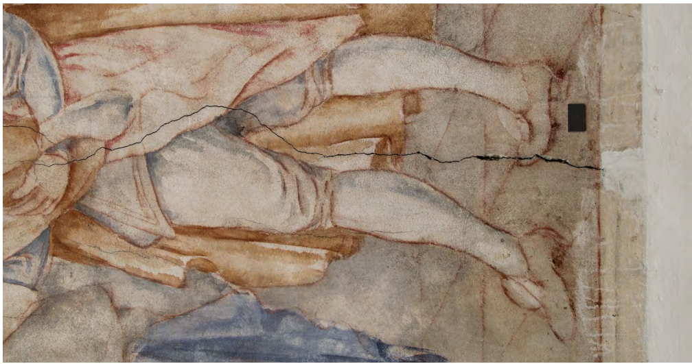
Obr. 52: Muž vpravo - statická trhлина; stav před restaurováním
