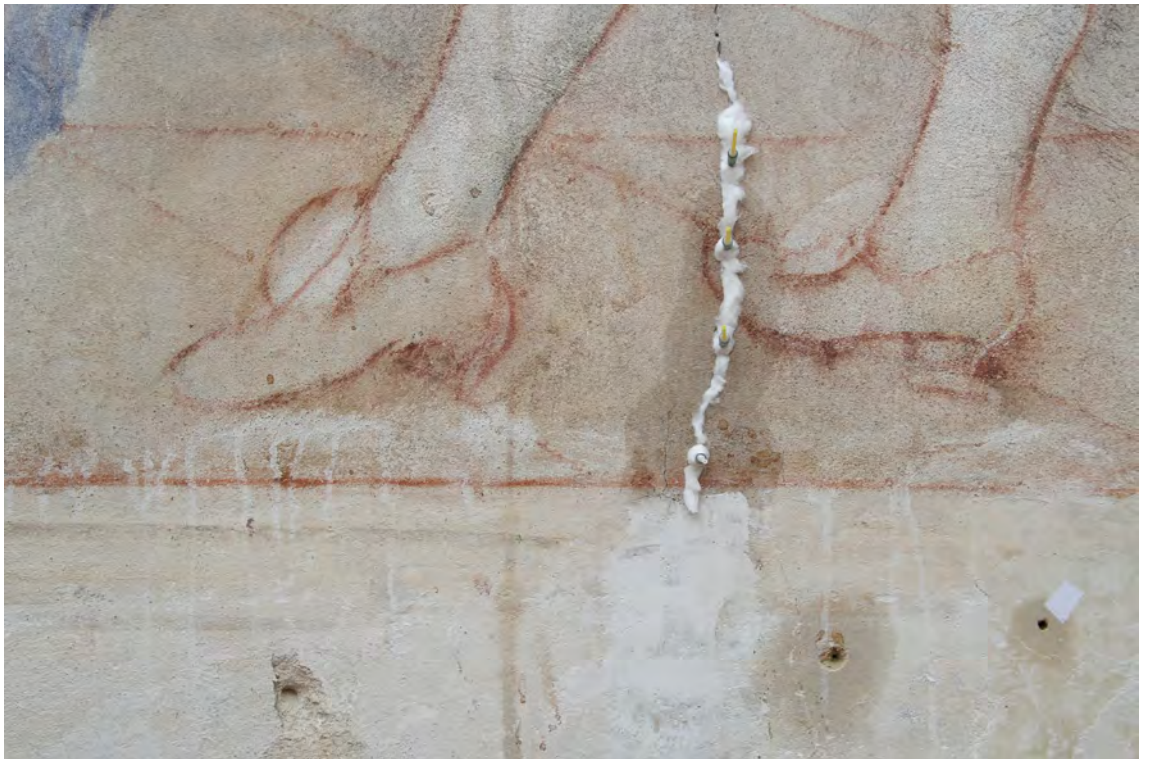
Obr. 35: Průběh injektáže statické trhliny - muž stojící vlevo
