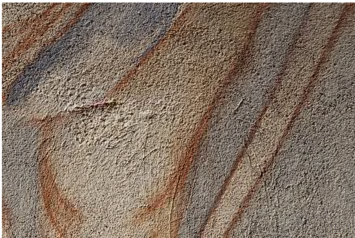
Obr. 10: Průzkum v ostrém bočním světle - detail nohy muže stojícího vlevo; na povrchu jsou zřetelné stopy po úpravě povrchu filcovým hladítkem
