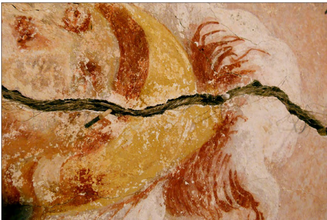
Obr. 84: Vyplnění statické trhliny koudelí; kaple sv. Kříže, Slavonice (zdroj: KRHÁNKOVÁ, K. a kol. 2014)
