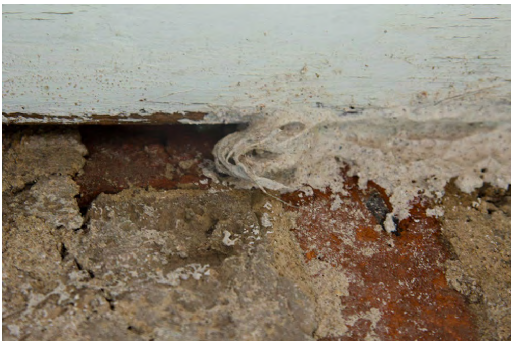
Obr. 87: Výplnění dilatační trhliny koudelí namočenou v jemném štuku (zdroj: osobní archiv Davida Svobody )
