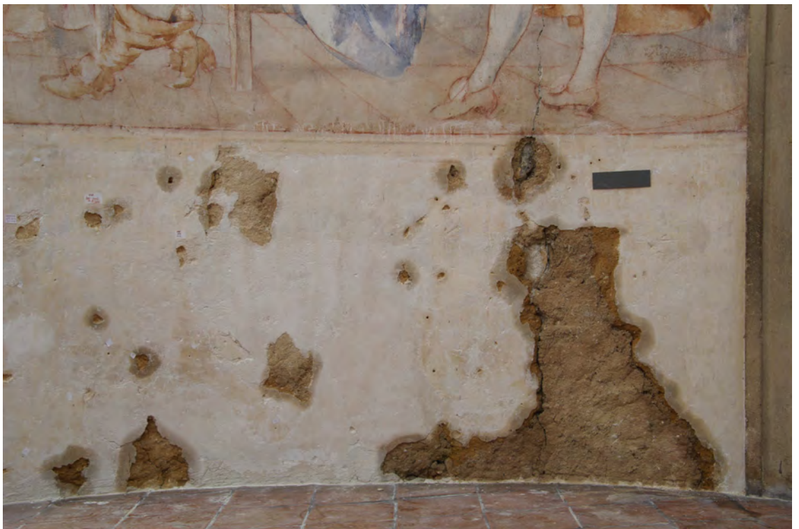
Obr. 37: Pravá část soklu; stav po odkrytí bílých hlinkových nátěrů, injektáži a odstranění nevhodných nebo nepevných tmelů
