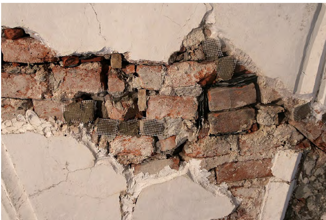
Obr. 85: Opatření dubových klínů skelnou mřížkou, je zajištěna lepší přilnavost tmelící malty (zdroj: VOJTĚCHOVSKÝ, J., 2010)
