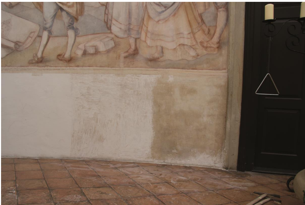
Obr. č. 47: Průběh snímání bílých hlinkových nátěrů z historické omítky.
