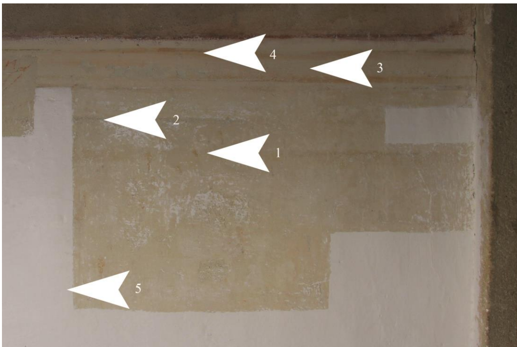
Obr. č. 3: Sonda 10SZ 15 , ze soklové části severozápadní stěny.
