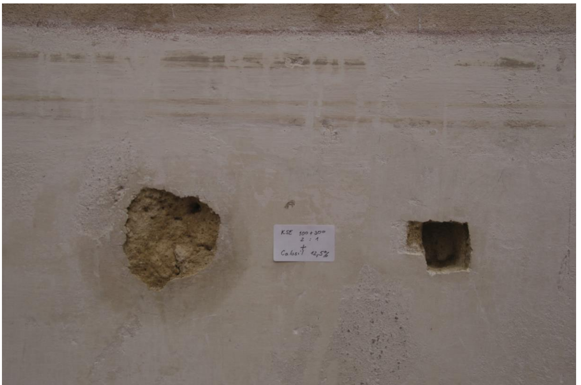
Obr. č. 51: Odstraněný nevyhovující druhotný tmel po zpevnění prostředky KSE 100, KSE300 HV (2:1) a prostředkem CaLoSil.
