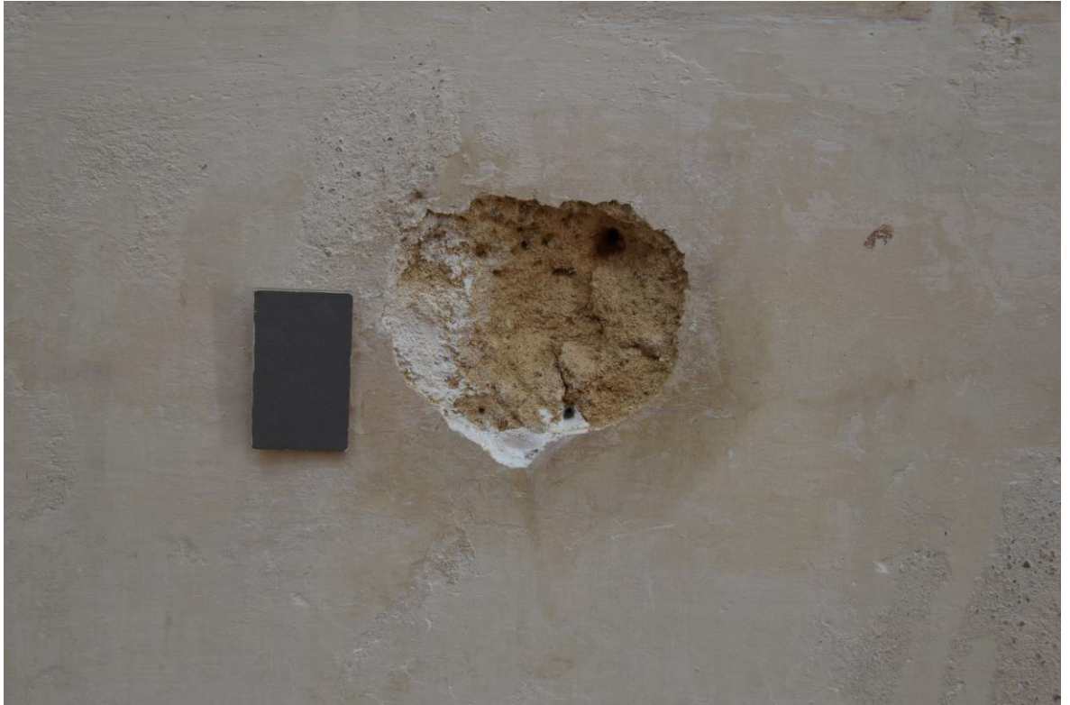
Obr. č. 50: Odstraněný nevyhovující druhotný tmel po injektáži.
