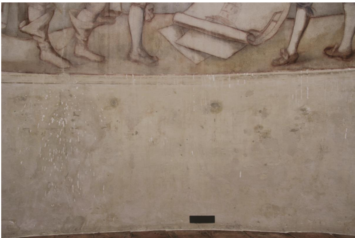
Obr. č. 78: Středová část historické omítky, v levé části fotografie zatřené stékance vápennou barvou s pigmenty a 2,5% K9.
