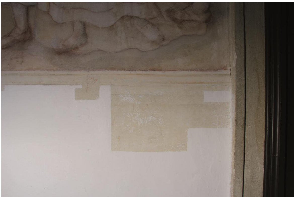
Obr. č. 35: Sonda 10SZ 15 , zde vidíme několik fragmentů linek na okrové historické omítce.
