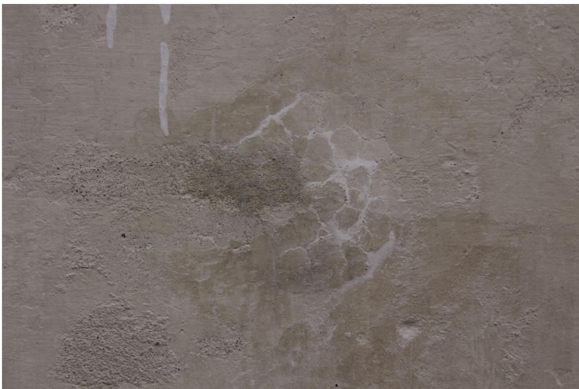
Obr. č. 55: Detail vyinjektované historické omítky.
