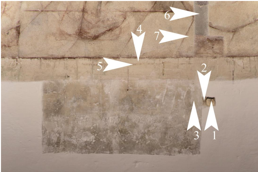
Obr. č. 6: Část sondy 2JV 84 , sondy 1JV 13 a 2JV 15 , jihovýchodní stěna. (Zdroj: foto Romana Rajtárová) 1) Cihlové zdivo, 2) Historické jádro (okrové), 3) Historický štuk, 4) Okrový nátěr, 5) Fragменты zelenohnědé linky, 6) Malba ve fresce – pentimenti, 7) Pastózní nános barevné vrstvy na překrytí pentimentů.
