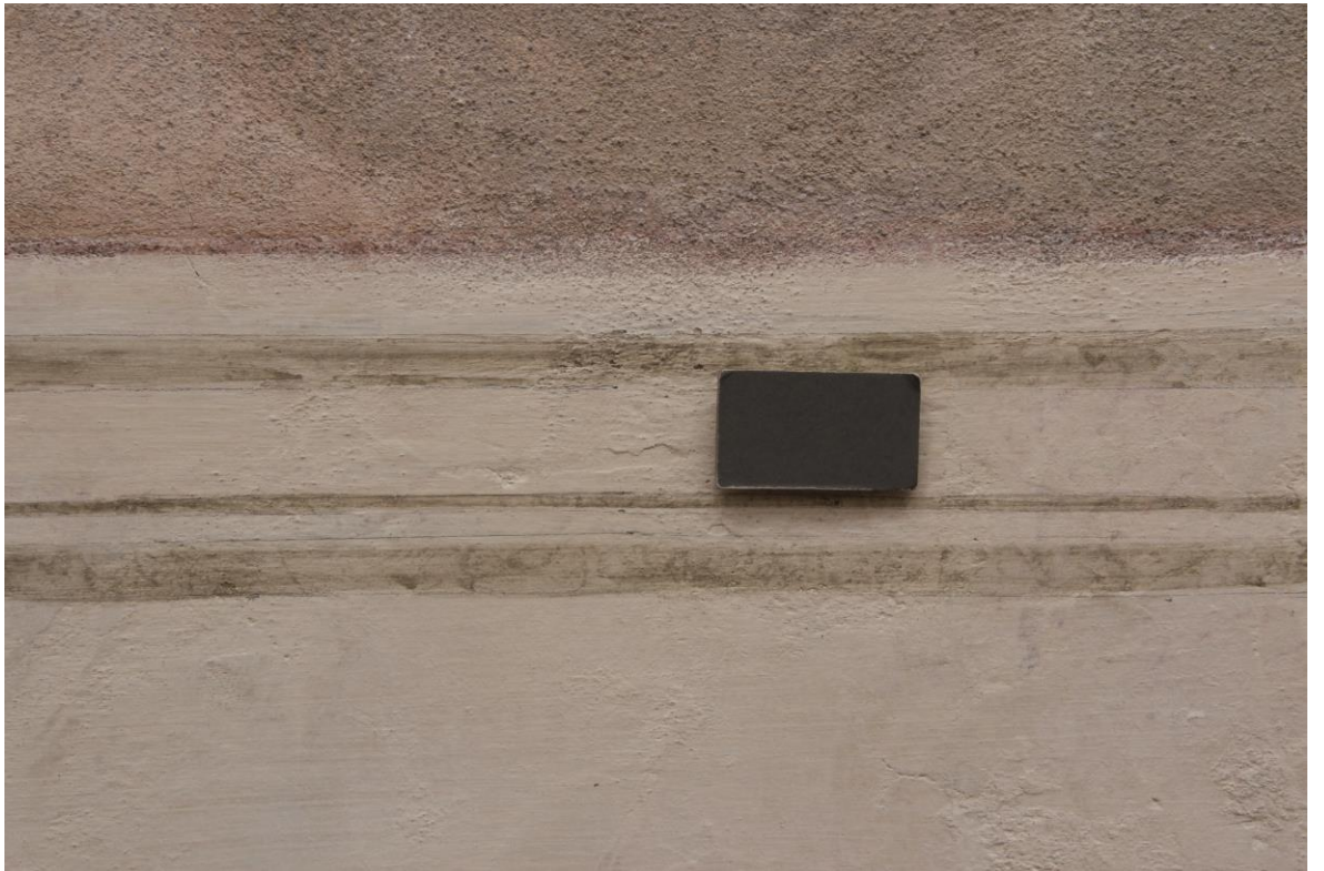
Obr. č. 80: Detail rekonstrukce zelených linek.
