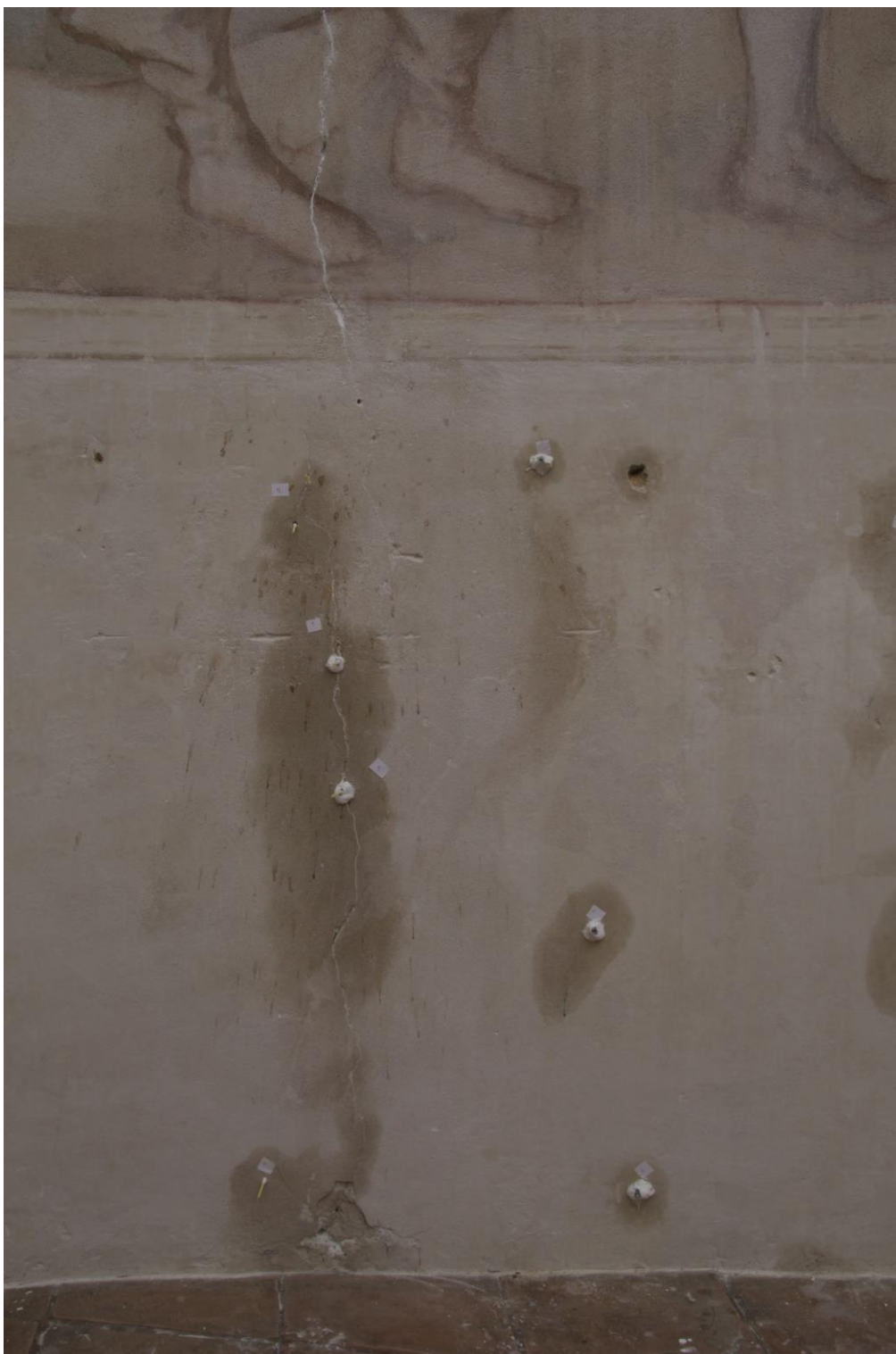
Obr. č. 49: Detail z průběhu injektáže historické omítky.
