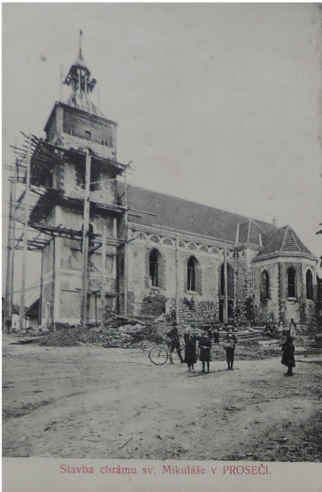
Obr. 117: Proseč u Skutče, stavba nového kostela sv. Mikuláše, 1912. Farní kronika, s. 373, uložena na faře, Římskokatolická farnost Proseč u Skutče.
