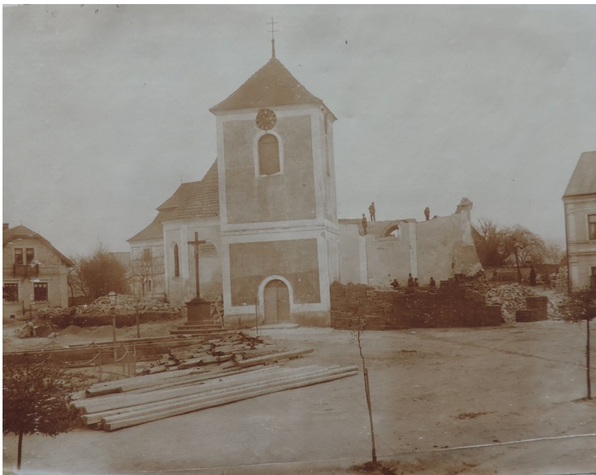
Obr. 116: Proseč u Skutče, původní kostel sv. Mikuláše – bourání kostela, 1912. Farní kronika, s. 249, uložena na faře, Římskokatolická farnost Proseč u Skutče.
