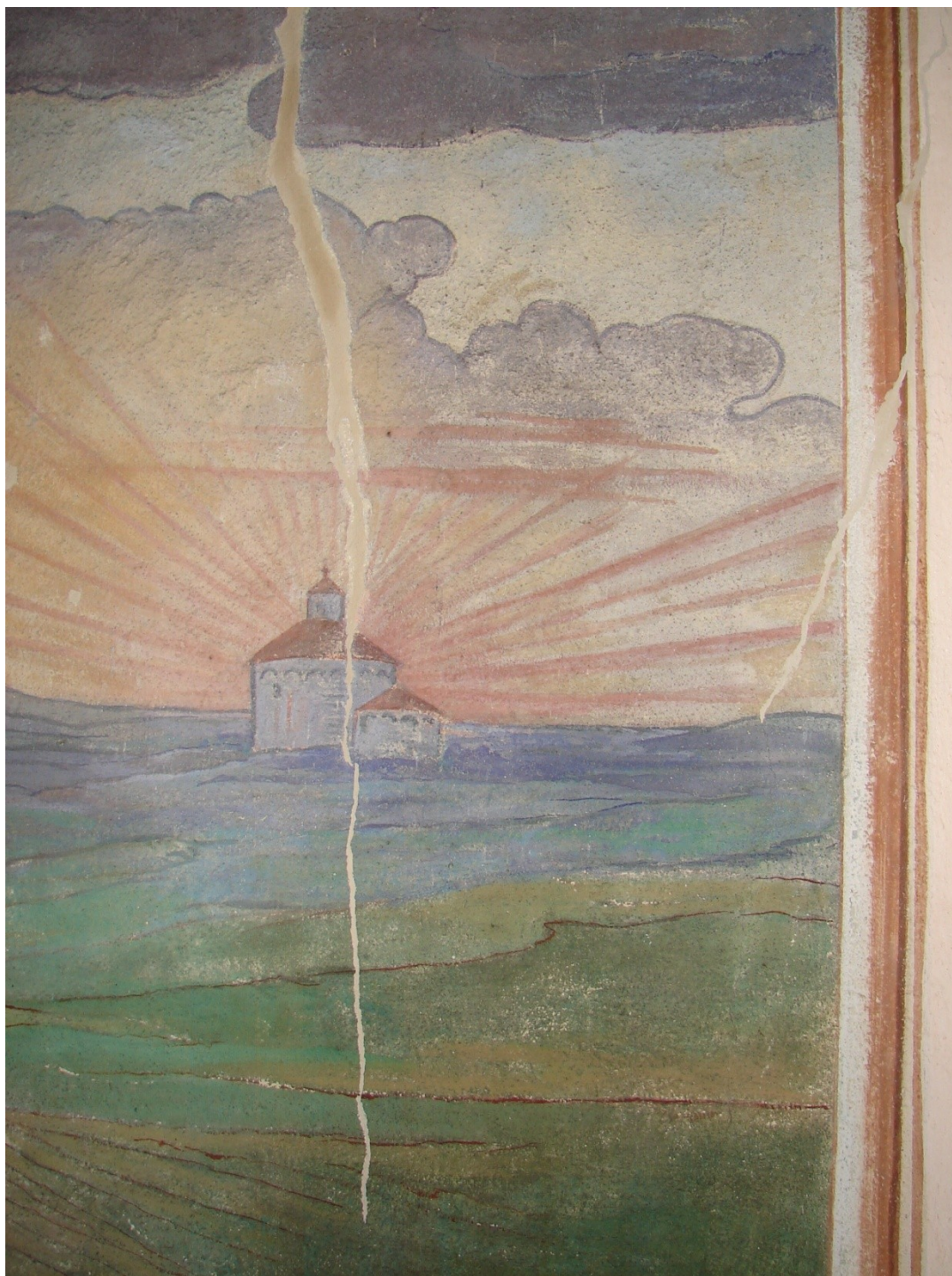
Obr. 40: Stav po nanesení tónovaného pačoku. Foto: S. Běťáková.
