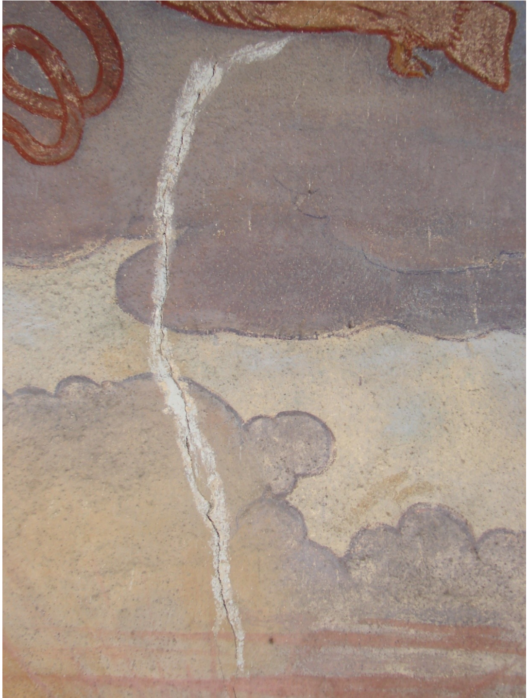
Obr. 33: Trhlina odhalená vyjmutím druhotného sádrového tmelu. Foto: S. Běřáková.
