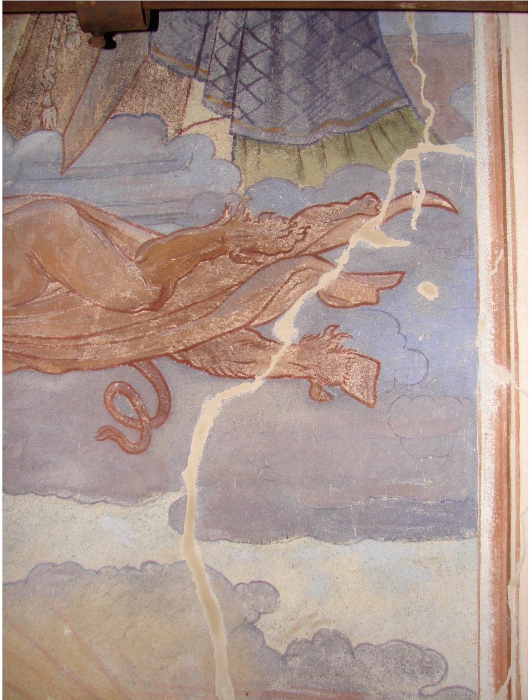
Obr. 39: Vytmelení defektů v malbě a nanesení tónovaného pačoku. Foto: S. Běťáková.
