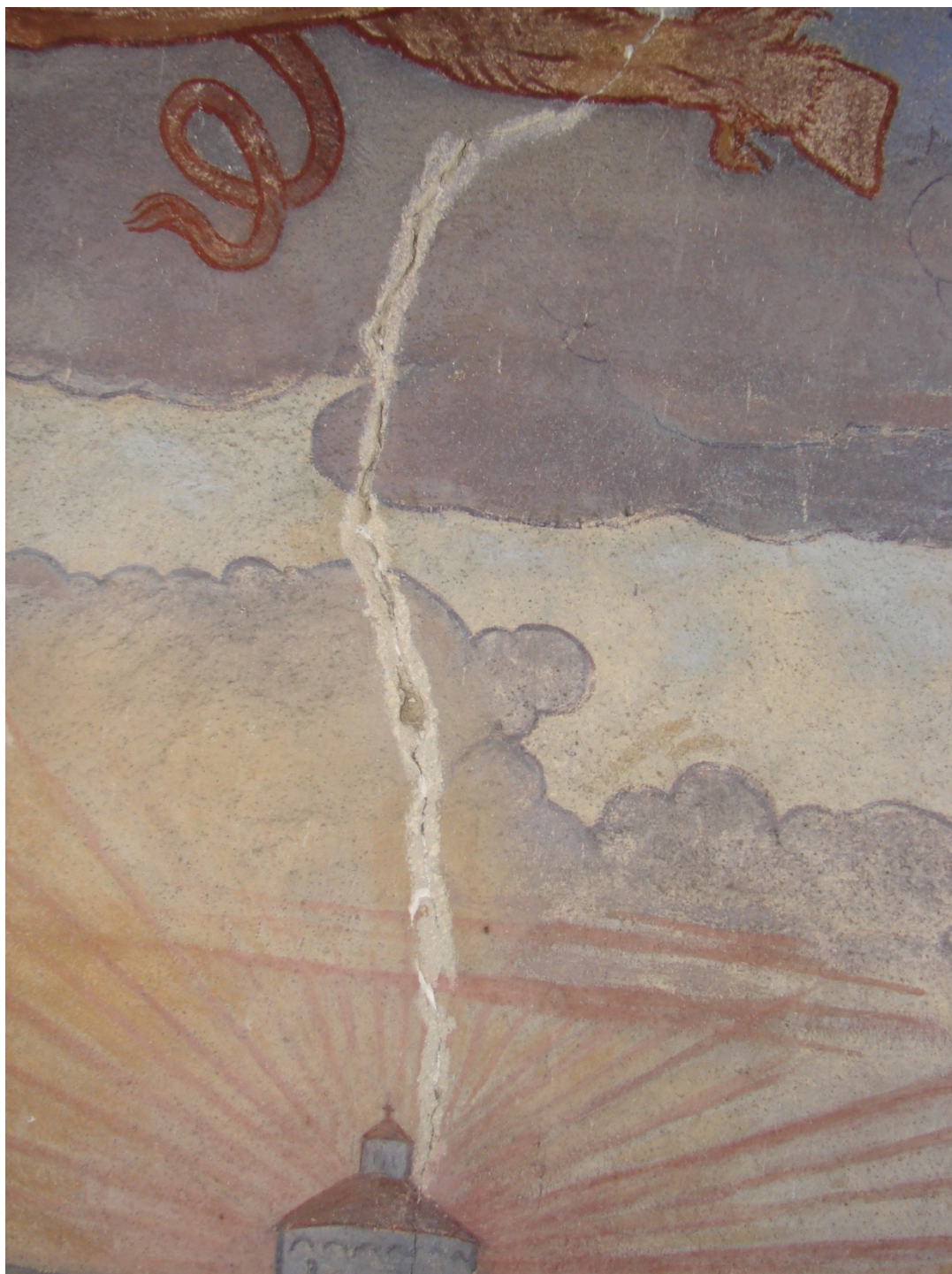
Obr. 34: Injektáž trhliny prostupující malbou. Foto: S. Běťáková.
