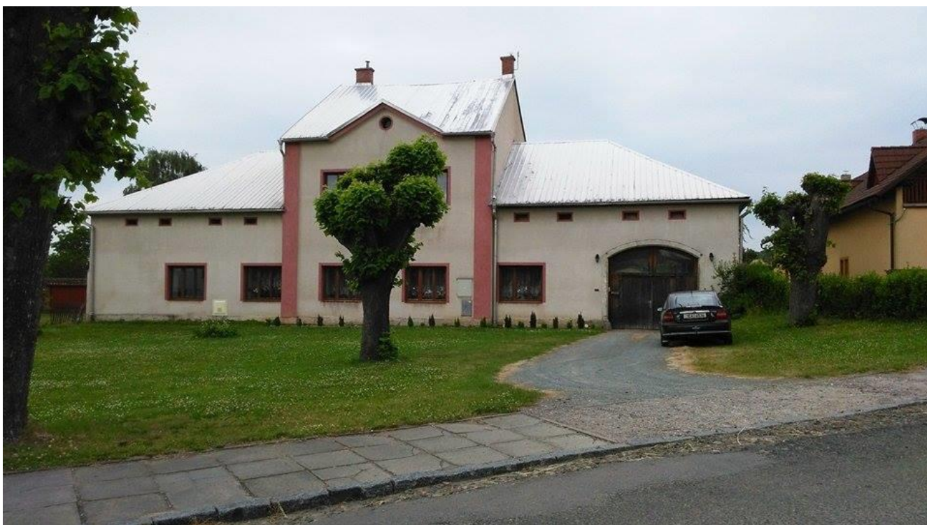
Obrázek č. 22: Fotografie budovy v obci
