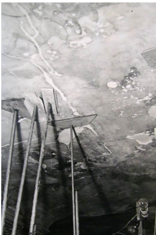
Obr. 150 Výmalba schodiště paláce Sylva-Taroucca Na Příkopěch v Praze. Průběh restaurování v roce 1962. Podpírání destruované nástropní malby a tmelení.
