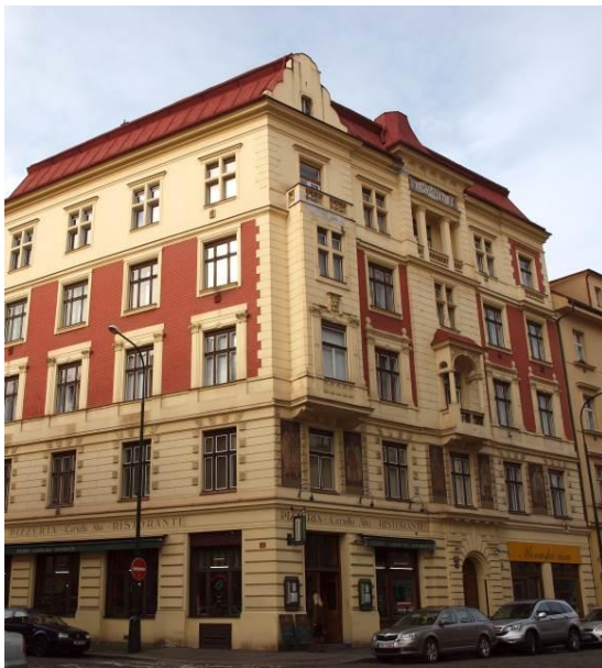
Obr. 113 Otakar Václavík. Novorenesanční budova postavená na místě původního domu „U Pěti králů“ (1905).
