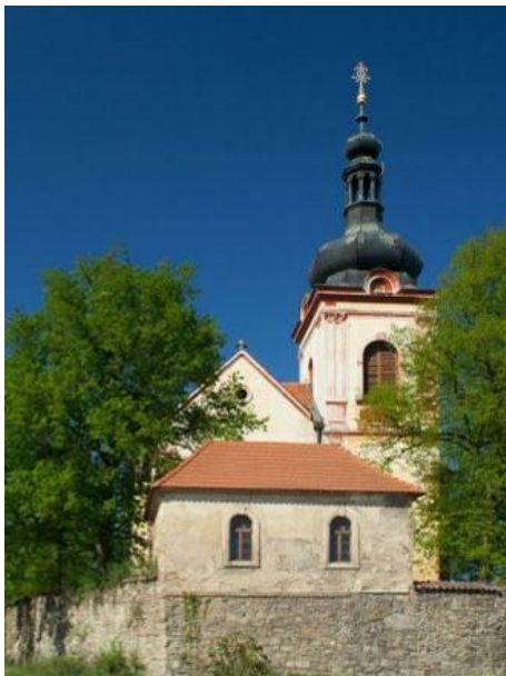
Obr. 116 Kostel sv. Havla v Neveklově.
