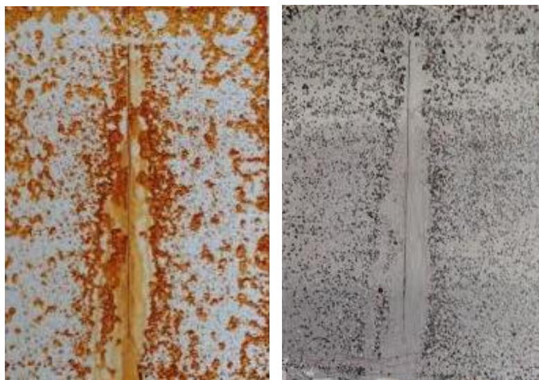
Obr. 23: Nátěr Eternal na kovy podrobený korozní zkoušce v mlze NaOH, nalevo po 480 hodinách v solné komoře, napravo po stažení nátěru
