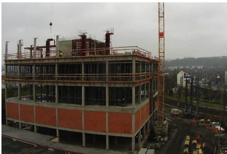
Obr. 6 Budova CDP Praha ve výstavbě
