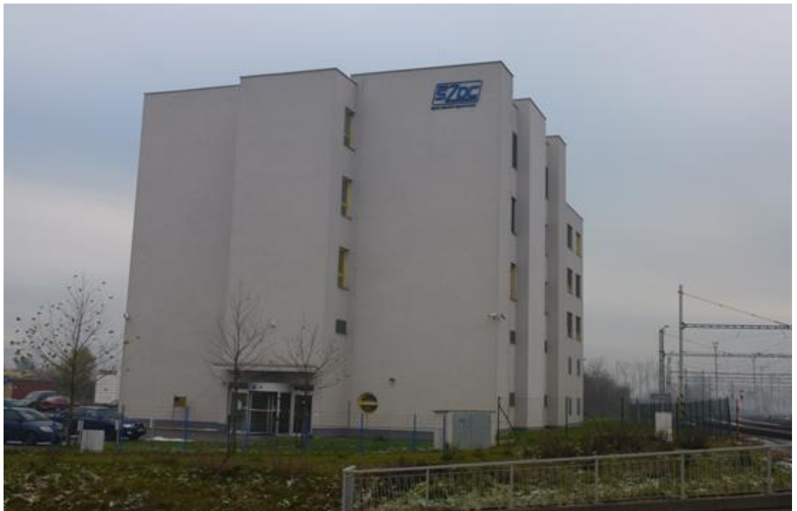
Obrázek 2 Budova CDP Přerov – bližší pohled
