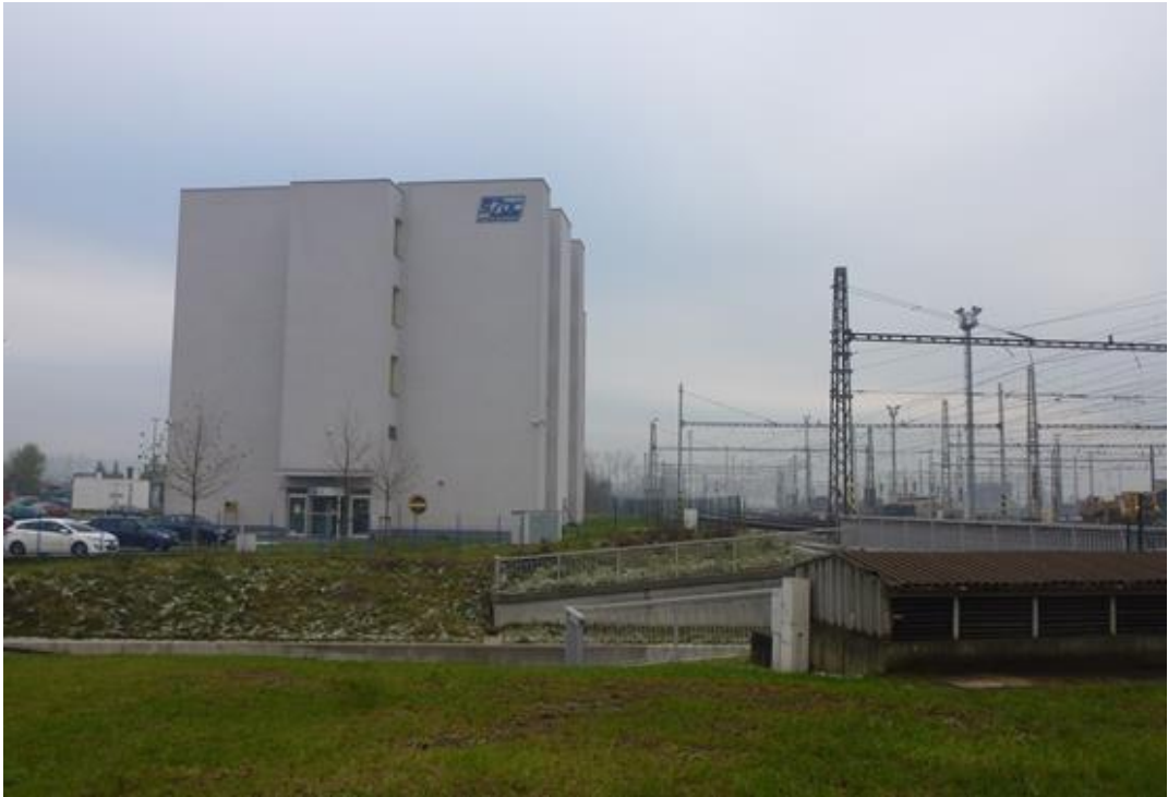
Obrázek 1 Budova CDP Přerov
