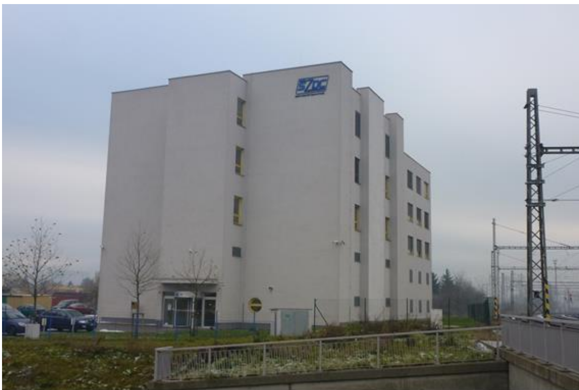
Obr. 4 Budova CDP Přerov
