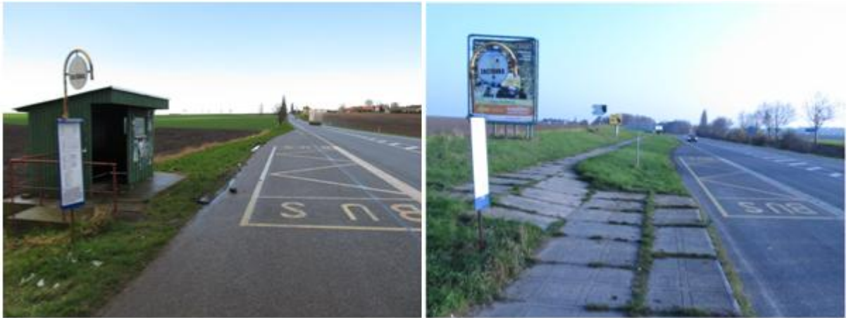
Obr. 15 Zastávka Všeštery, Rozběřice, st. sil.
