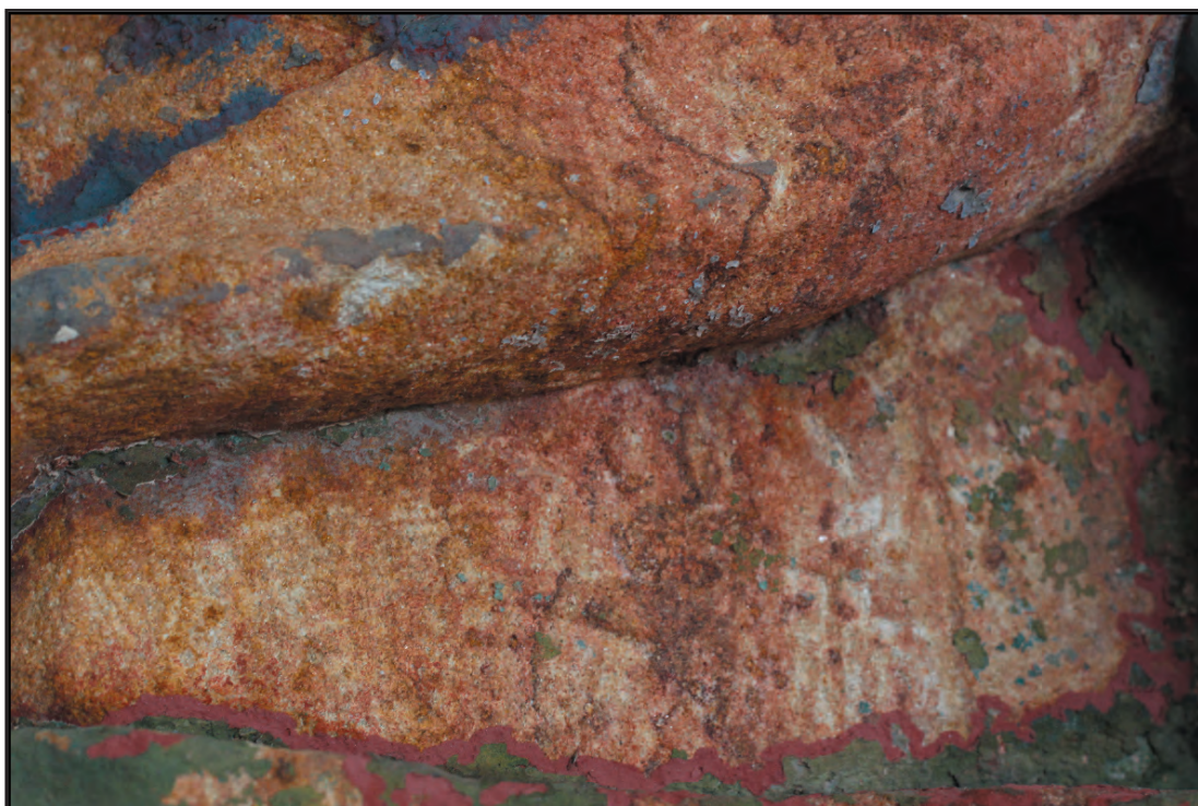
Obr. 77 Záda Panny Marie. Odloučená polychromie obnažuje povrch kamene a ukazuje jeho kresbu.
