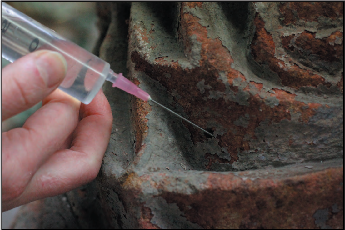
Obr. 40 Připevnění odpadávajících šupin polychromie zpět ke kameni, injektáž roztokem paraloidu B 72.
