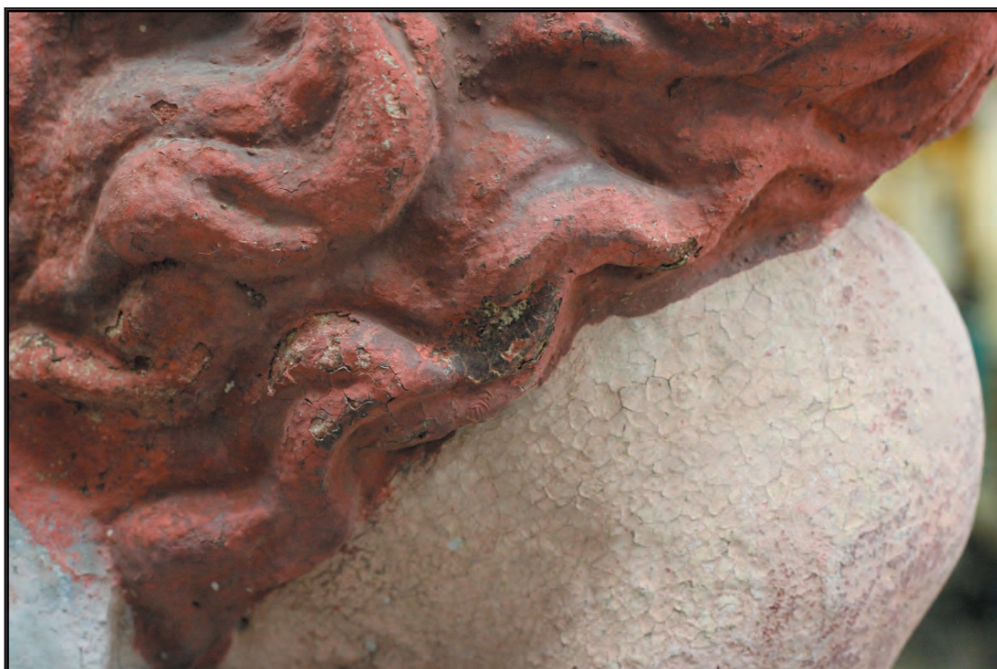
Obr. 48 Odkryv původní dochované tmavě - hnědé úpravy vlasů Krista.
