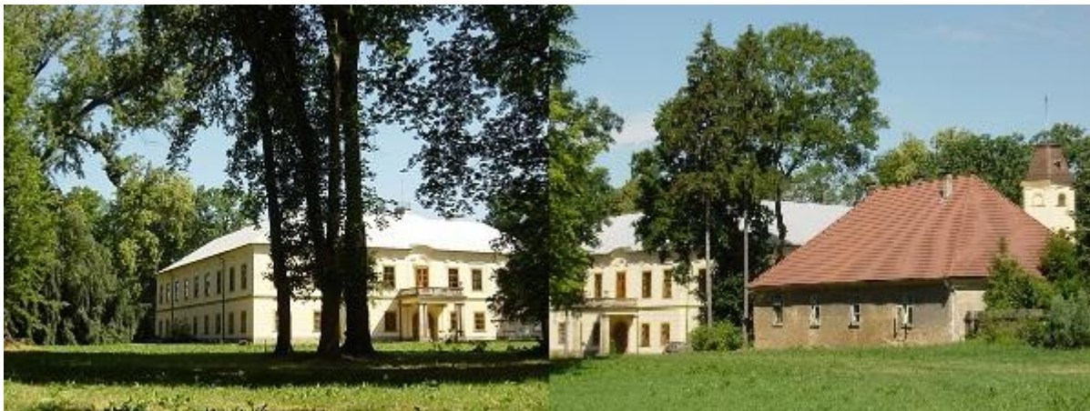
Obrázek 19: Jeřice: zámek a bývalé zemědělské budovy
