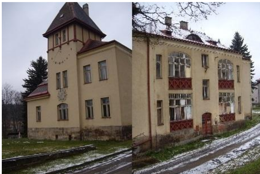
Obrázek 29: Mostek: bývalá škola
