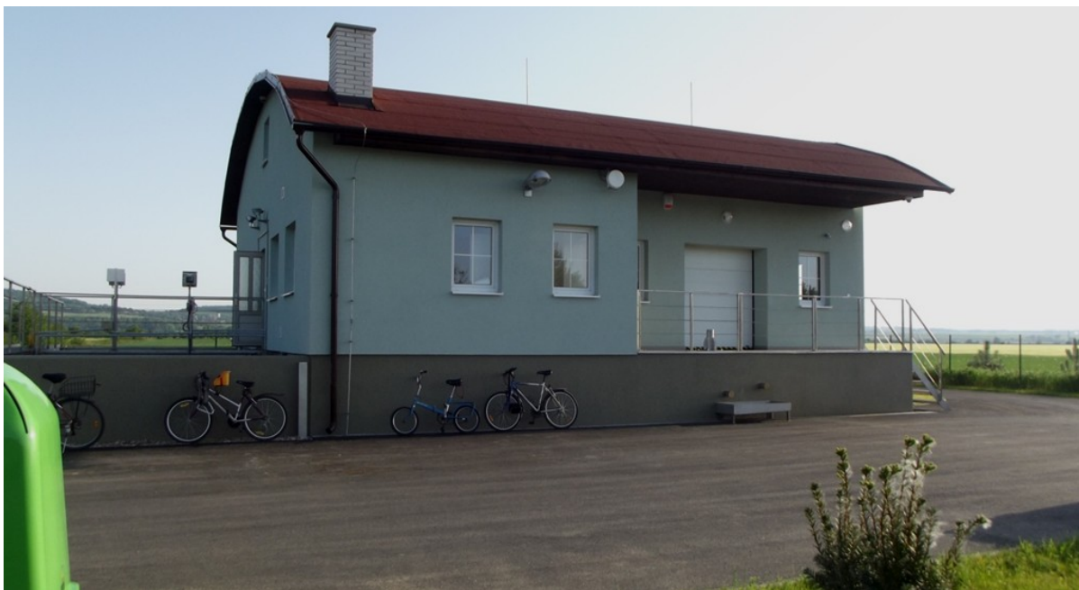
Budova čistírny odpadních vod
