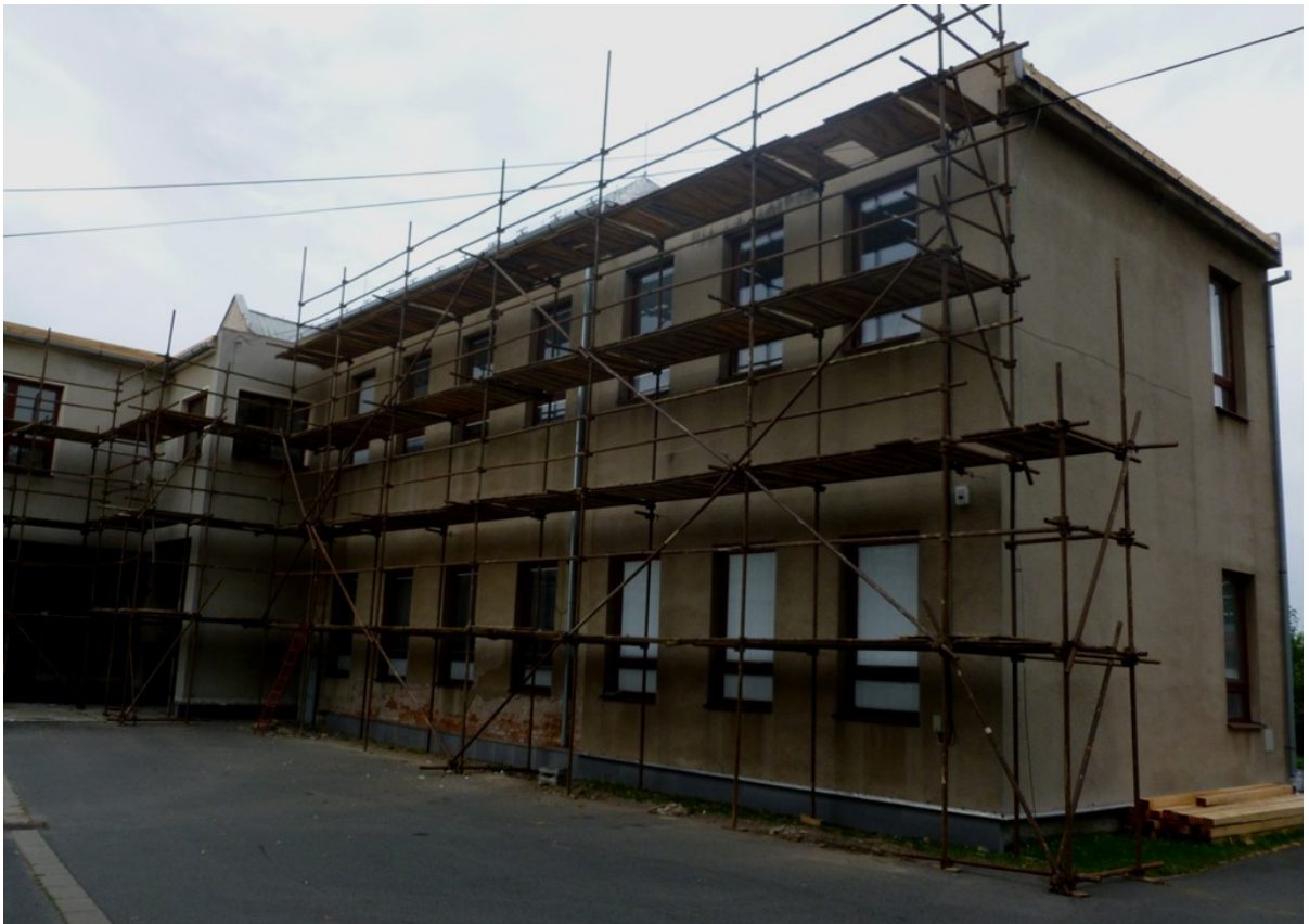
Základní škola před rekonstrukcí
