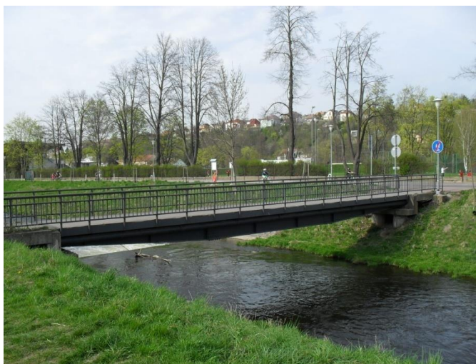
Obrázek 20 Lávka spojující ulici Na Ostrově a Jungmannovo nábřeží
