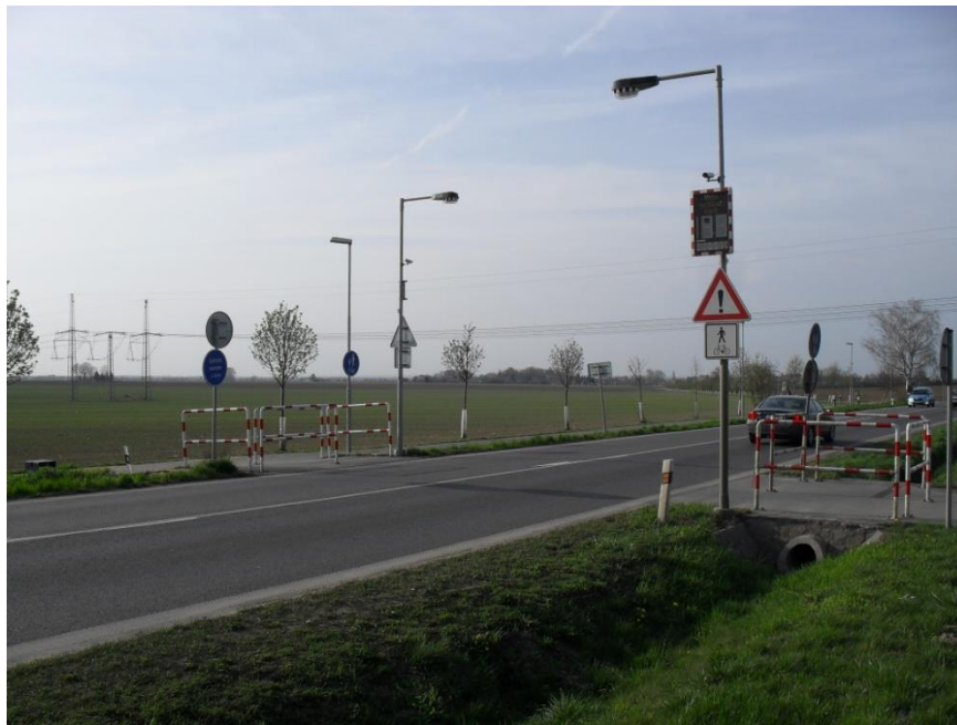
Obrázek 33 Přechod přes komunikaci I/37
