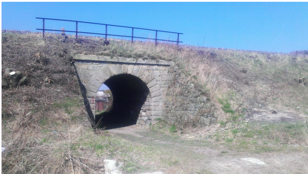
Obrázek 9 Kamenný obloukový železniční most
