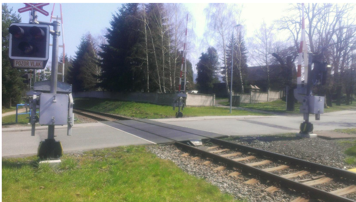
Obrázek 4 Železniční přejezd km 36.197
