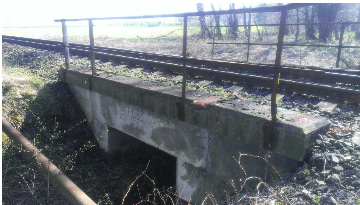
Obrázek 20 Rámový betonový propustek km 41.287
