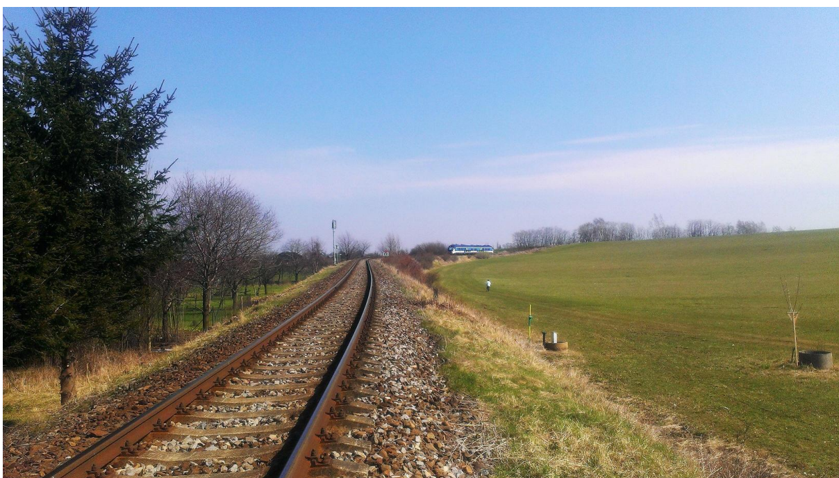
Obrázek 16 Oblouk R 273 m, násypové těleso km 40.000
