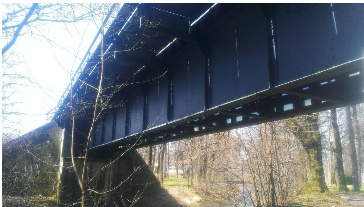
Obrázek 8 Ocelový železniční most km 36.712 (nebude snášen)
