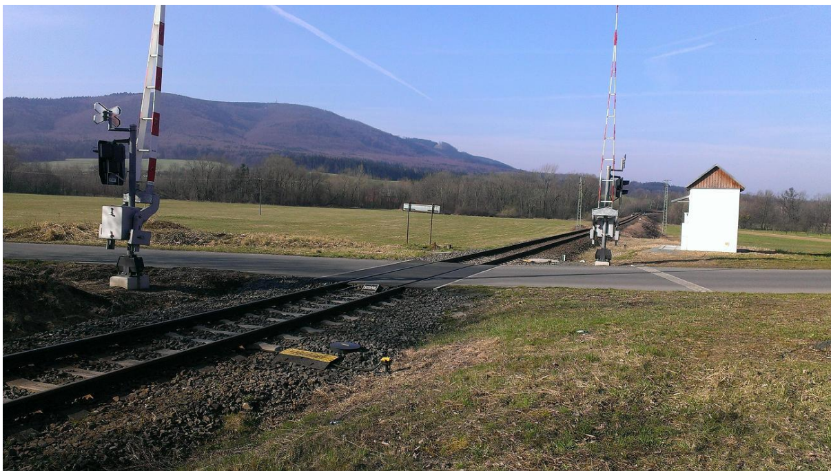
Obrázek 35 Železniční přejezd km 46.313
