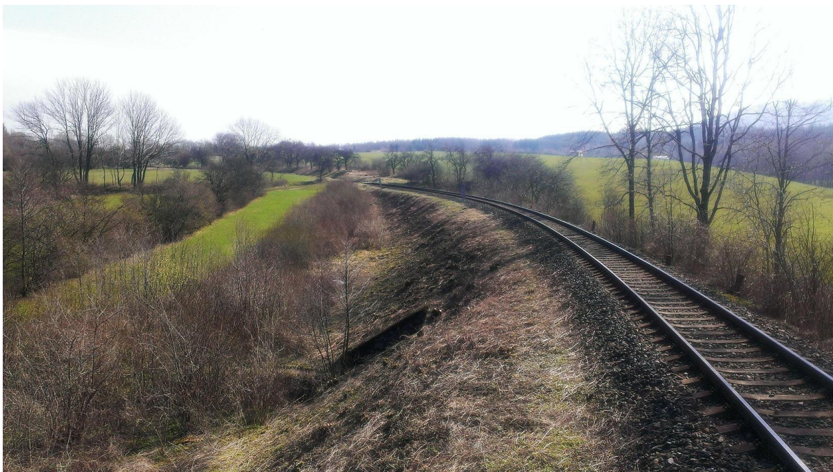
Obrázek 17 Oblouk R 272 m, násypové těleso km 40.755
