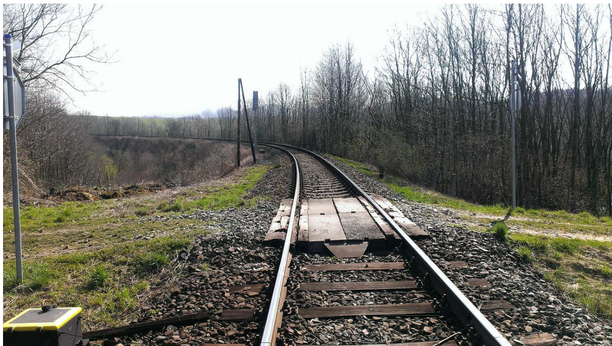
Obrázek 27 Železniční přejezd km 42.868
