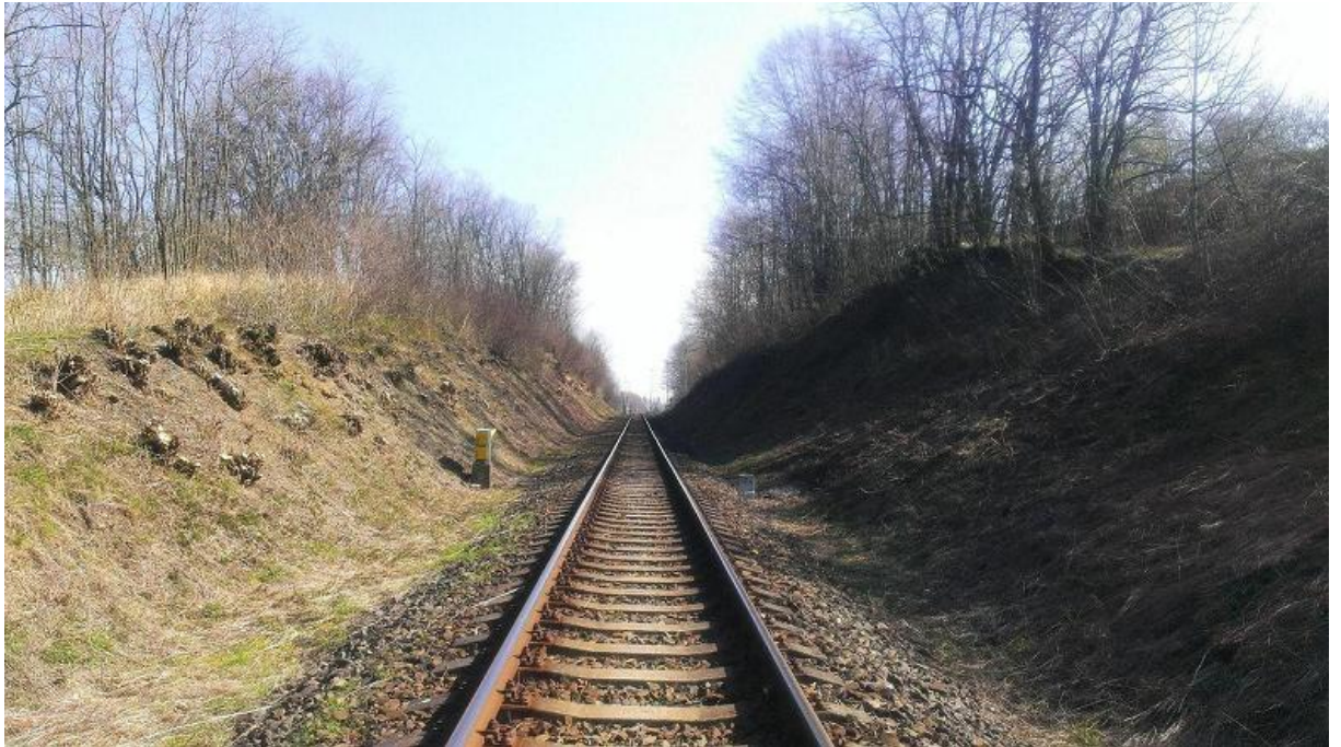
Obrázek 21 Přímý úsek v zářezu km 41.650
