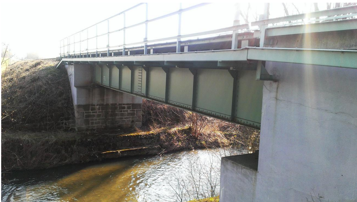
Obrázek 34 Ocelový železniční most km 45.962 (nebude snášen)
