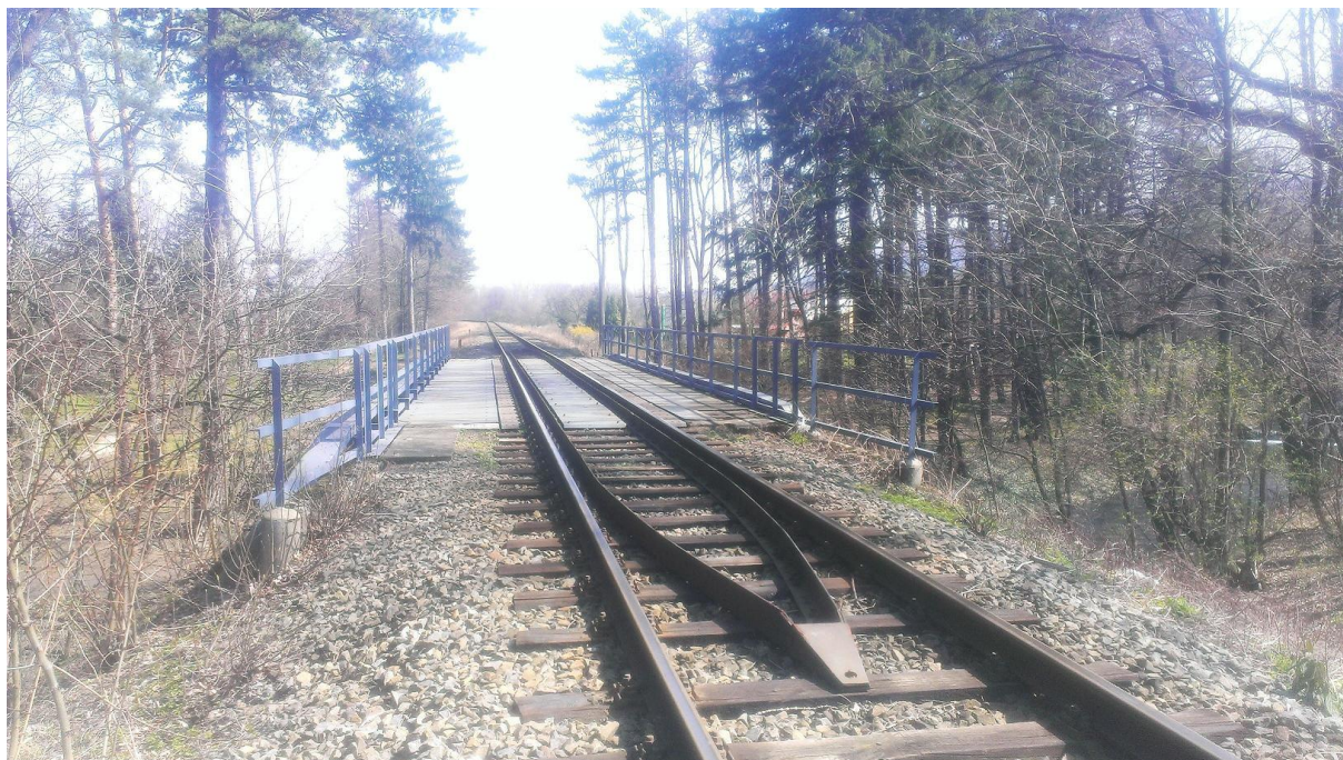
Obrázek 7 Ocelový železniční most km 36.712 (nebude snášen)
