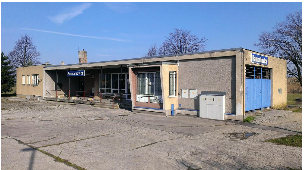
Obrázek 38 Nákladiště a zastávka Rajnochovice Výpravní budova
