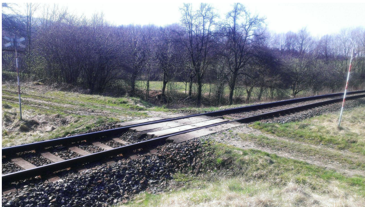
Obrázek 19 Železniční přejezd km 40.890
