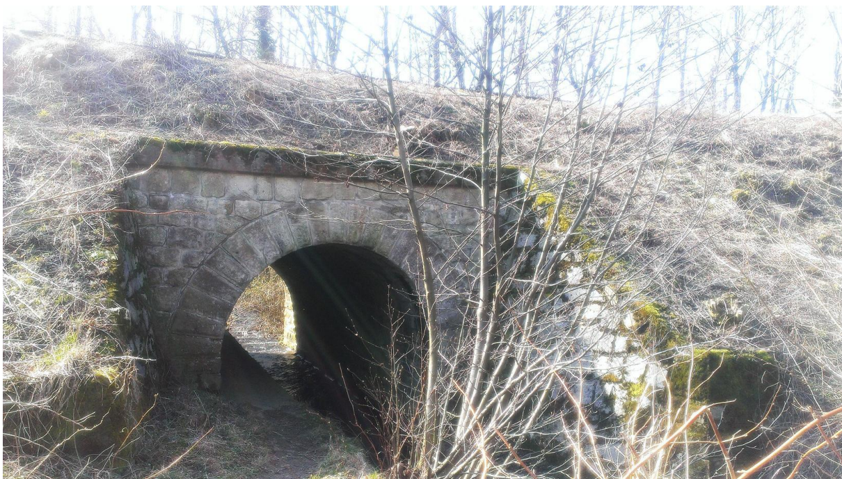
Obrázek 18 Kamenný klenbový propustek km 40.754
