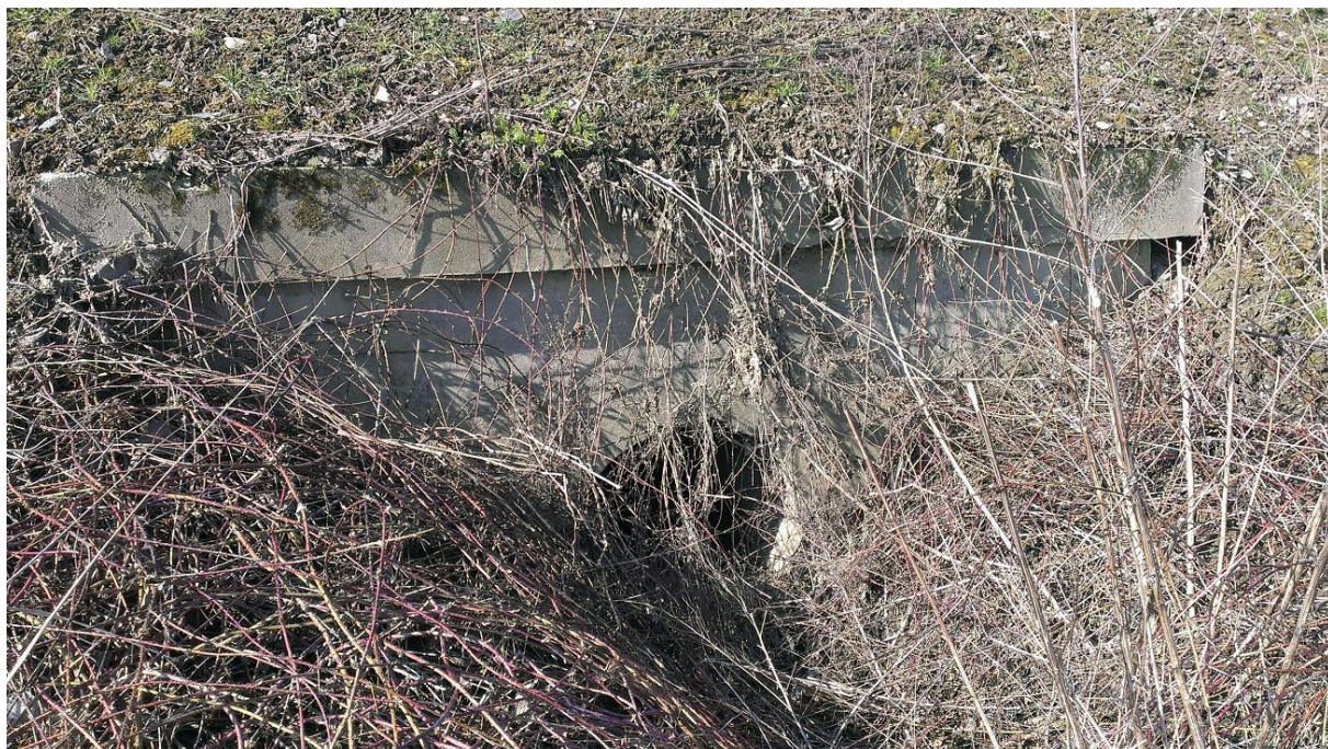
Obrázek 31 Trubní propustek km 44.023
