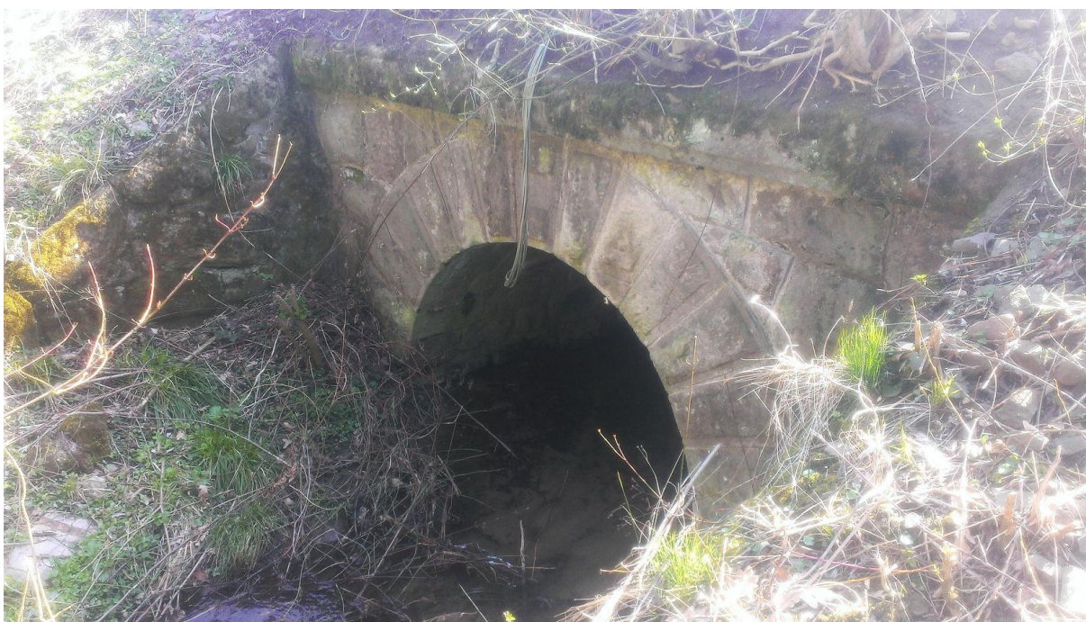
Obrázek 12 Kamenný klenbový propustek km 39.070
