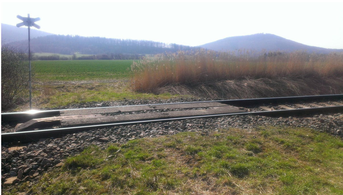
Obrázek 11 Železniční přejezd km 38.827
