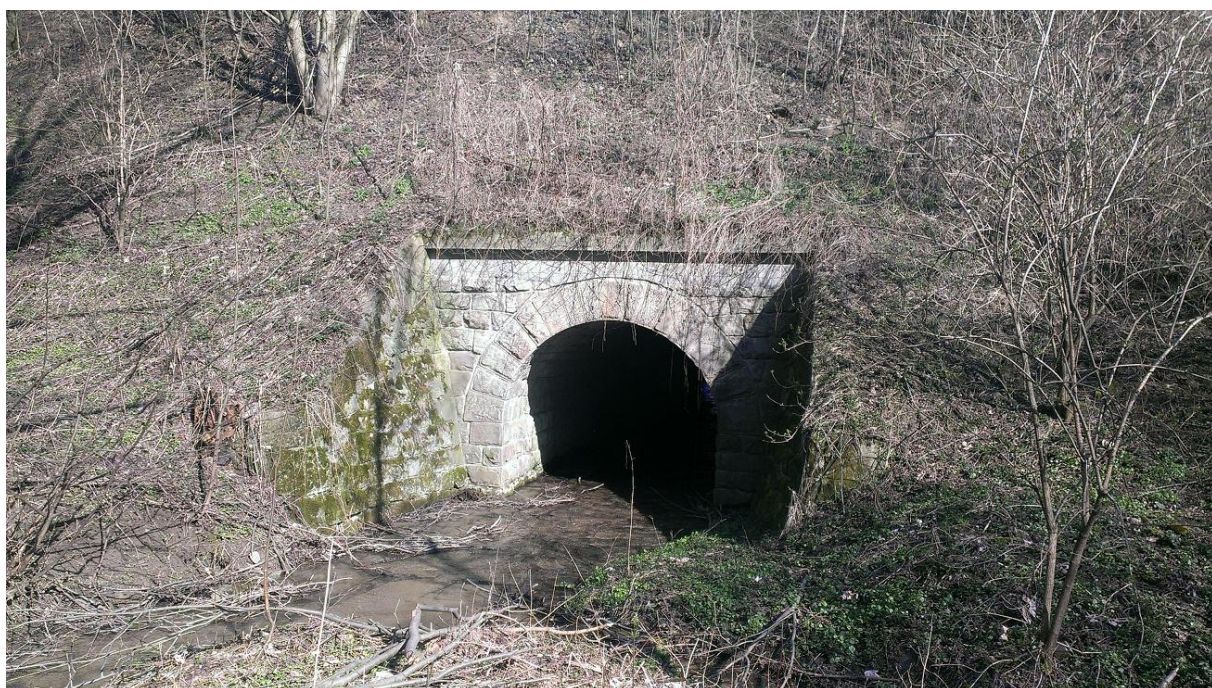
Obrázek 28 Kamenný klenbový propustek km 42.980
