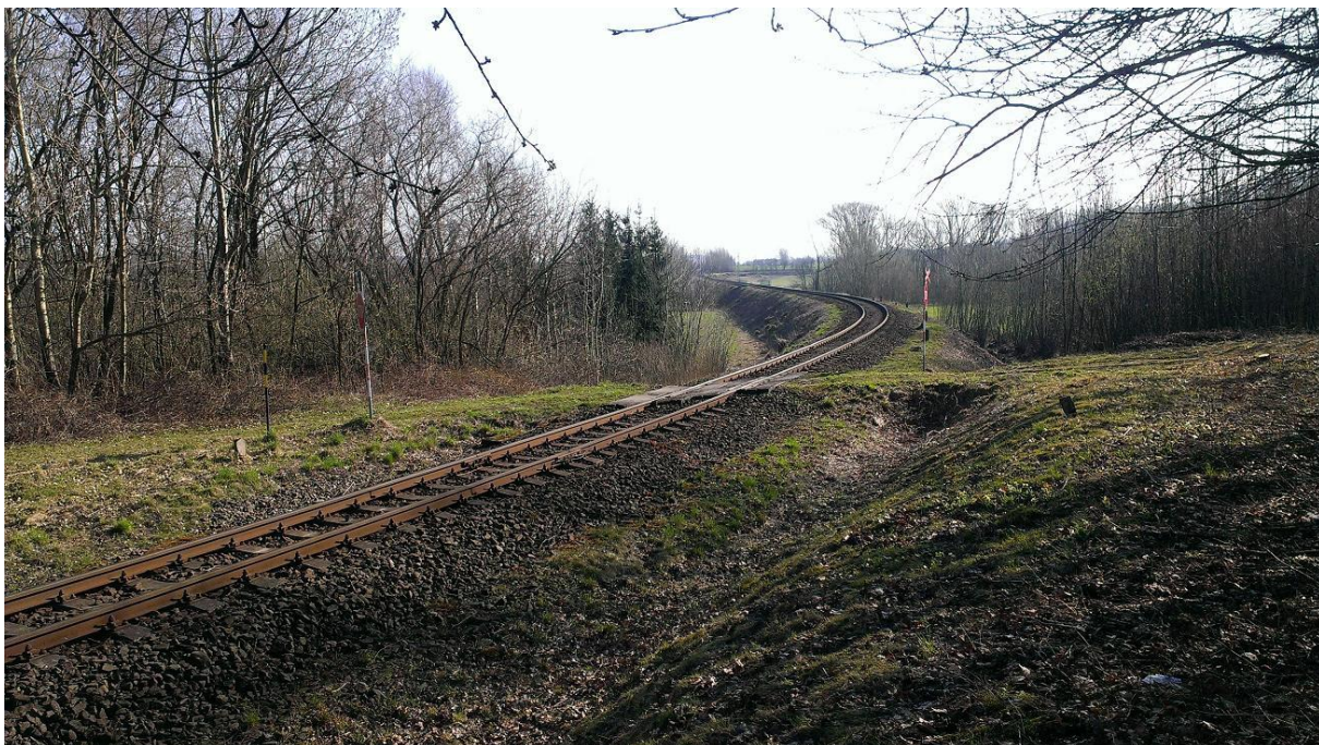
Obrázek 33 Železniční přejezd km 45.747
