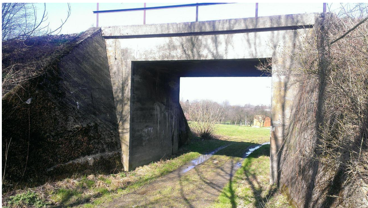
Obrázek 29 Železniční betonový most km 43.247
