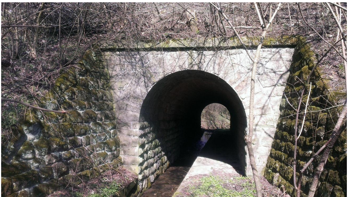
Obrázek 22 Kamenný klenbový propustek km 41.861
