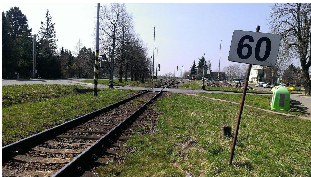
Obrázek 2 Železniční přejezd km 35.293
