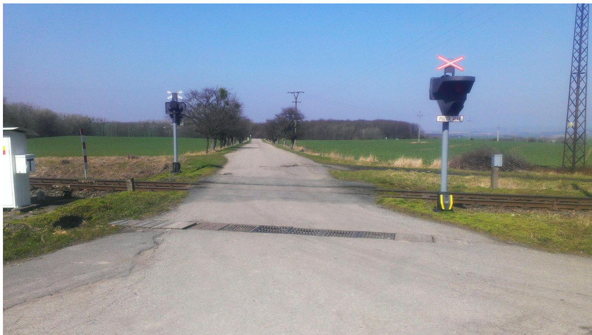
Obrázek 13 Železniční přejezd km 39.206
