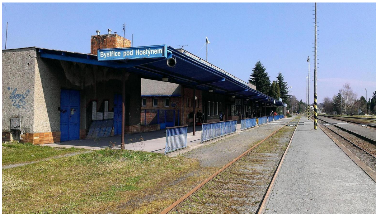
Obrázek 1 Žst. Bystřice pod Hostýnem Výpravní budova
