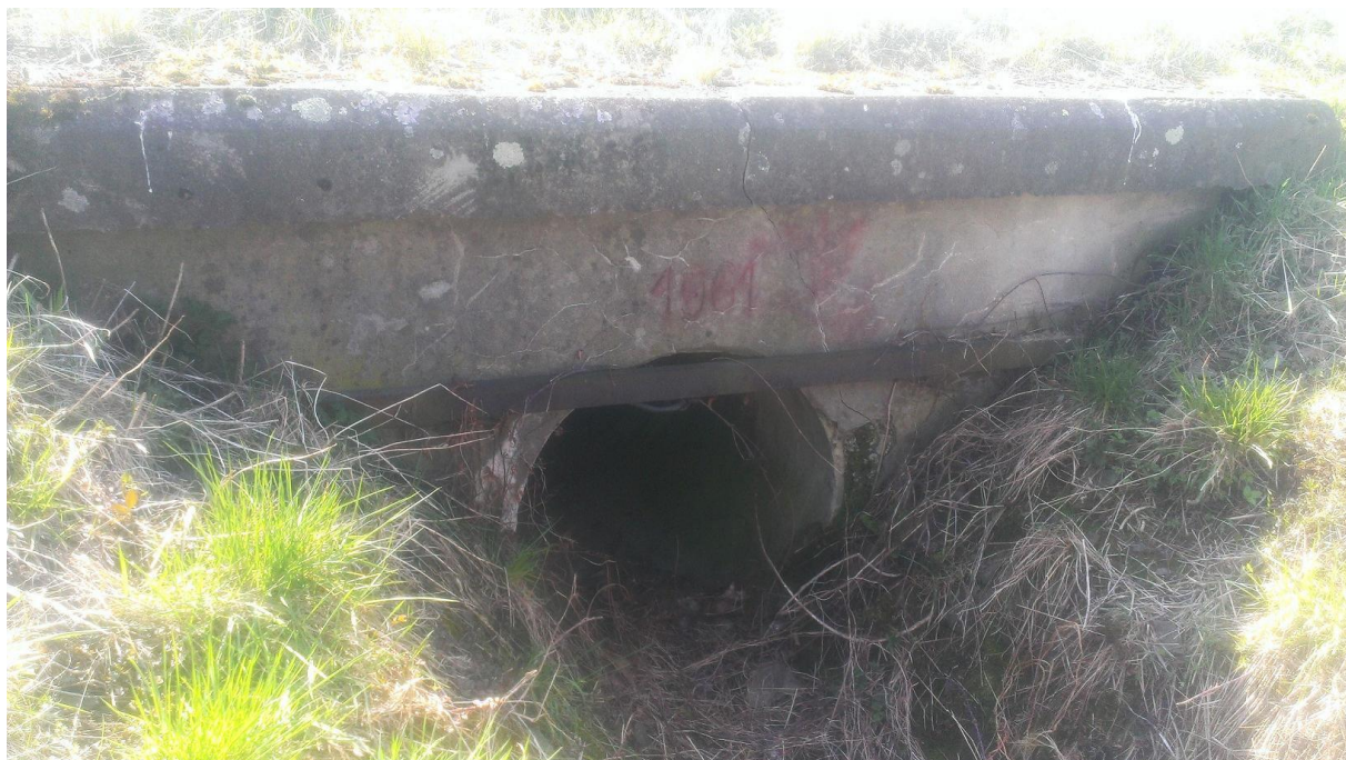
Obrázek 3 Trubní propustek km 35.996
