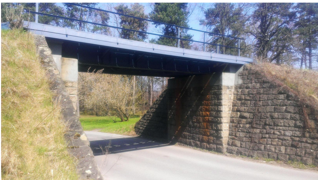
Obrázek 6 Ocelový železniční most km 36.635 (nebude snášen)
