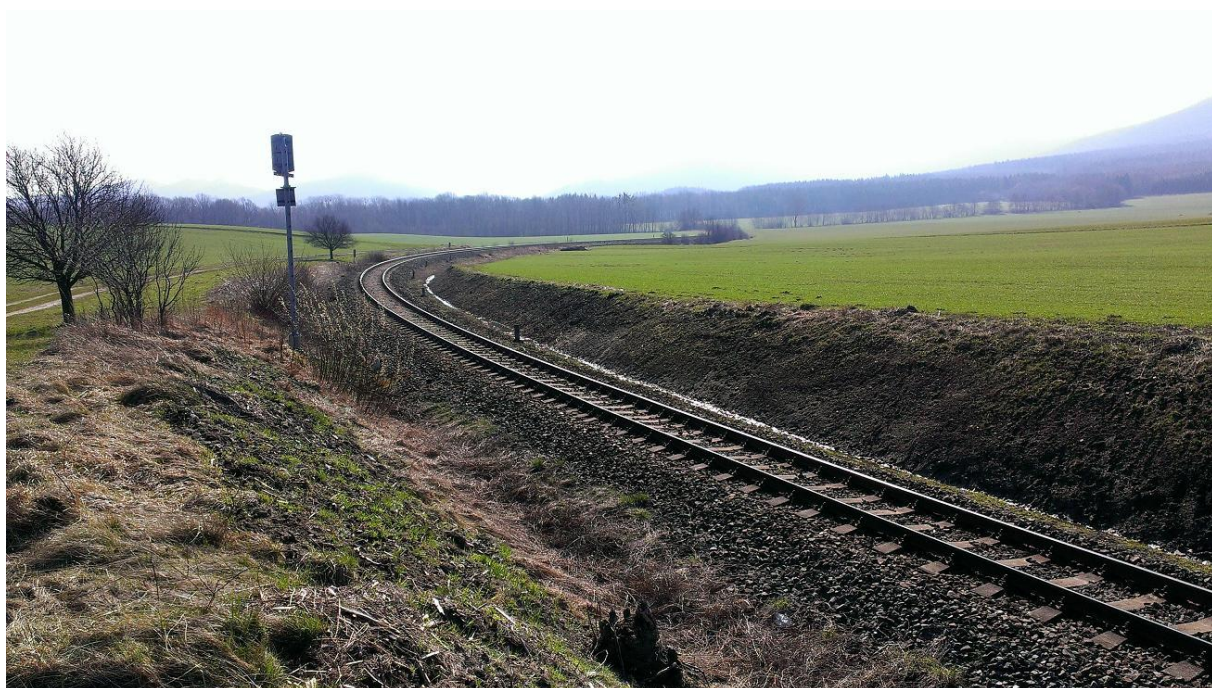
Obrázek 30 Pravotočivý oblouk R 275 m, zářez km 43.500
