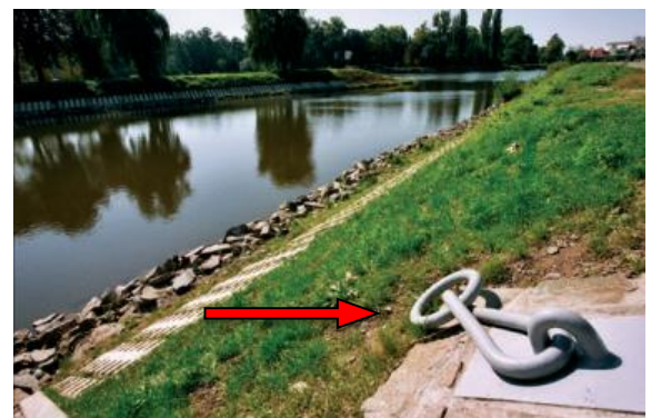
Obrázek č. 8 - Vyvazovací prvek „vázací kruh“ [8]
