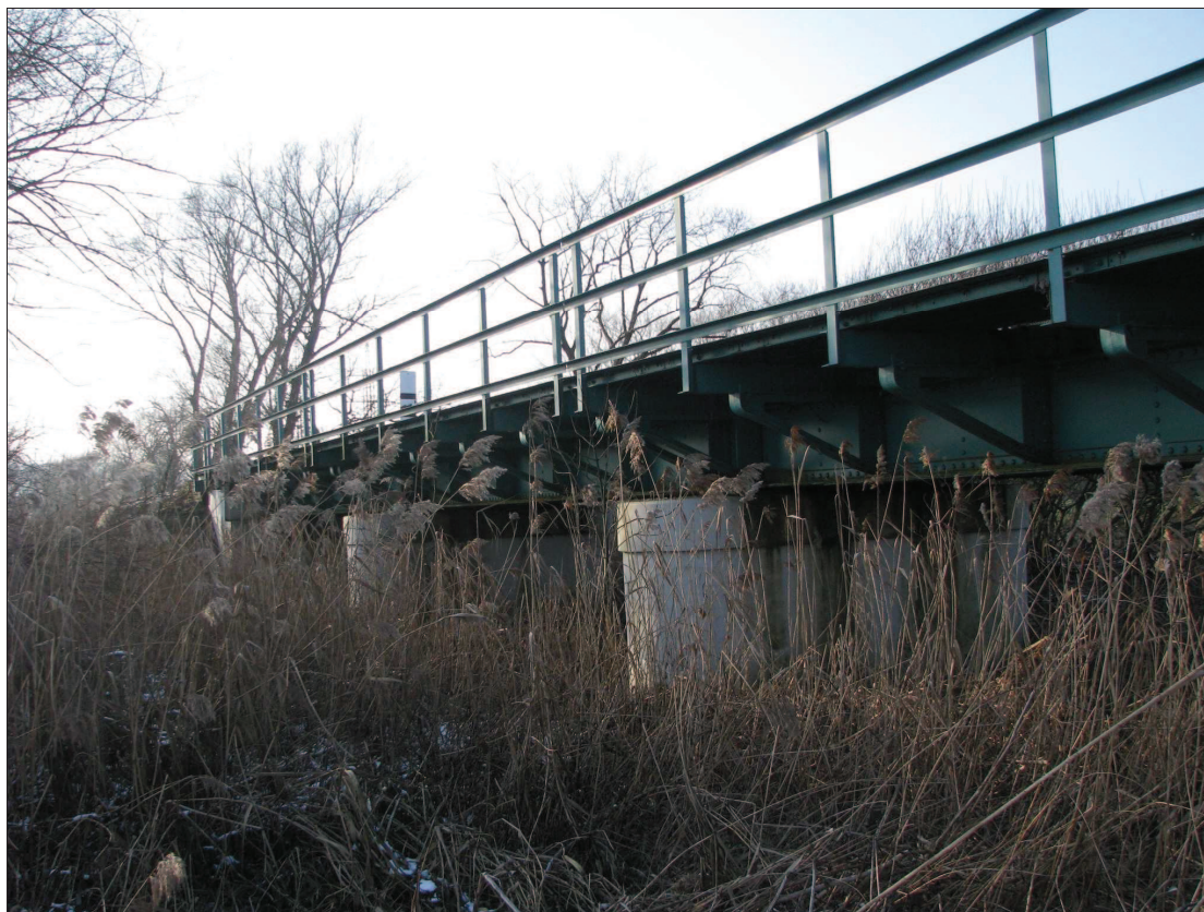
Obrázek 10 - Pohled na objekt zleva
