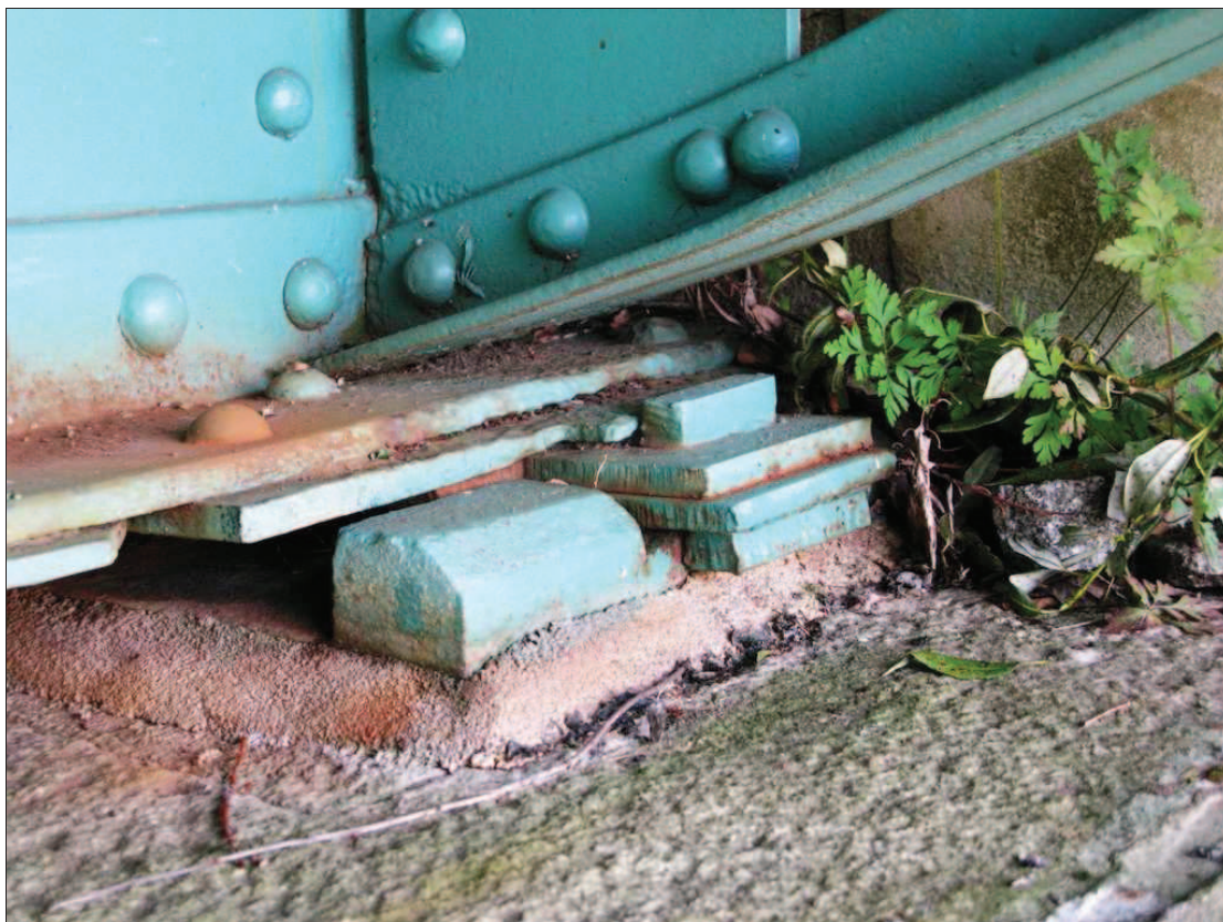
Obrázek 14 - Příklad pevného uložení na opěře O 01 vlevo
