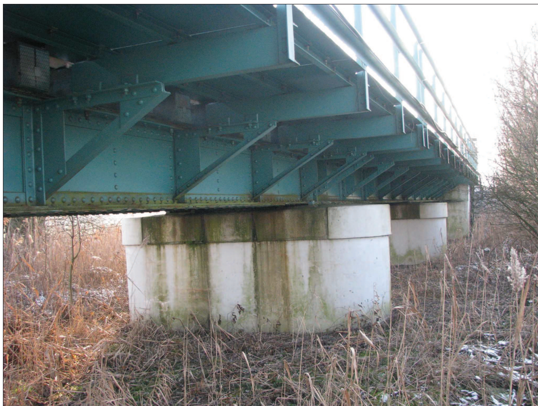
Obrázek 9 - Pohled na objekt zprava
