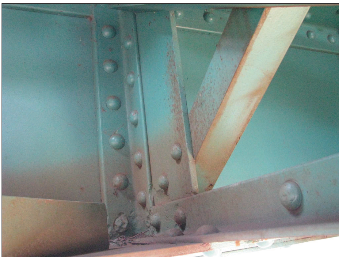
Obrázek 17 - Detail napojení příčného ztužení na hlavní nosník
