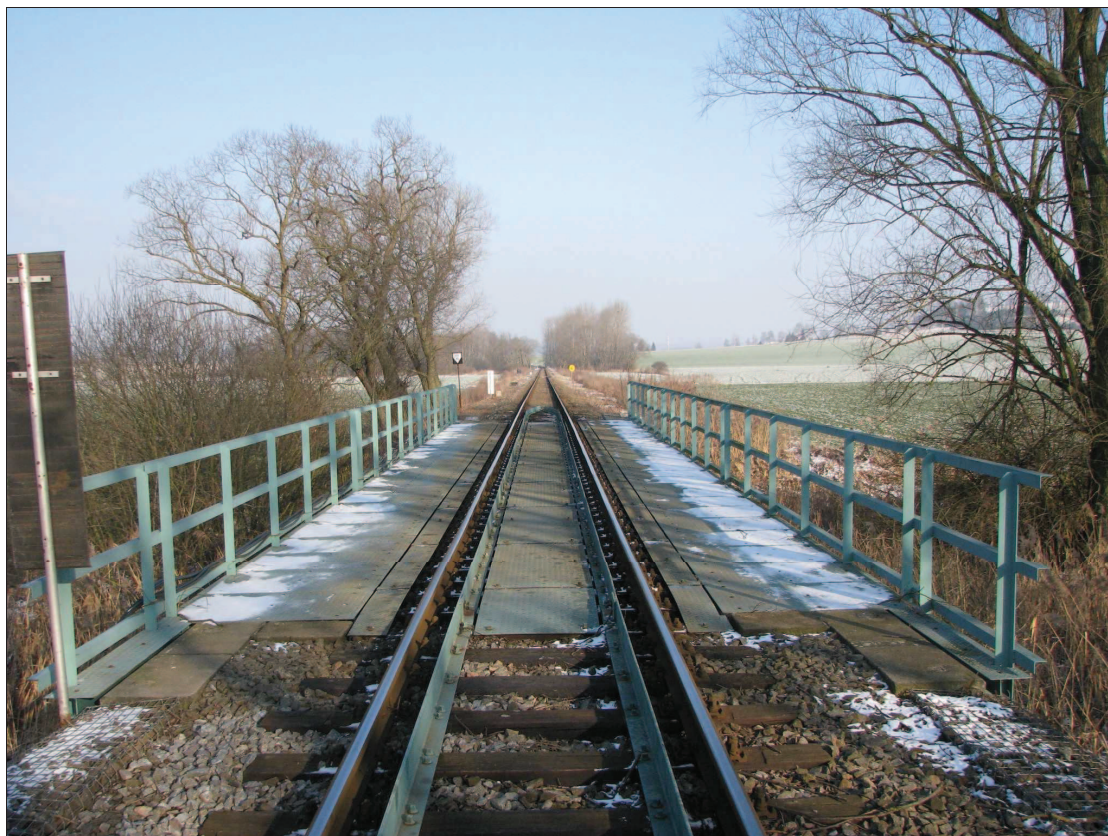
Obrázek 8 - Pohled proti směru staničení
