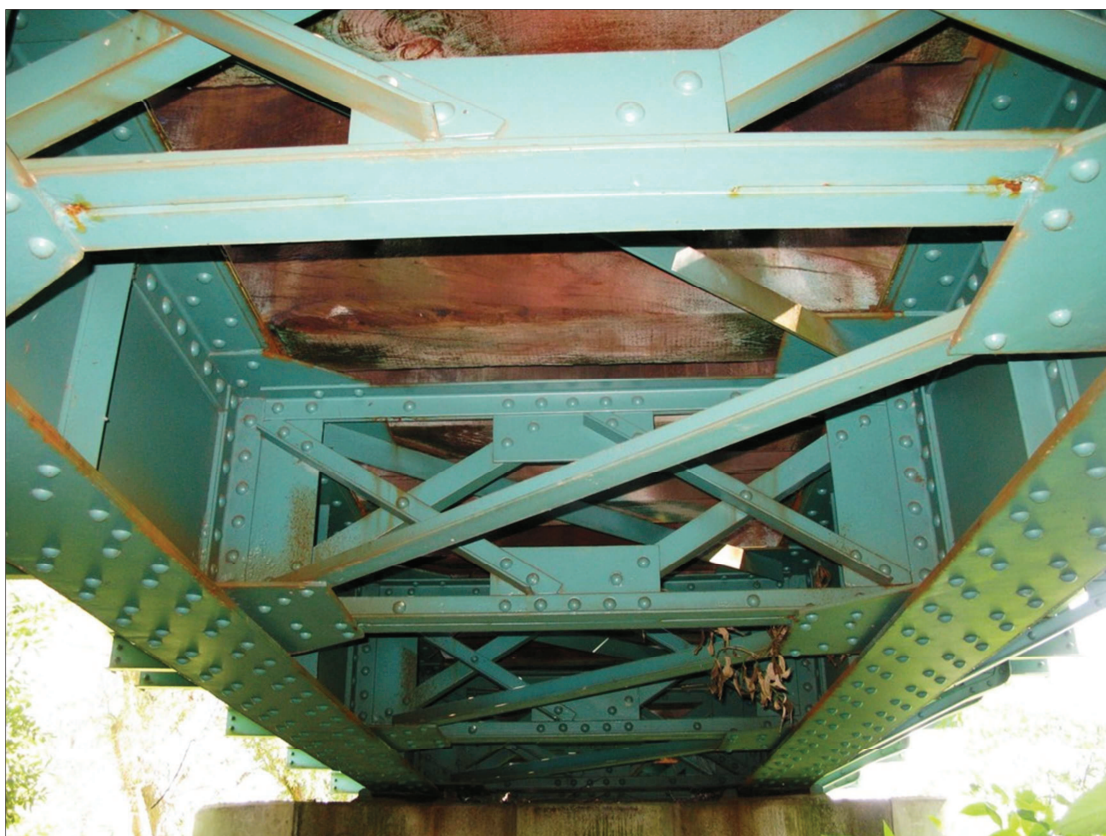
Obrázek 16 - Pohled spodní část konstrukce
