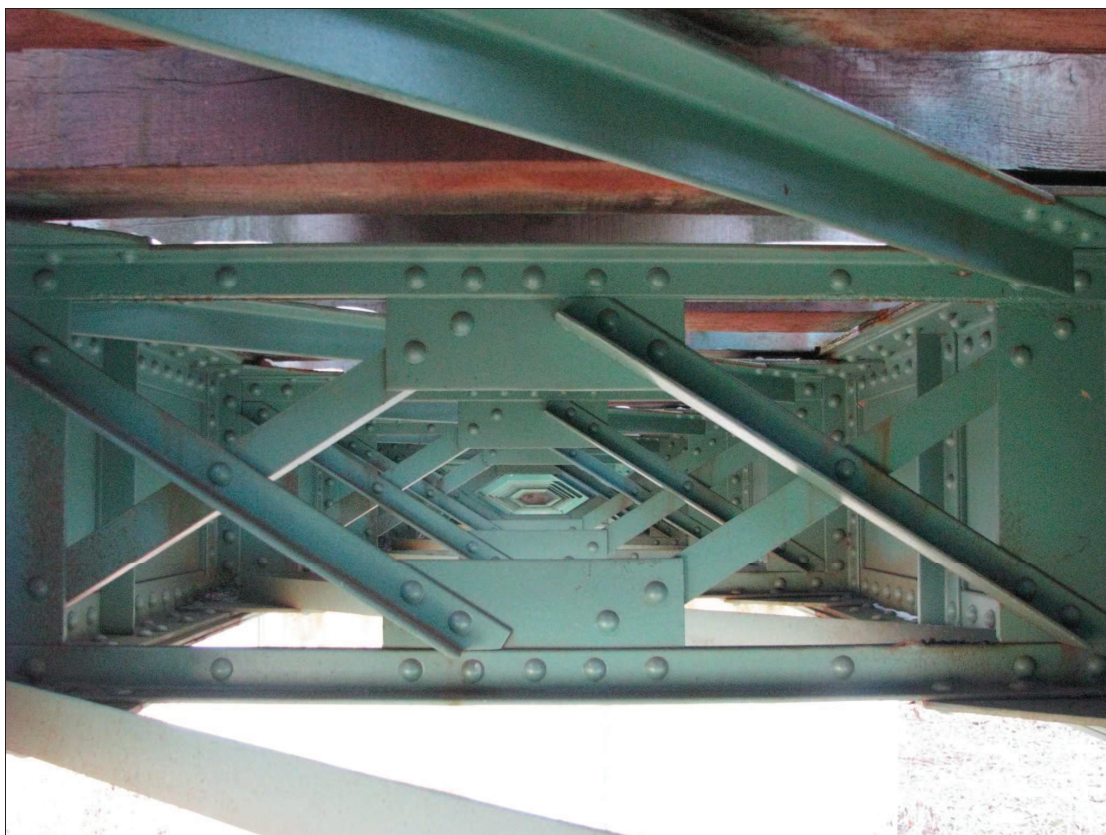
Obrázek 13 - Pohled vnitřní část konstrukce
