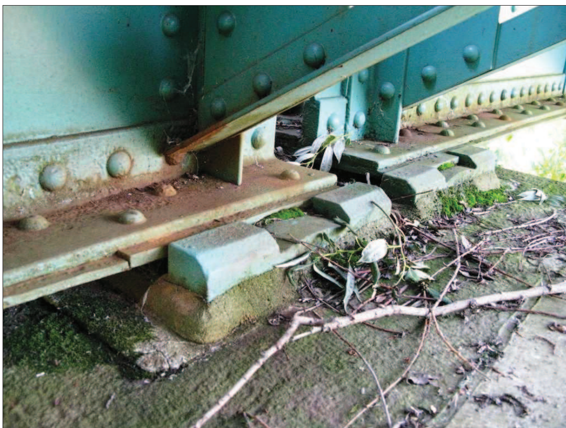
Obrázek 15 - Příklad pohyblivého a pevného uložení konstrukcí na pilíři
