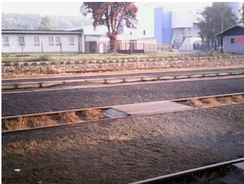
Obrázek 5: Pohled na nástupiště
