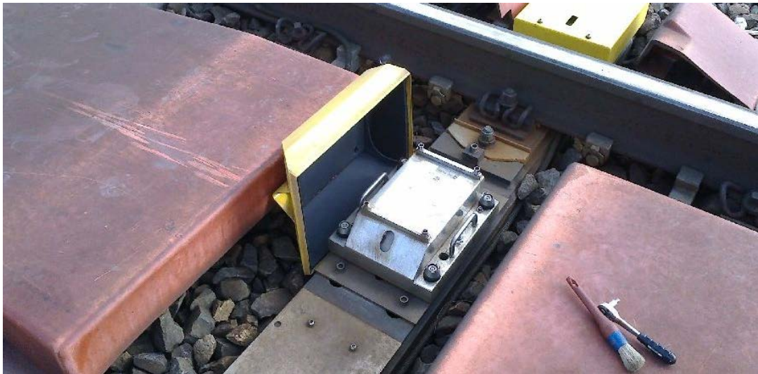
Obr. 12 Snímač IHO systému PHOENIX se sejmутým vrchním krytem
