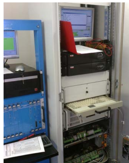
Obr. 4 Vybavení základní jednotky (vlevo panel měření IPK, vpravo panely IHO a IHL)
