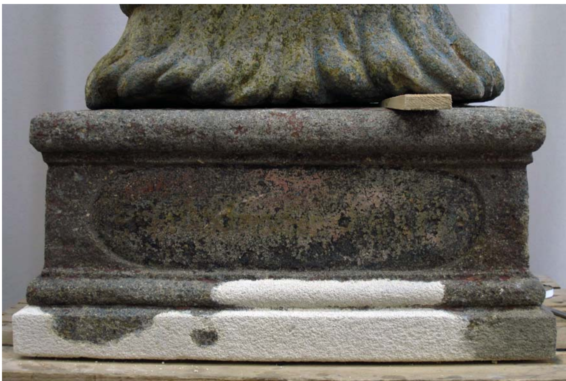
Foto 41 podstavec s nápisovou kartuší; stav po odkryvu a vytmelení degradovaných partií v minerálním tmelu z drceného kamene a bílého cementu
