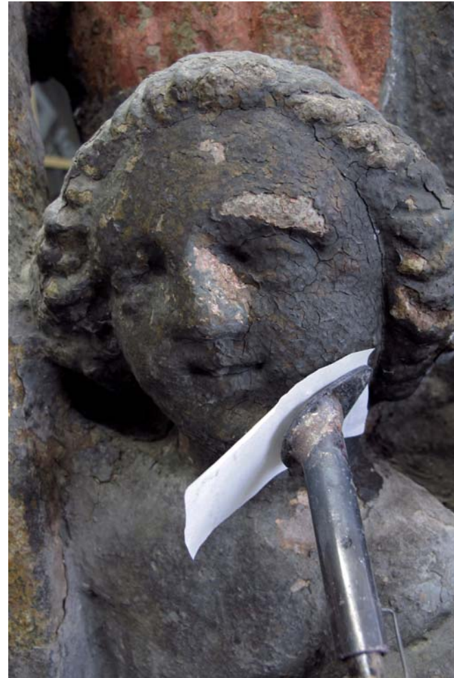
Foto 15 průběh zažehlování krakelovaných souvrství po injektáži
